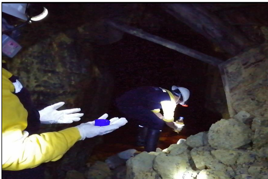
Foto 1. Monitoreo en el interior de la mina
