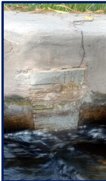
**Ilustración 4.11.** Caudal del canal de alimentación 17-12-2022  $Q=144000$  l/h
