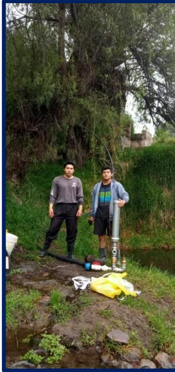
**Ilustración 4.18.** Bomba de ariete instalada en campo.
