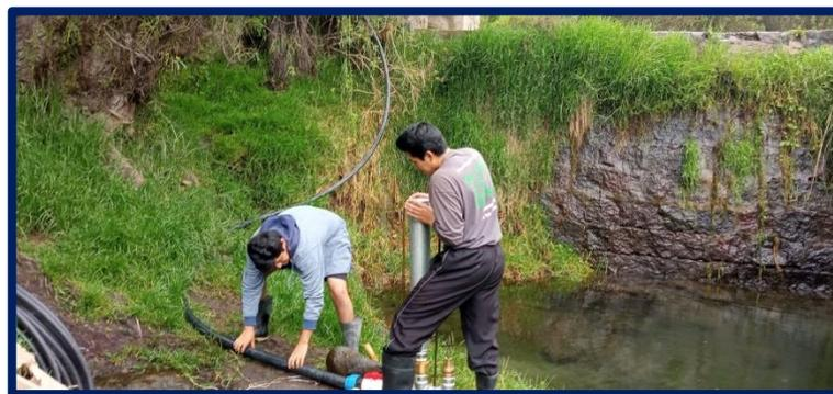
**Ilustración 4.14.** Instalación de la tubería de suministro en campo.
