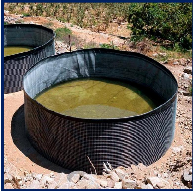
**Ilustración 4.1.** Imagen referencial Geotanque de geomembrana D=2.10m
