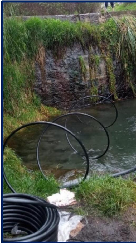
***Ilustración 4.16.*** Instalación de la tubería de descarga en campo.
