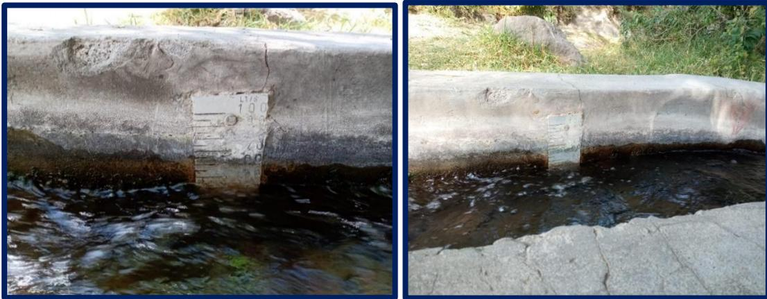
**Ilustración 4.13.** Caudal del canal de alimentación 08-07-2023  $Q=144000$  l/h.
