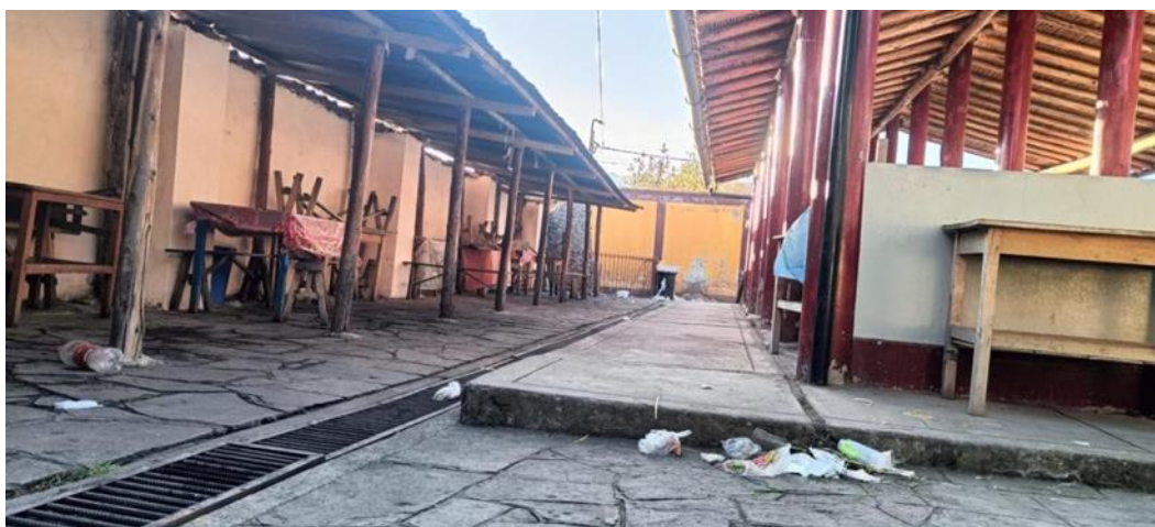
Figura 2. Fase de diagnóstico inicial interiores del Mercado Distrital de Chinchaypujio.
