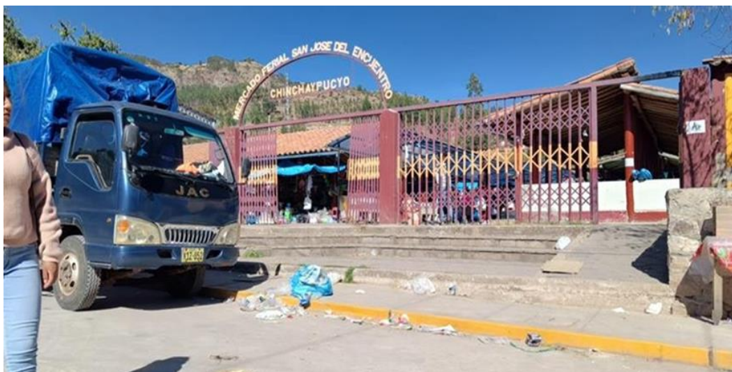
Figura 14. Fase de diagnóstico inicial del Mercado Distrital de Chinchaypujio.
