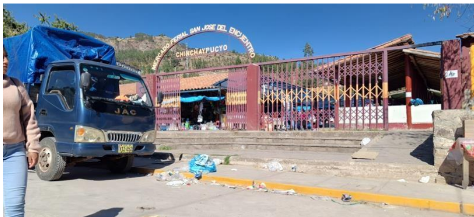
Figura 1. Fase de diagnóstico inicial del Mercado Distrital de Chinchaypujio.
