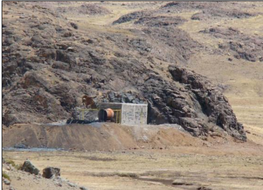
Figura 13. Raise Borer, principal extractor en el circuito Marión Tomada de Minera Arcata
