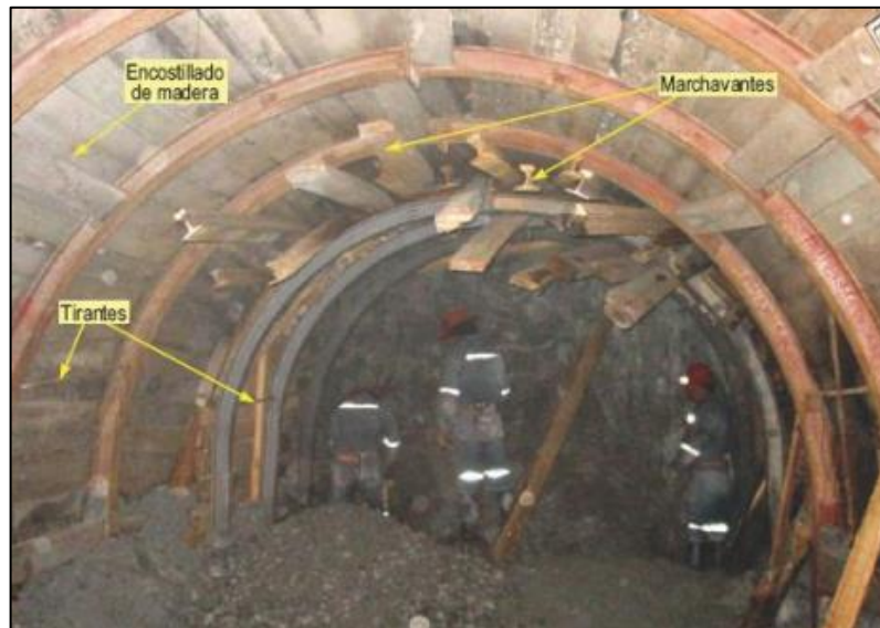
Figura 10. Esquema del armado de un cuadro Tomada de Mina Arcata
