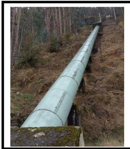
Figura 5. *Fotografía inédita de la tubería de presión perteneciente a la Central Hidroeléctrica de Ingenio.*
