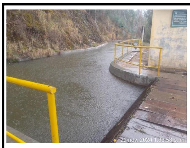
Figura 3. Fotografía inédita de la Cámara de carga perteneciente a la minicentral hidroeléctrica Ingenio
