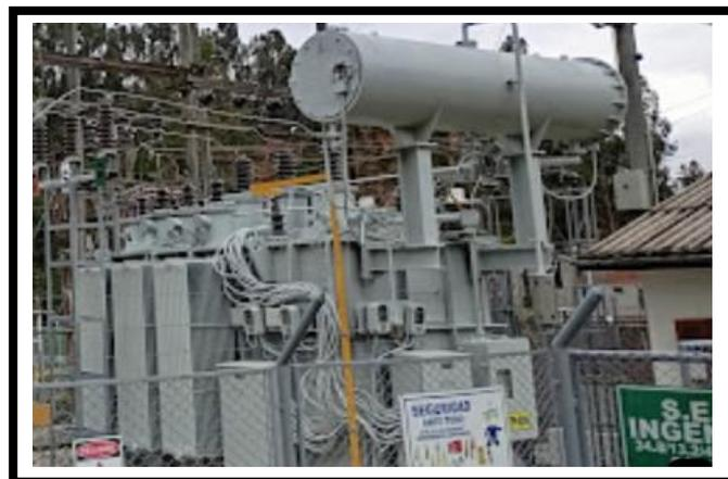
Figura 10. *Fotografía inédita del transformador de potencia perteneciente a la MCH de Ingenio.*
