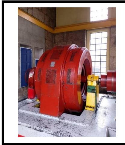
Figura 9. *Fotografía inédita del generador síncrono trifásico perteneciente a la perteneciente a la Central Hidroeléctrica de Ingenio.*
