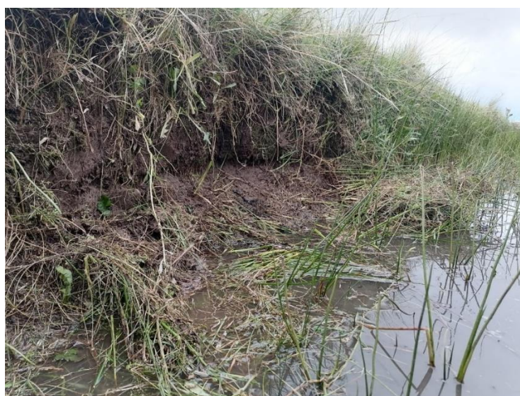
Figura 5. Daños debido a la erosión (para ello se limpió la vegetación).
