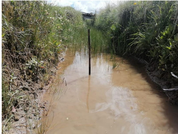
Figura 6. Se colocó una sonda en forma de estaca para poder medir la altura del material acumulado.
