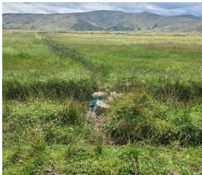
Figura 4. Toma lateral conformada por plásticos y champas.
