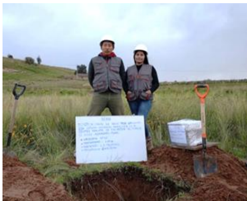
Figura 25. En esta fotografía se puede observar la excavación de la calicata 1 a una profundidad de 1.50m.
