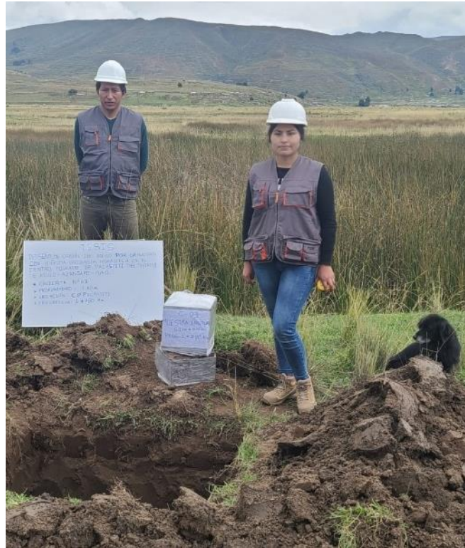
Figura 27. En la imagen se puede observar la excavación de la calicata 3 y la extracción de la muestra inalterada para el ensayo de corte directo.
