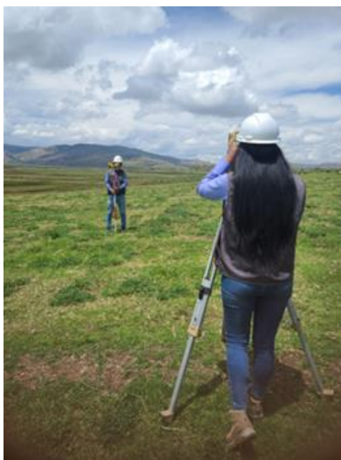
Figura 14. En la imagen se puede apreciar el levantamiento topográfico realizado en campo.
