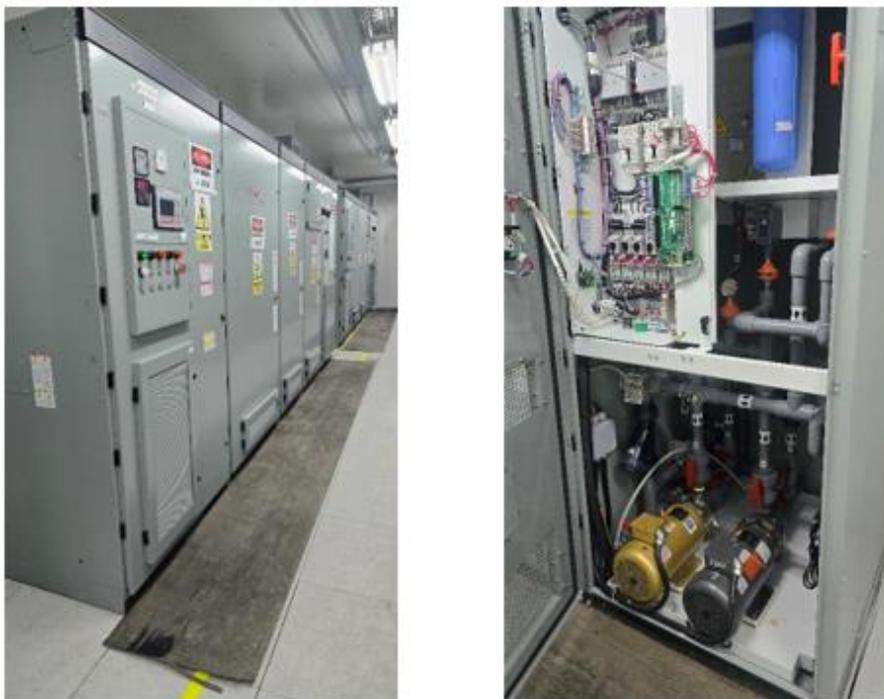
*Figura 7. Sistema de enfriamiento de lo variadores de velocidad de las bombas GEHO*
