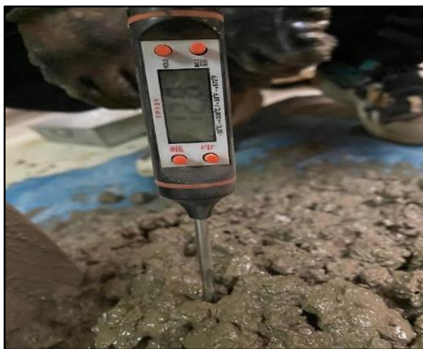
Figura 59. Temperatura del concreto encauchado (Patrón)
