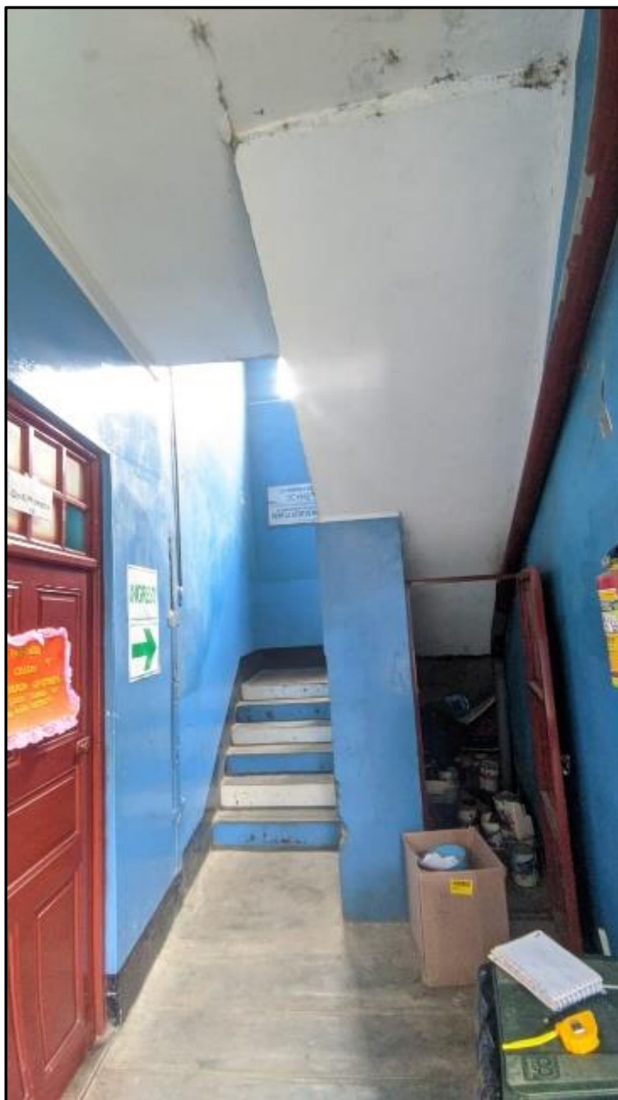
Fotografía 19: Circulación interior de la institución educativa.
