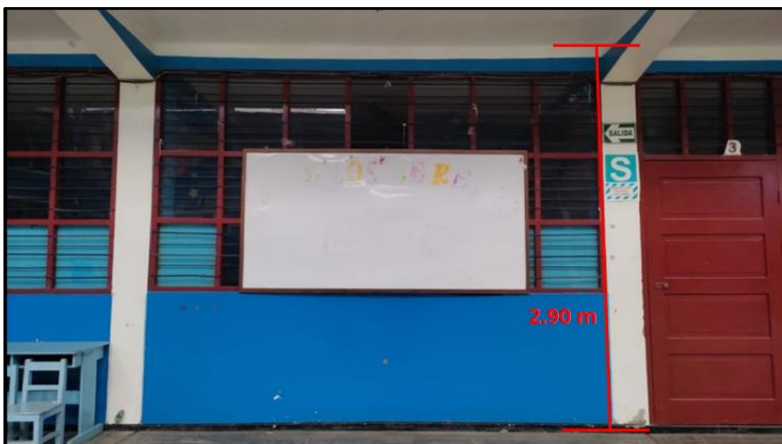
Gráfico 10. Altura de techo de la I.E.
