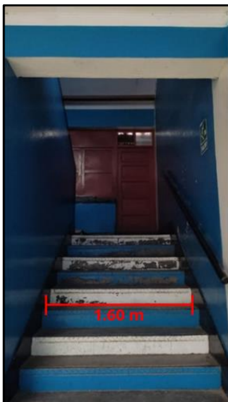
Fotografía 5. Escaleras del pabellón C - tramo 1.
