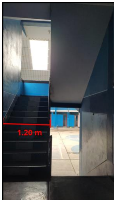
Fotografía 3. Escaleras del pabellón B.
