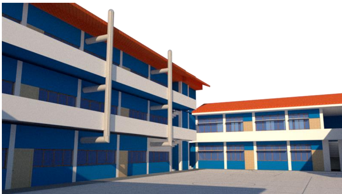
Gráfico 40: Sistema de estantes de luz para el pabellón C de la I.E.
