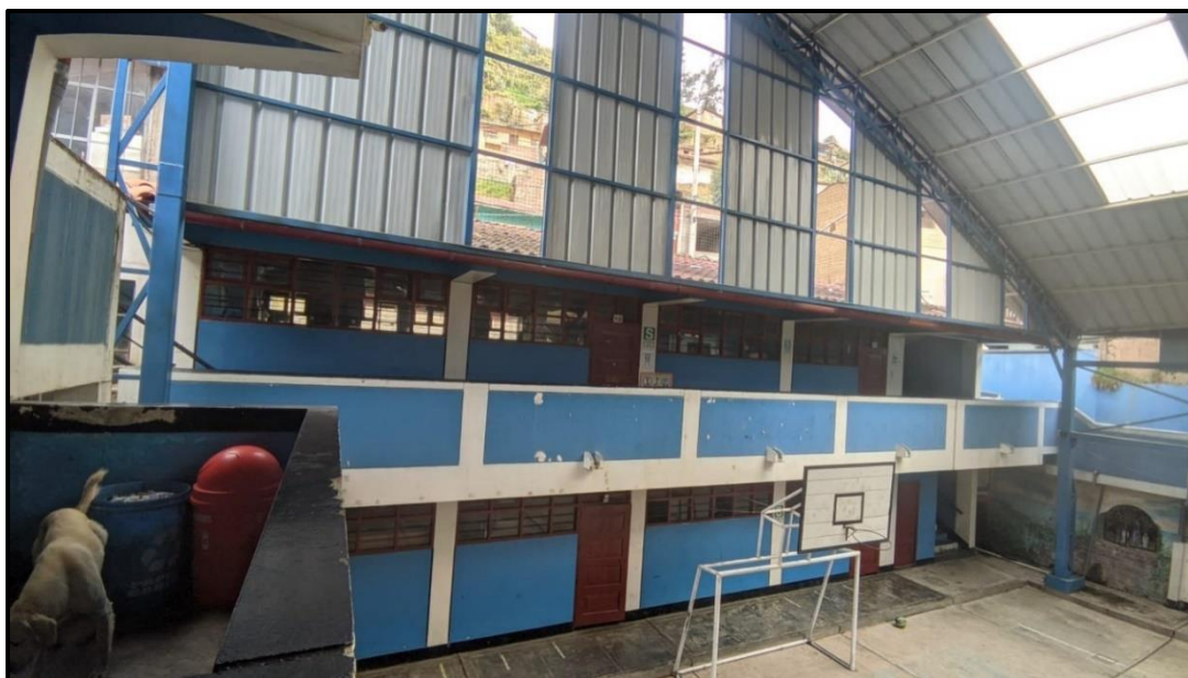
Descripción: Fotografía que muestra el pabellón C de la institución educativa.
