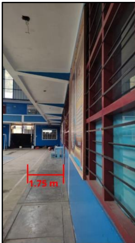
Fotografía 8. Circulación del primer piso del pabellón B.
