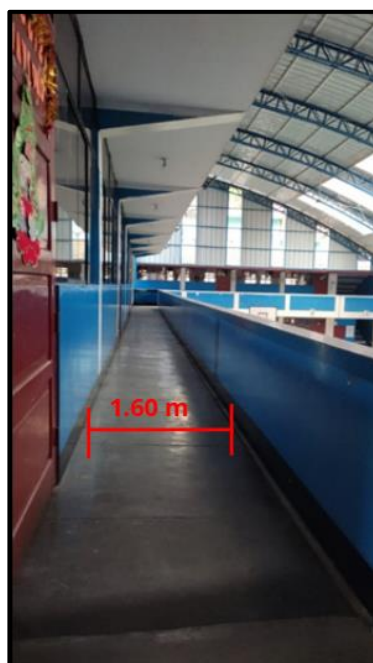
Fotografía 7. Circulación del segundo piso del pabellón B.
