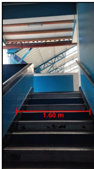
Fotografía 4. Escaleras del pabellón C - tramo 2.
