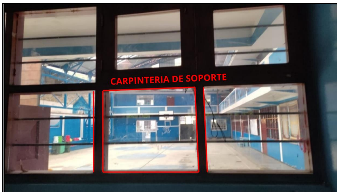
Gráfico 14. Tipo de ventana y carpintería de las aulas de la I.E.
