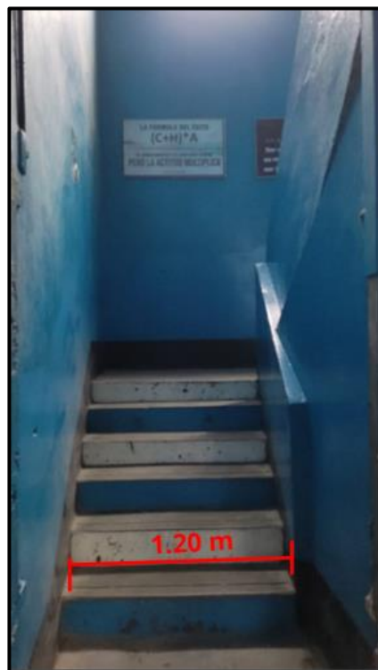
Fotografía 2. Escaleras del pabellón B.
