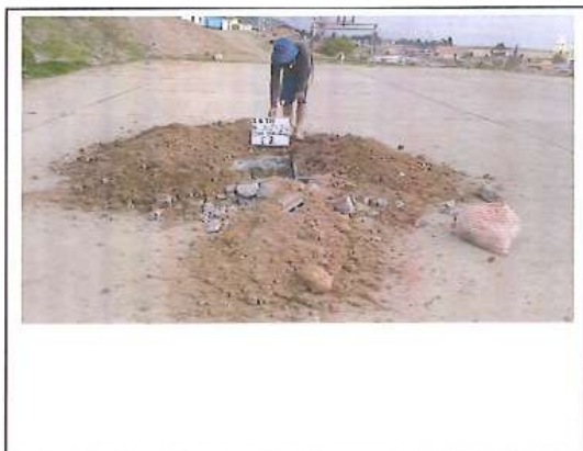
FOTO. 05.- EXCAVACION, C-2, I.E.I. N° 30244 – JUANA GUERRA CHAVEZ.
