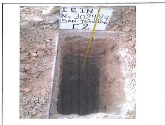
FOTO. 08.- PROFUNDIDAD DE EXCAVACION, 3.00 mts, C-2, I.E.I. N° 30244 – JUANA GUERRA CHAVEZ.
