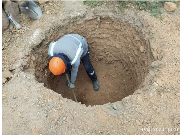
Figura 3. Excavación de calicatas
