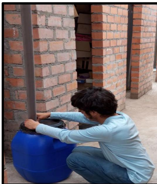
**Imagen 7.** Instalación del recipiente para la captación del agua de lluvia
