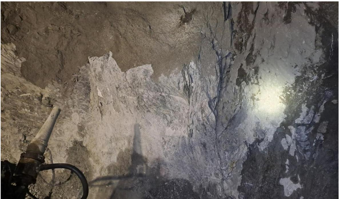
**Figura 16. Deformación de las filitas.**
