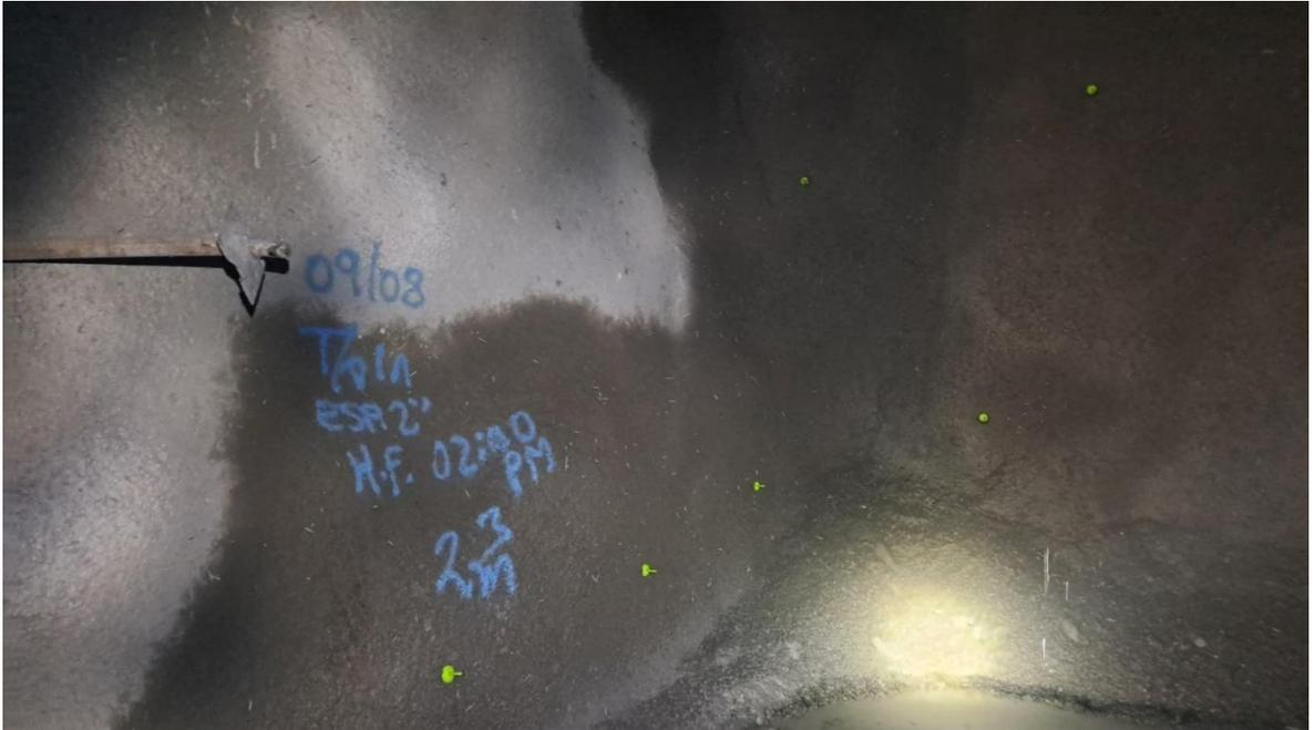
**Figura 15. Rehabilitación secundaria (bandas de shotcrete + cable bolting).**
