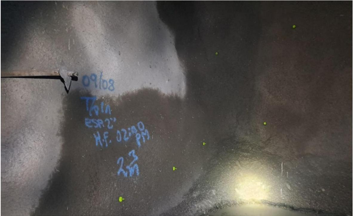
**Figura 15. Rehabilitación secundaria (bandas de shotcrete + cable bolting).**
