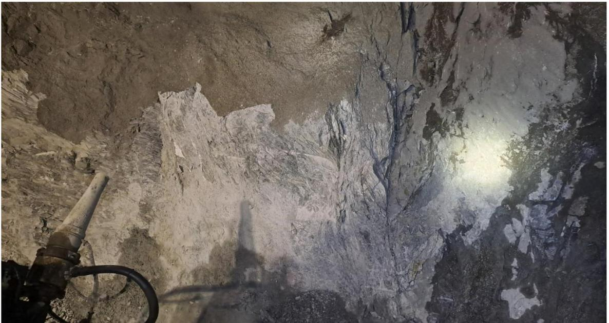
**Figura 16. Deformación de las filitas.**
