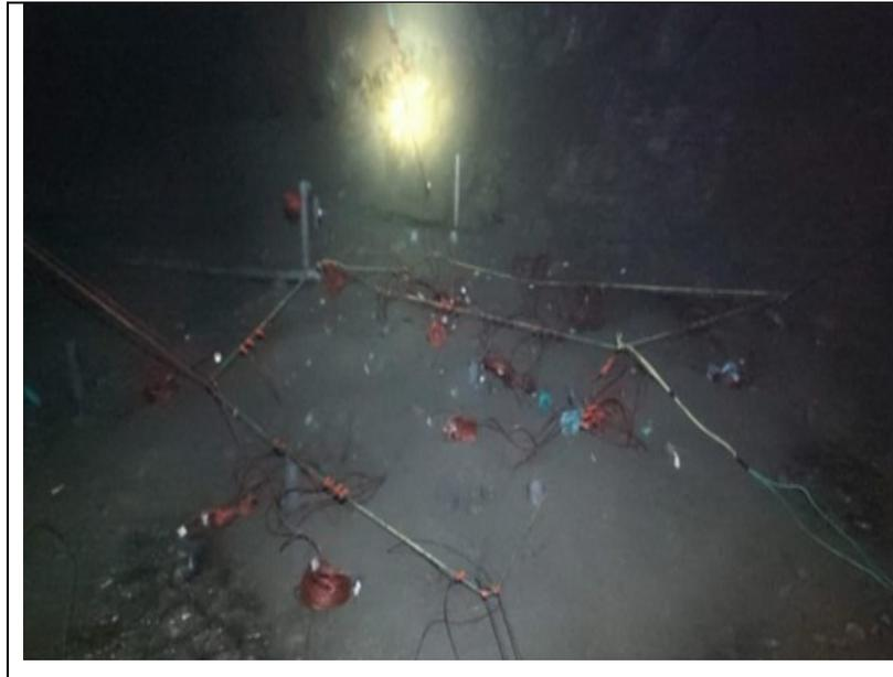
*Figura 14. Carguío con explosivo bombeable Subtek<sup>TM</sup> Charge<sup>TM</sup> en el tajeo 6432 – 1, nivel 3990 en la unidad minera Uchucchacua*
