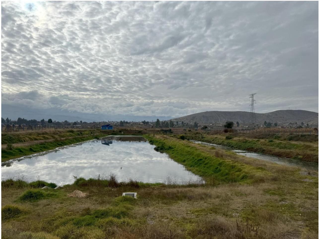
Figura 9. Poza de oxidación del Centro Poblado Huamanmarca.
