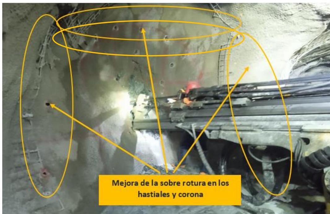
*Figura 15. Situación óptima - análisis de la sobrerotura en el Subnivel 75-2 este*
