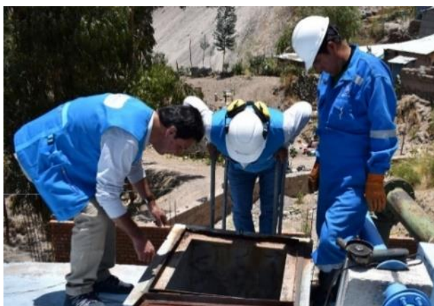
Figura 3. Limpieza y desinfección de reservorio.
