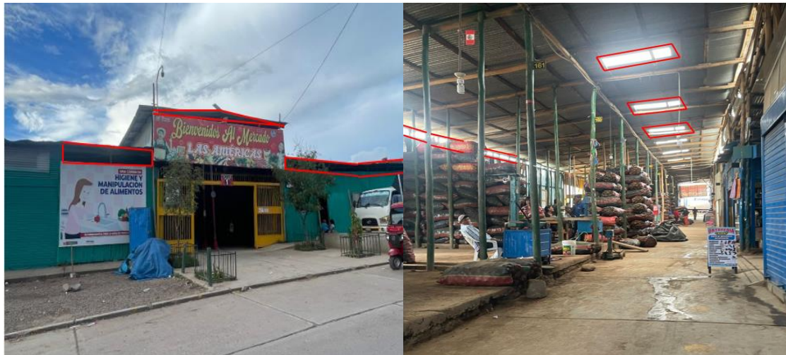
Figura 21. Deficiencias en ventilación e iluminación del mercado.
