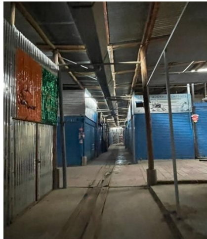
Figura 42. Pasadizo interior con canaleta.
