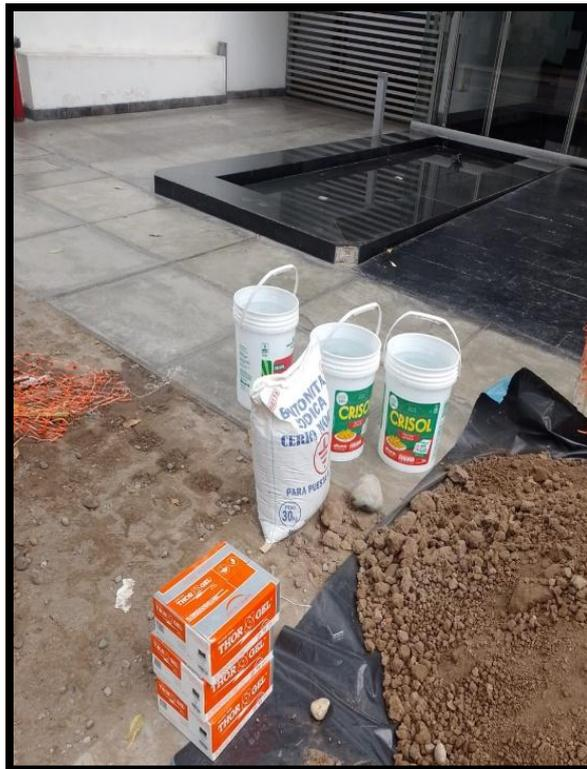
*Figura 23. Dosificación de Thor-Gel y bentonita*
