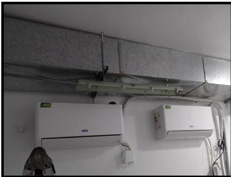
*Figura 33. Instalación de evaporizadores tipo Split*
