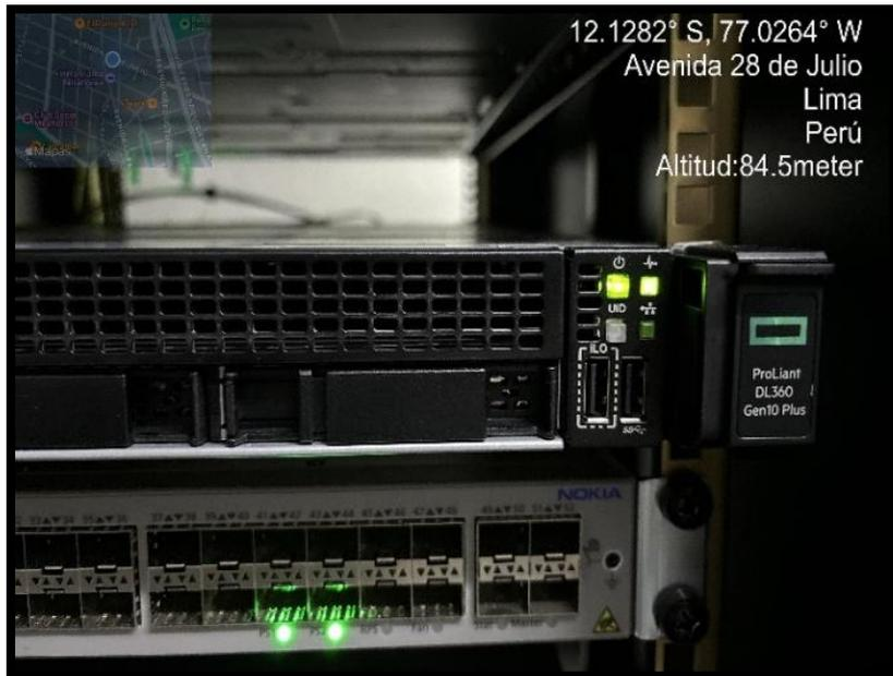
*Figura 79. Pruebas de encendido de servidores*
