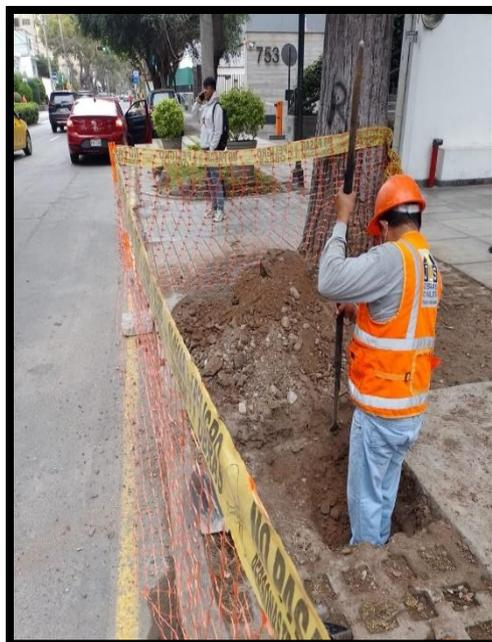
**Figura 21. Excavación y sondeo para el pozo a tierra**
