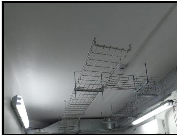
**Figura 37. Bandeja porta cables instalado**
