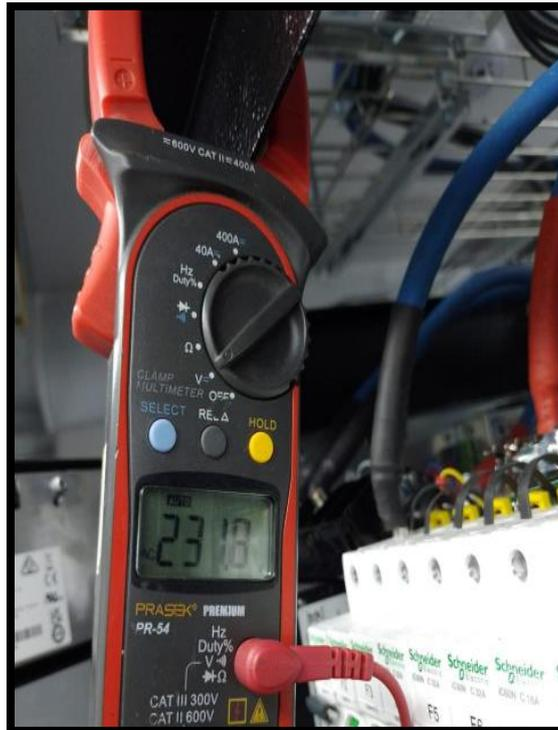
*Figura 45. Verificación de tensión de llegada en AC al Power Core*
