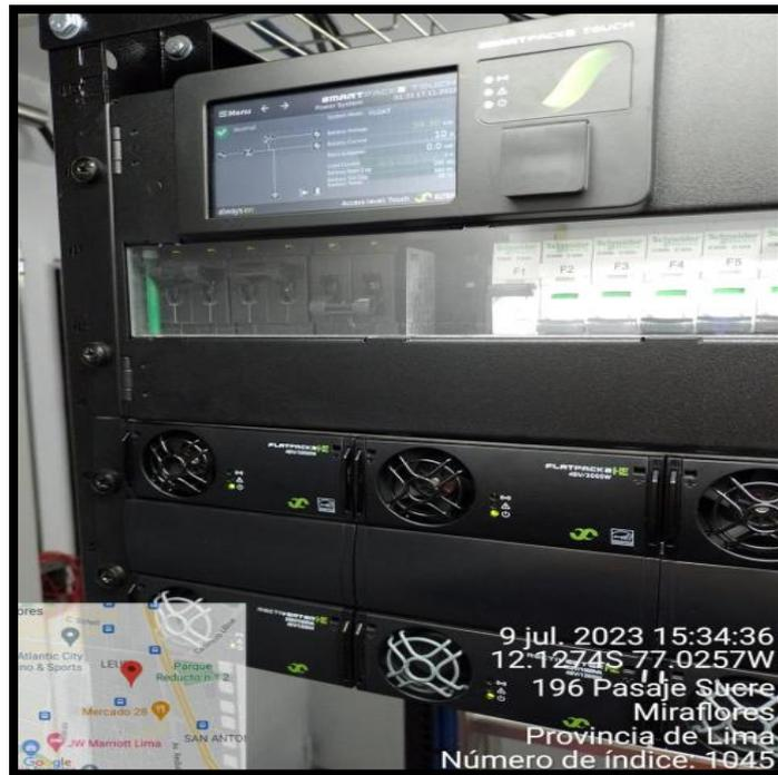
*Figura 47. Energización e instalación de módulos rectificadores y rectiverter*
