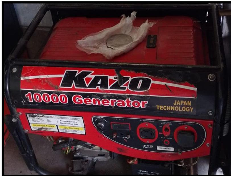
*Figura 88. Grupo electrógeno Kazo de 10Kw*
