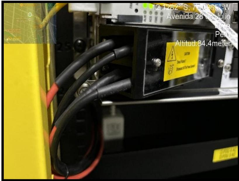
**Figura 73. Cables de energía de la fuente A y B del equipo OLT Nokia 7360**
