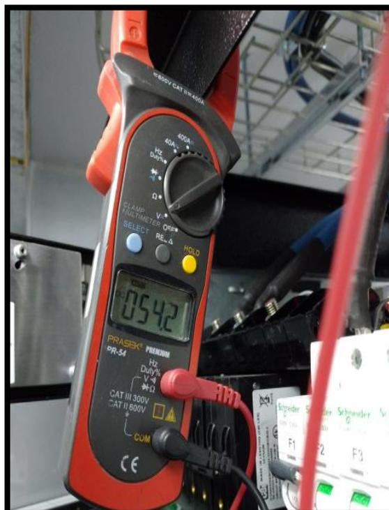
*Figura 46. Verificación de tensión de llegada en DC al Power Core*
