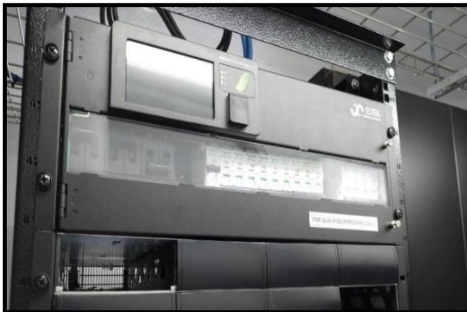
*Figura 42. Rackeado e instalación del Power Core*
