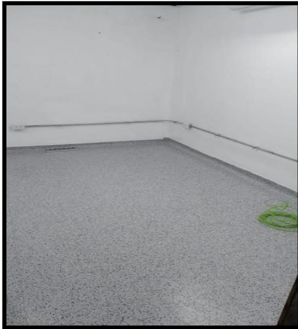
**Figura 20. Piso vinílico antiestático instalado**
