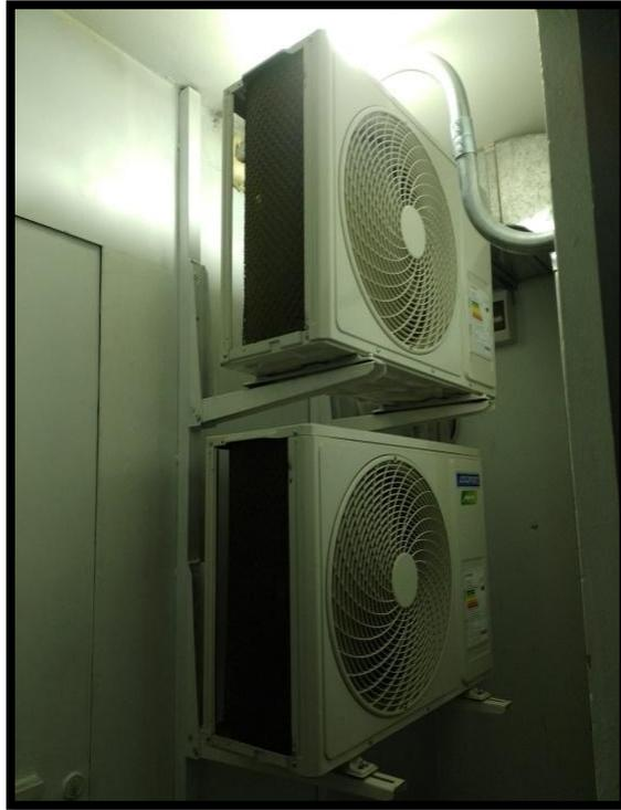
**Figura 36. Posicionamiento final de condensadores**
