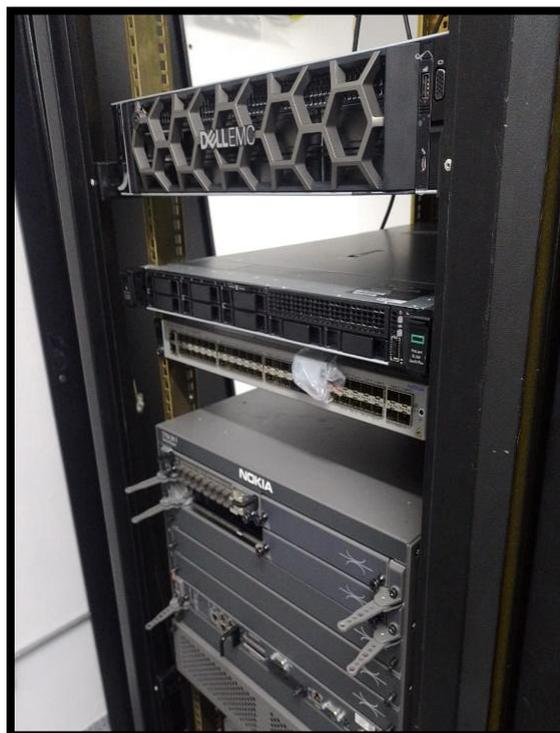
*Figura 76. Servidores y equipo Switch rackeados*
