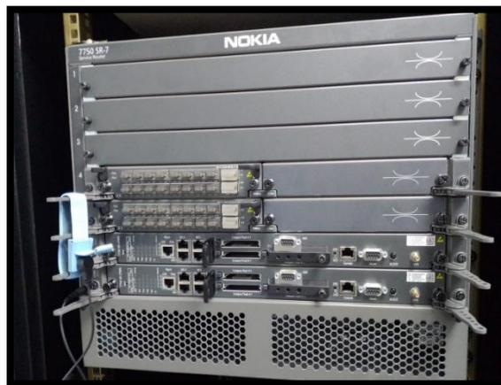
*Figura 67. Equipo Router DWDM Nokia 7750 SR-7 rackeado*
