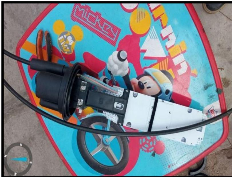
*Figura 60. Instalación del kit de empalme*
