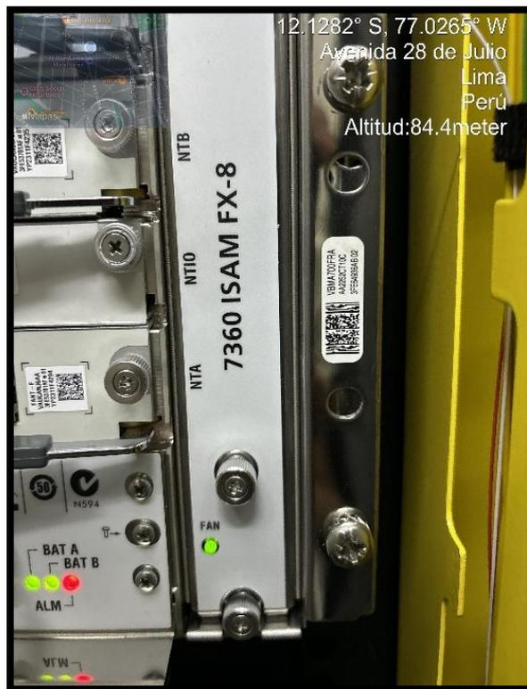
**Figura 74. Pruebas de encendido del equipo OLT Nokia 7360 ISAM FX-8**
