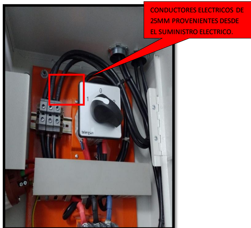
Figura 31. Conexión del tablero
