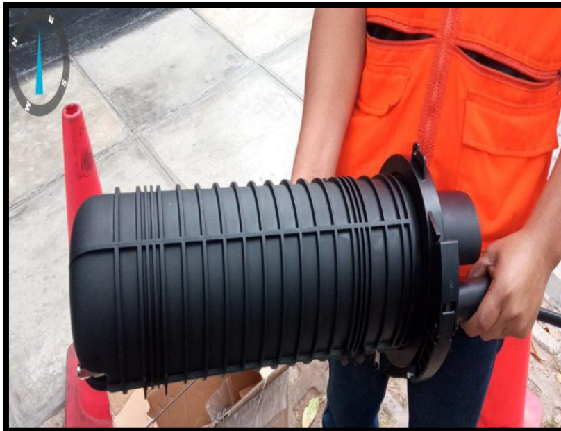
Figura 59. Verificación del kit de empalme tipo domo de 96 hilos
