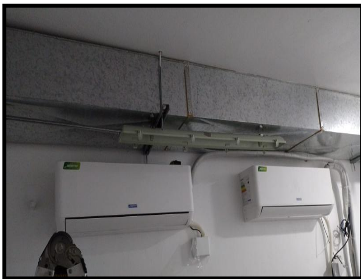
Figura 33. Instalación de evaporizadores tipo Split
