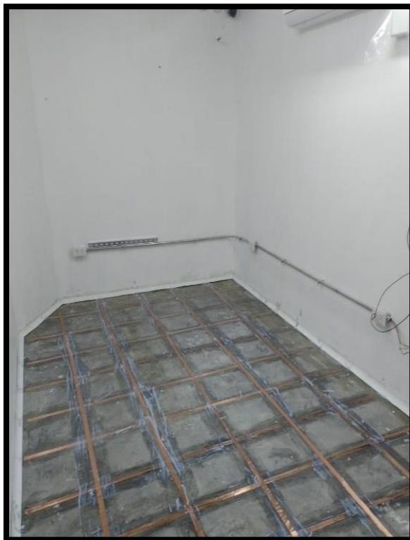
Figura 18. Pegado y tendido de la lámina de cobre y del perfil sanitario
