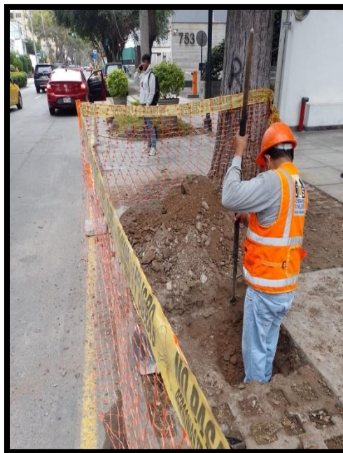
Figura 21. Excavación y sondeo para el pozo a tierra
