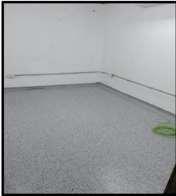
Figura 20. Piso vinílico antiestático instalado
