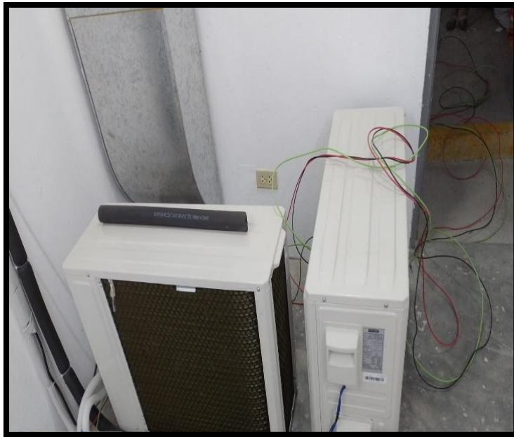
Figura 34. Instalación de condensadores
