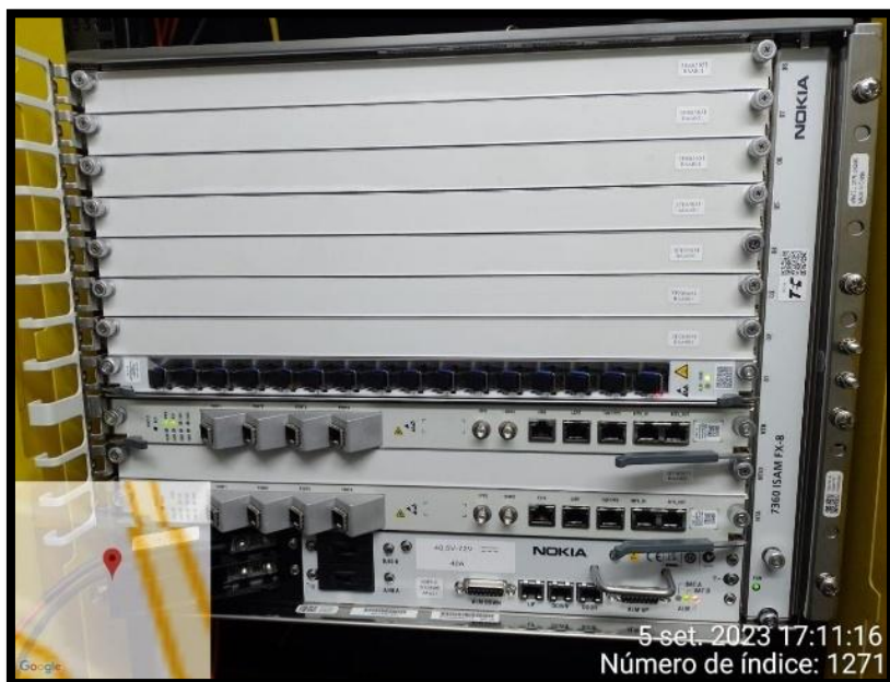
Figura 72. Instalación de cables de energía del equipo OLT Nokia 7360 ISAM FX-8
