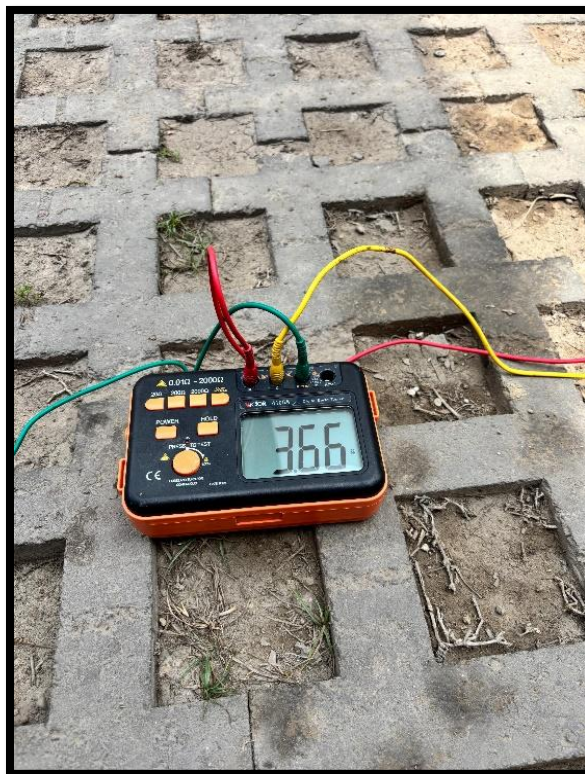
Figura 25. Medición de ohmiaje del pozo a tierra
