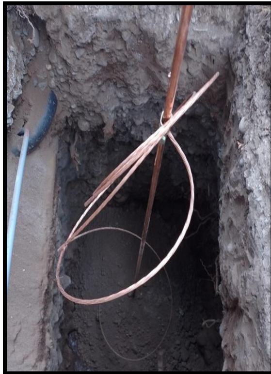
Figura 24. Colocación de varilla de copperweld junto al cable de cobre desnudo envolvente
