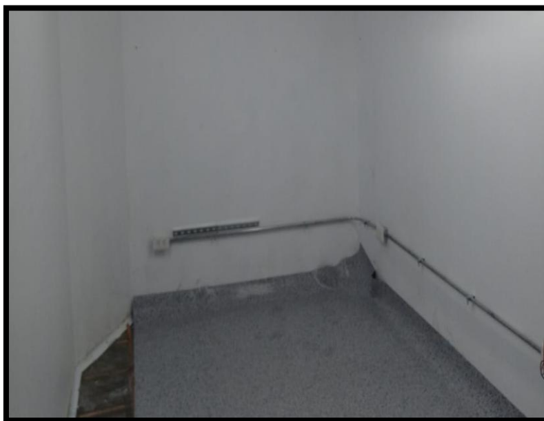
Figura 19. Tendido y pegado del piso vinílico antiestático
