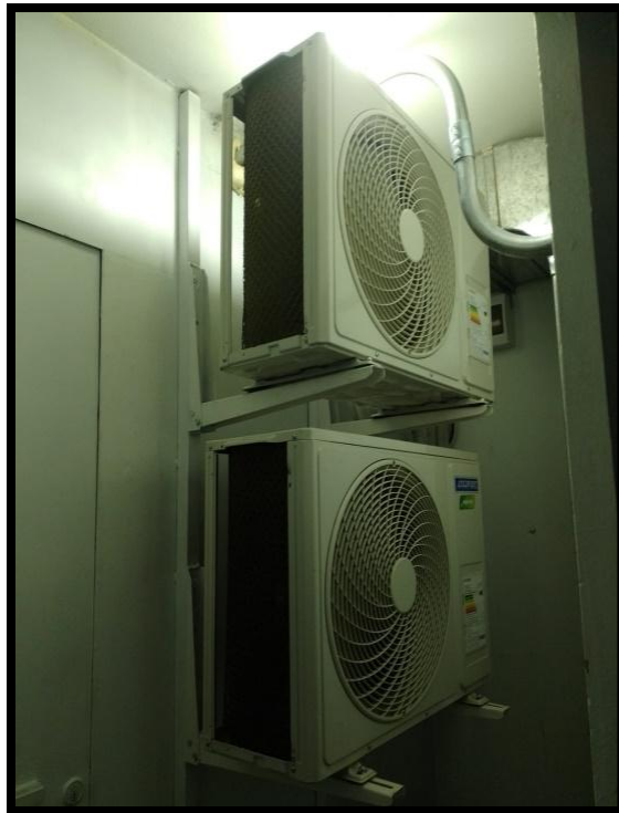
Figura 36. Posicionamiento final de condensadores
