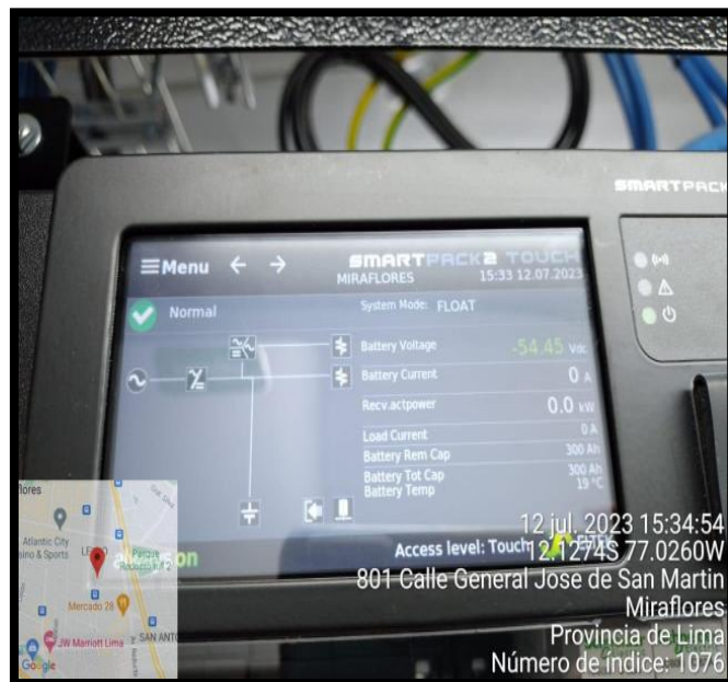
Figura 52. Verificación de configuración en pantalla del Power Core
