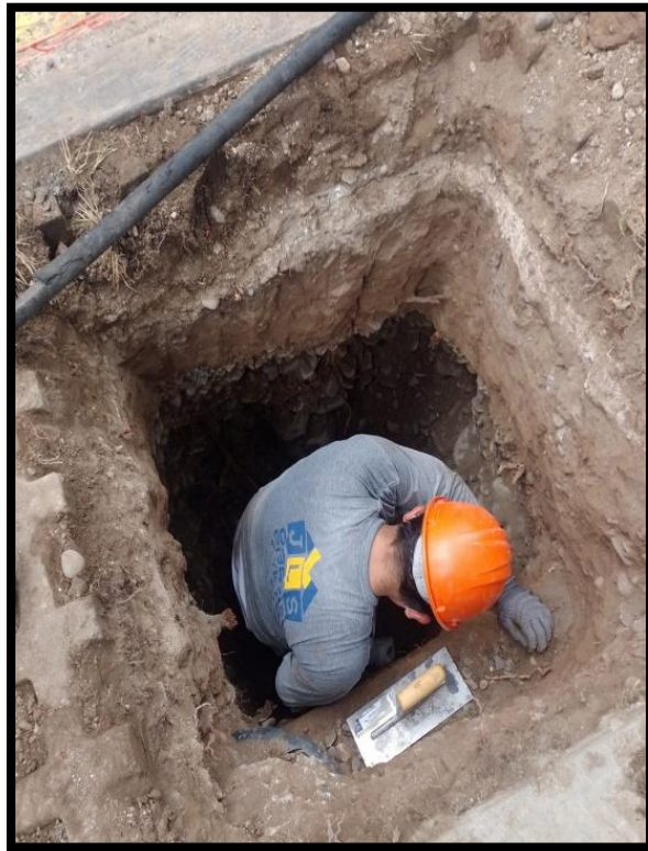
Figura 22. Apisonamiento del pozo
