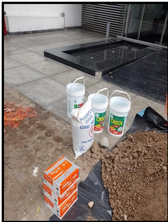
Figura 23. Dosificación de Thor-Gel y bentonita
