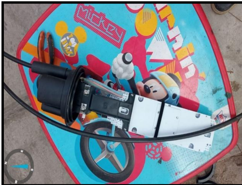
Figura 60. Instalación del kit de empalme
