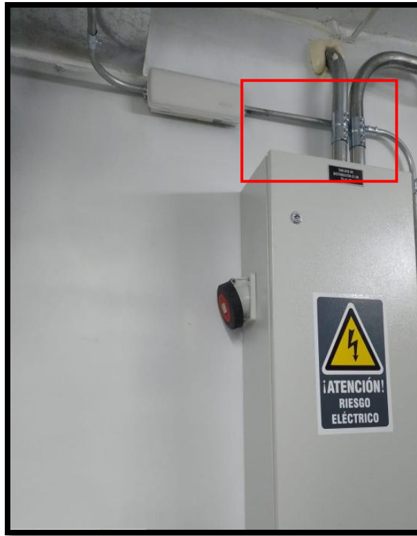
Figura 29. Luces de emergencia instaladas
