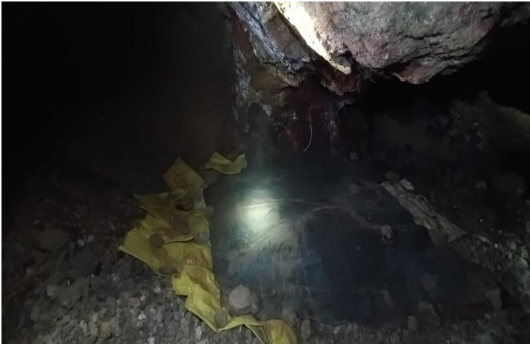
Colocado de geomembrana para evitar la dilución
