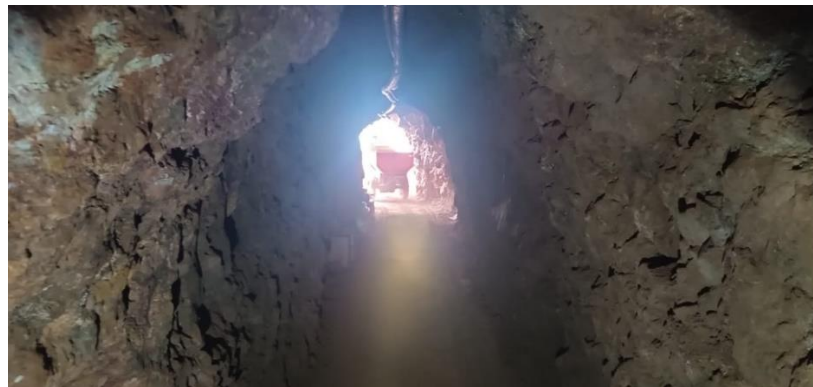
Figura 13. Transporte con dumper de ½ tonelada Tomada de Sociedad Minera J.A El Milagro - Área de operaciones (1)
