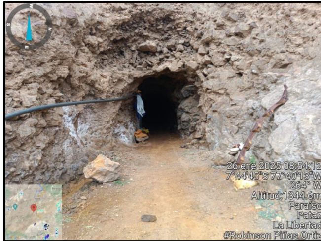
Figura 10. Labor con sistema de ventilación Tomada de Sociedad Minera J.A El Milagro - Área de operaciones (1)
