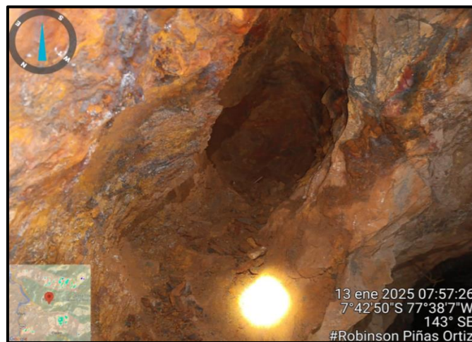
Figura 11. Labor sin sostenimiento Tomada de Sociedad Minera J.A El Milagro - Área de operaciones (1)
