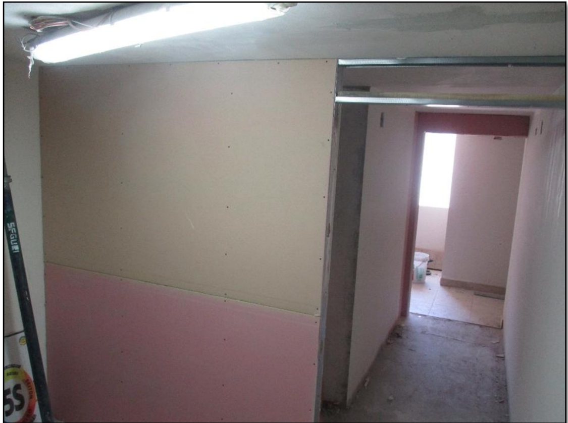
Figura 56: Colocación de drywall en tabiquería, baños y áreas comunes, Edf., 5 VBP
