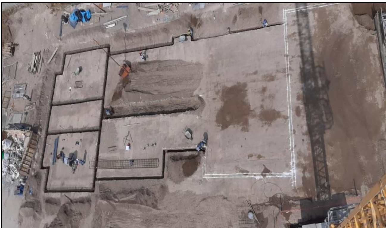
Figura 41: Excavación manual Edf.5 VBP
