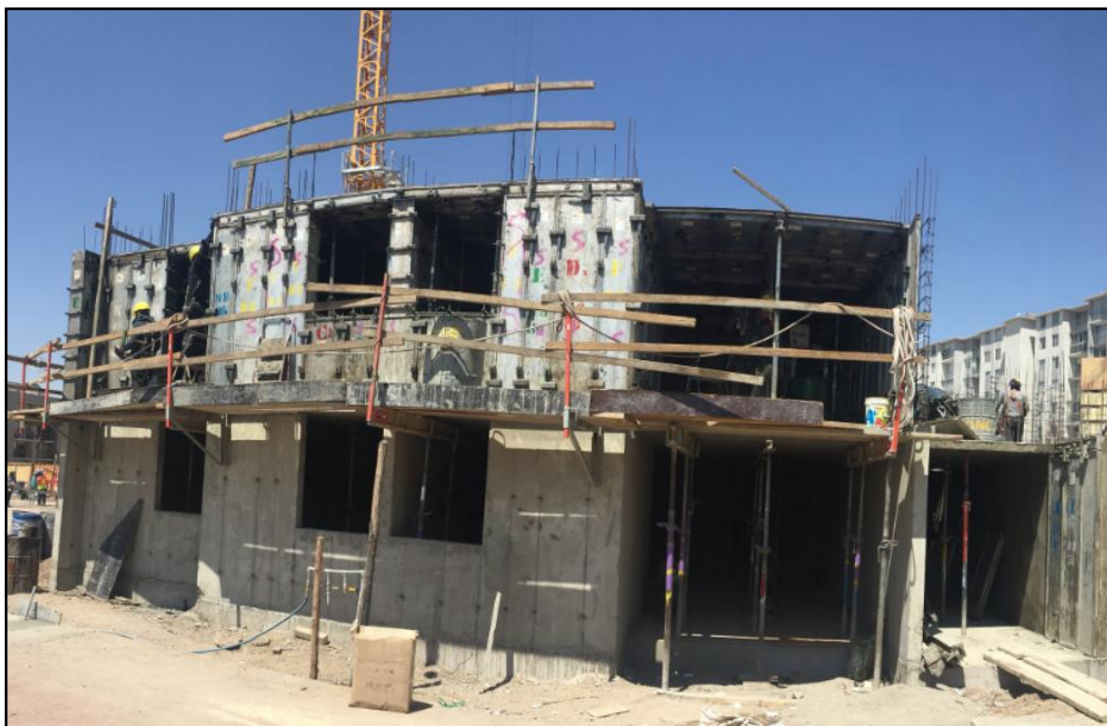
Figura 49: Encofrado monolítico vista frontal Edf. 5 VBP
