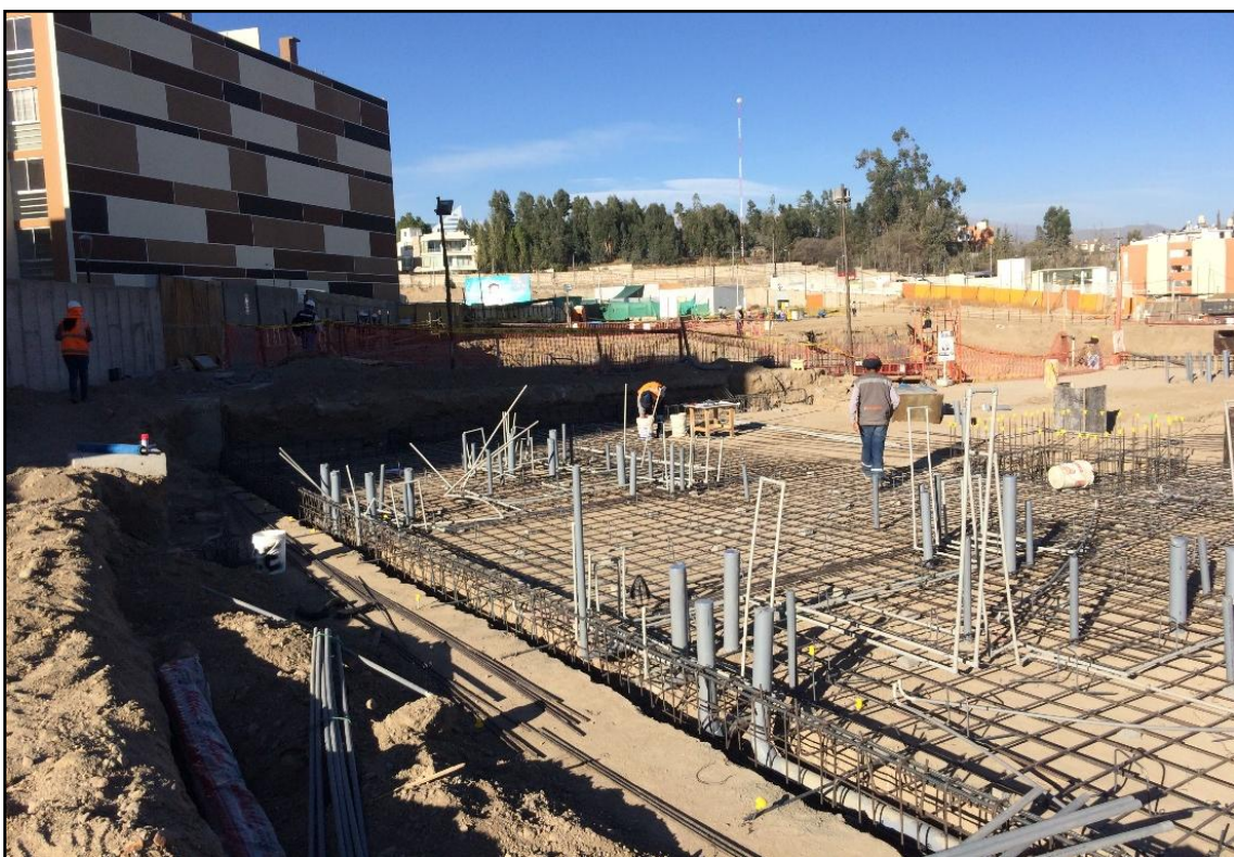
Figura 44: Instalaciones sanitarias, Edf. 6 VV2
