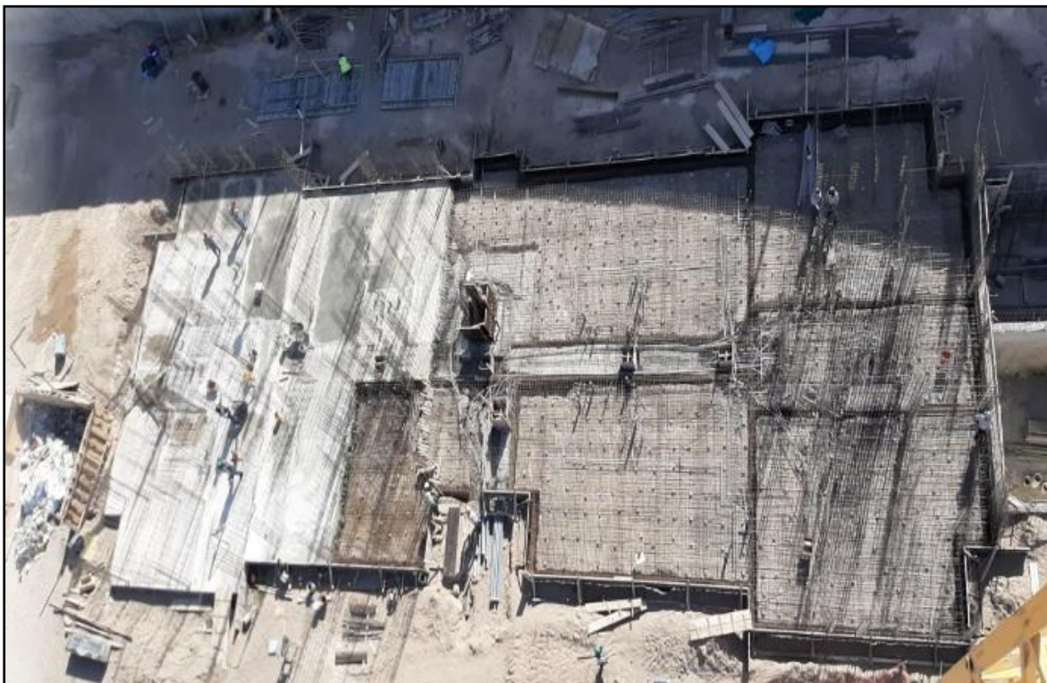
Figura 47: Trazo, replanteo de elementos verticales, acero en muros y continuación de vaciado de platea, edif. 5 VBP
