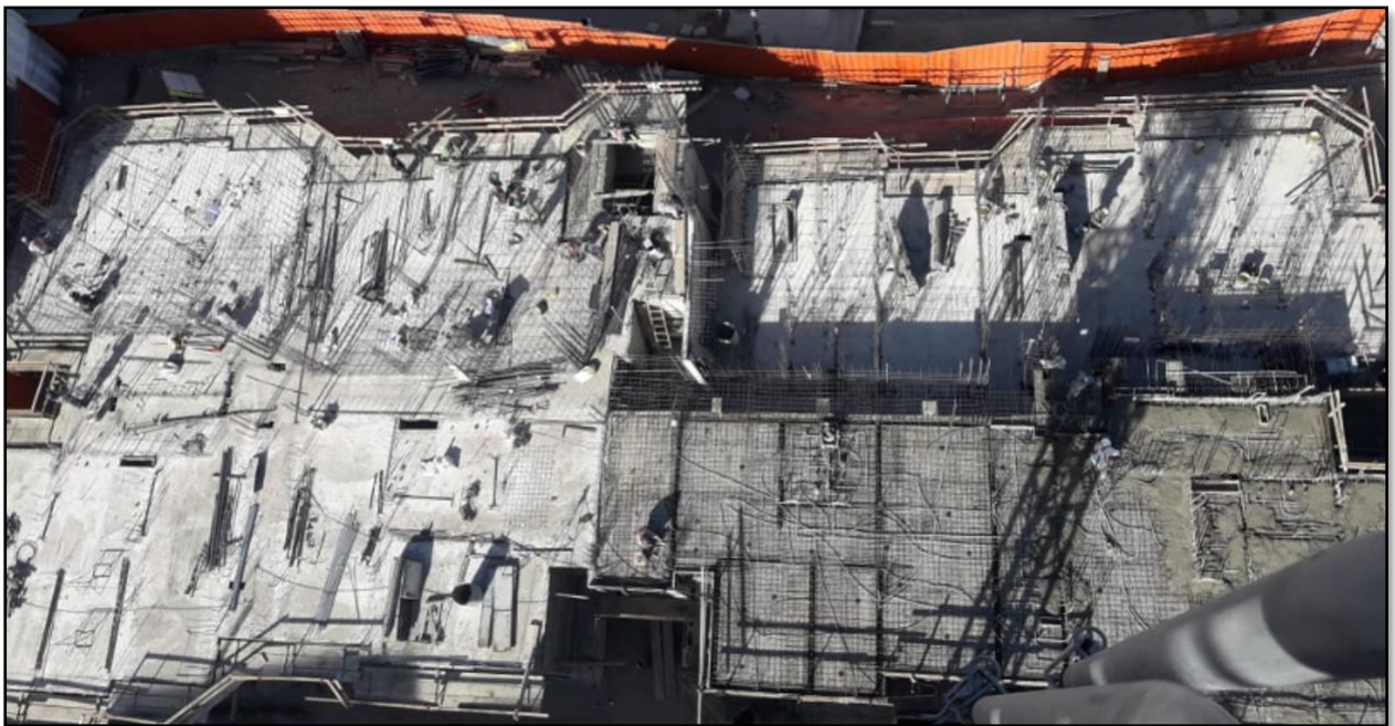
Figura 52: Acero en losa Edf. 5 VBP
