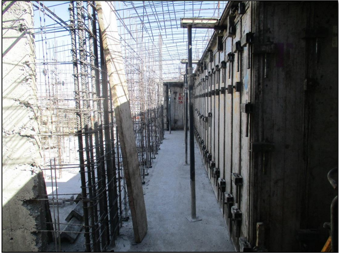
Figura 50: Encofrado peri de muros, Edf. 5 VBP
