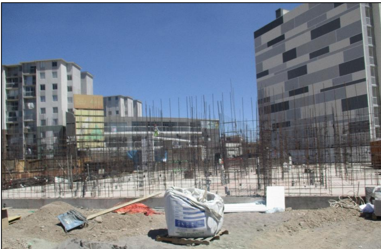
Figura 46: Instalaciones eléctricas y sanitarias en muros, Edif. 6 VV2
