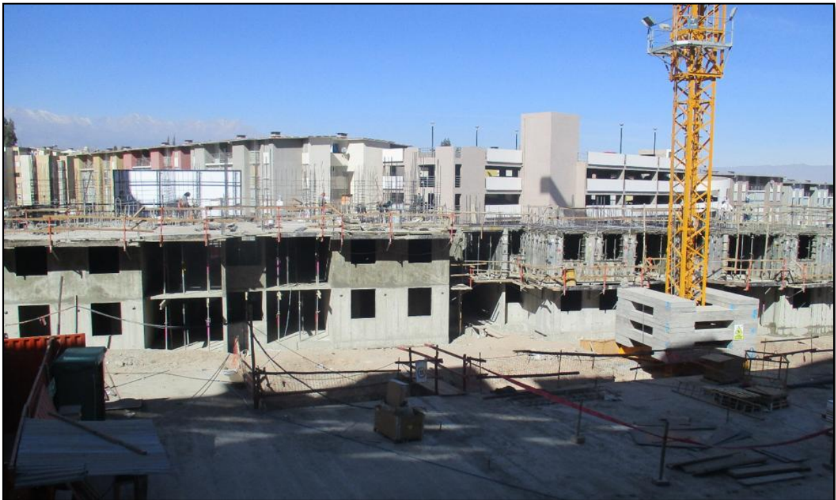
Figura 53: Desencofrado vista frontal de muro, Edf. 5 VBP
