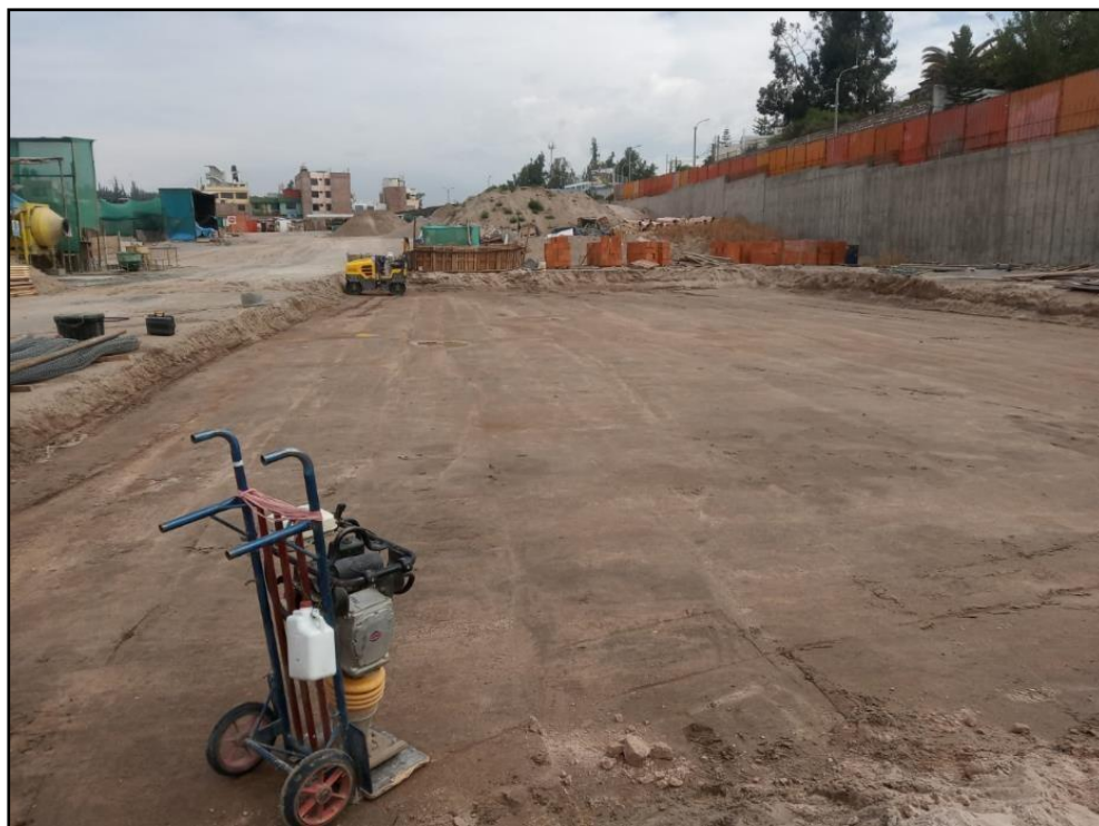
Figura 39: Compactación con rodillo de 2 tn en platea, Edf. 5 VBP
