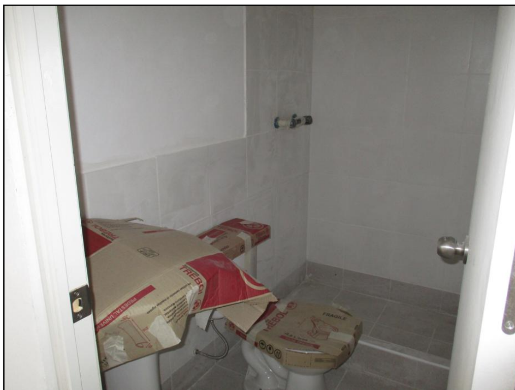
Figura 58: Instalación de aparatos sanitarios, Edf.5 VBP
