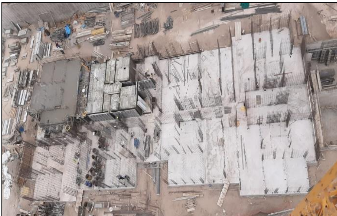
Figura 48: Encofrado monolítico Edf. 5 VBP
