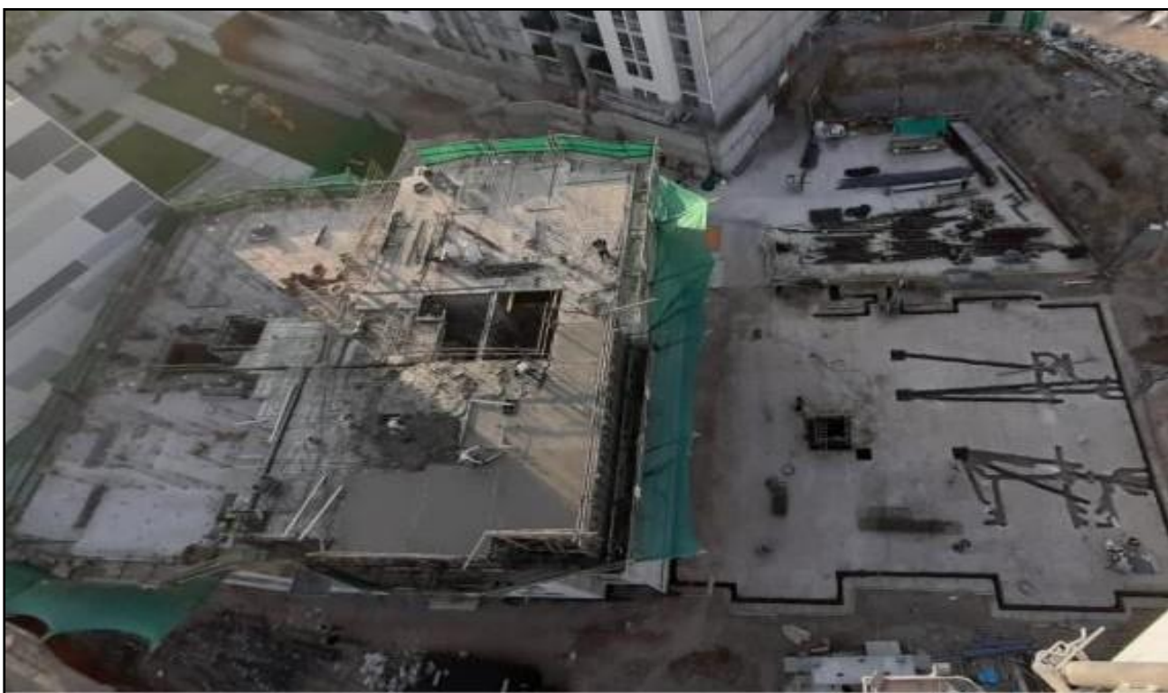
Figura 42: Excavación manual Edf. 6 VV2
