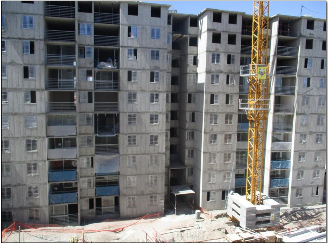
Figura 51: Concreto en muros y losa, Edf. 5 VBP
