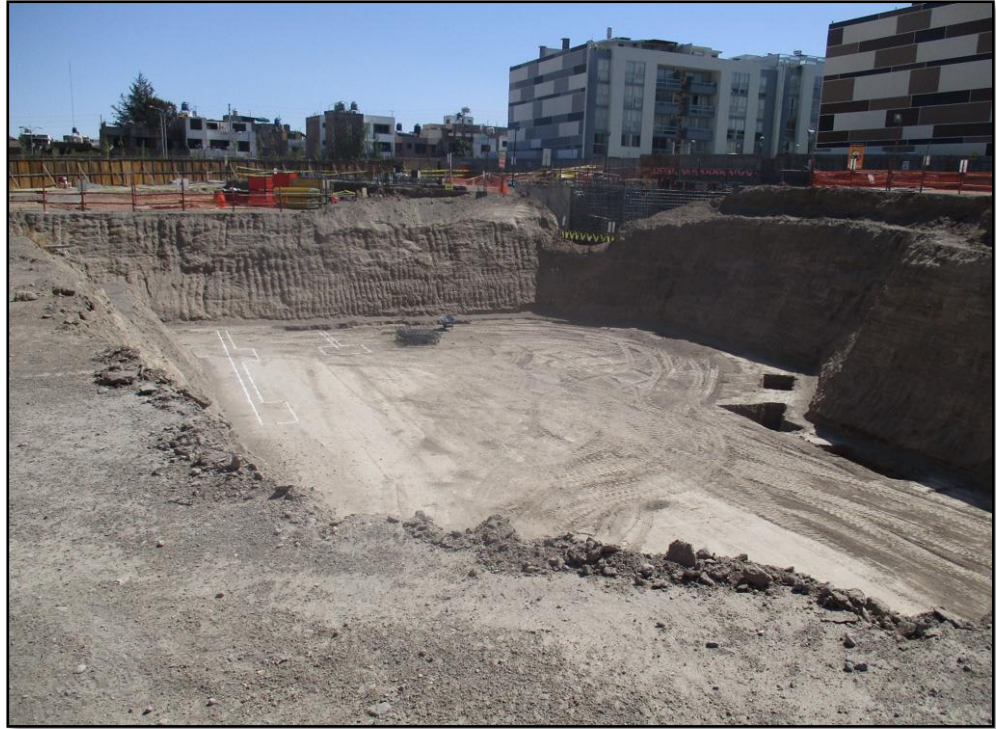
Figura 40: Excavación de Sótanos Ampliación Deck , VV2
