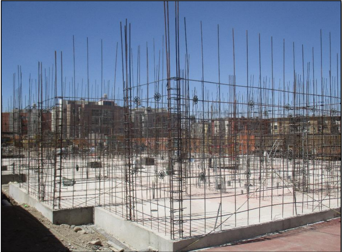
Figura 45: Acero en muros, recubrimiento con separadores tipo radial, Edf. 6 VV2
