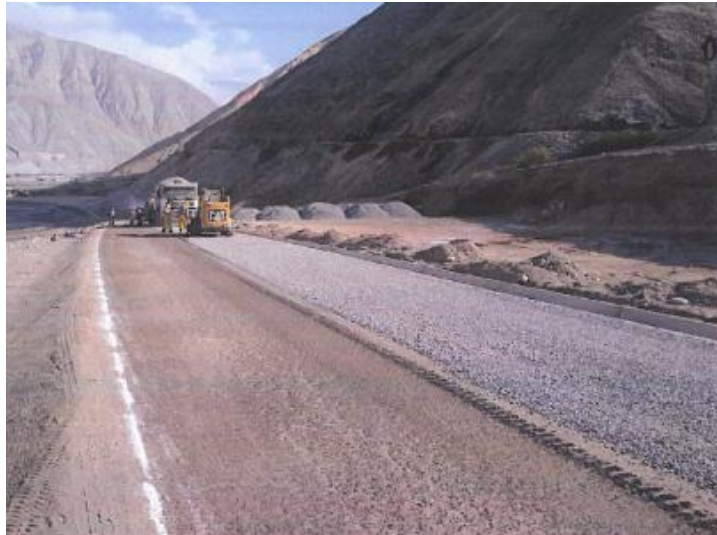
Figura 54. Colocación de arenado después de imprimado asfáltico
