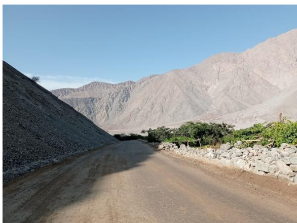
Figura 48. Se realizó la inspección previa a la colocación del imprimado
