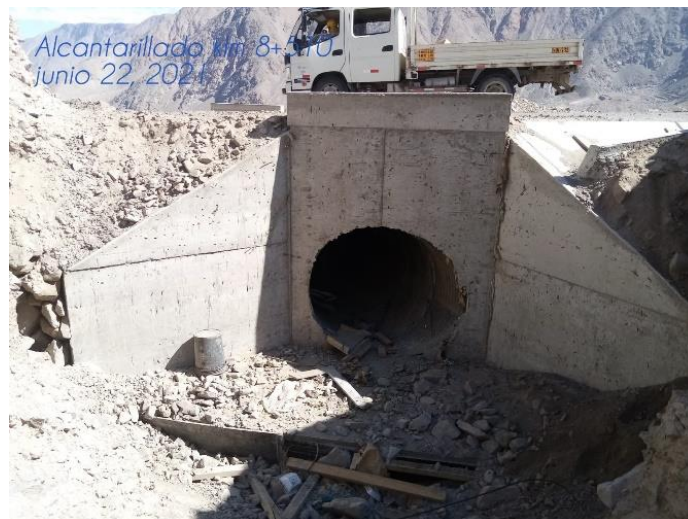
Figura 93. Construcción de alcantarilla
