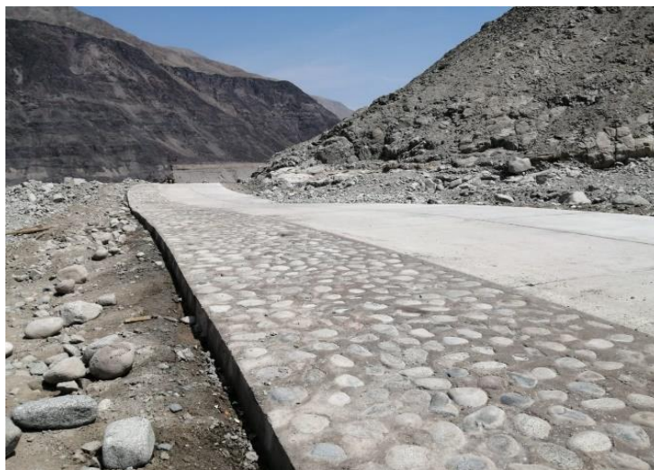
Figura 88. Vaciado de aliviaderos
