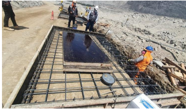
Figura 69. Encofrado para vaciado de losa de concreto en sector de baden
