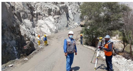
Figura 25. Trabajo de plantilleo para colocación de base granular
