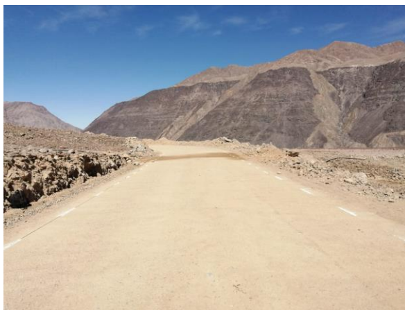
Figura 21. Trabajo de plantileo para colocación de base granular
