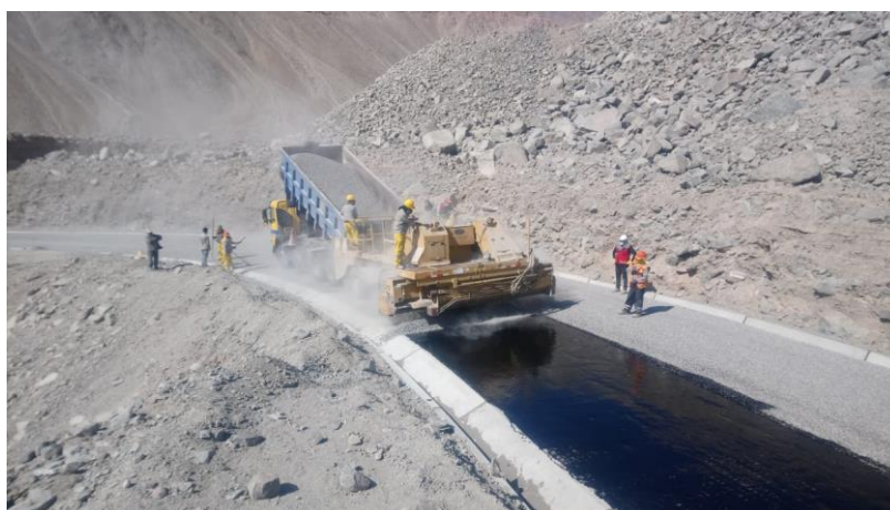
Figura 62. Imprimación con líquido asfáltico
