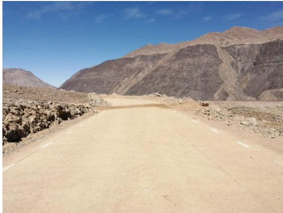
Figura 51. Trabajo de plantileo para colocación de base granular
