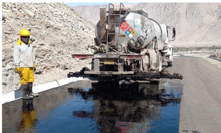
Figura 56. Imprimación de base granular
