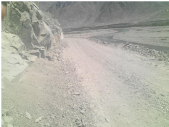
Figura 5. Trabajo de reconocimiento de campo, progresiva 10+020, sector de corte de terreno en roca fija
