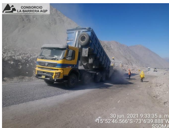
Figura 59. Colocación de arenado de protección sobre imprimación asfáltica
