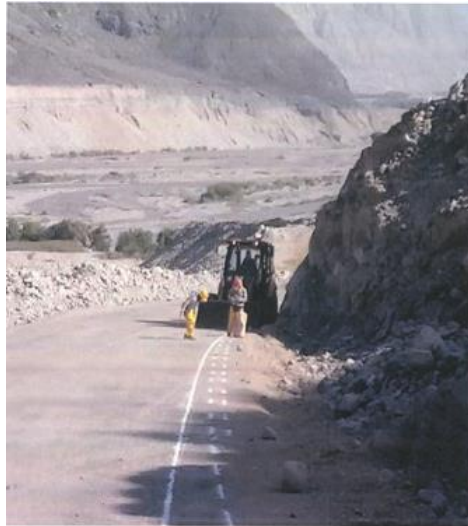
Figura 82. Trabajo de trazo para excavación de cuneta
