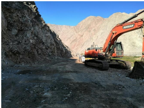
Figura 19. Eliminación de material de corte
