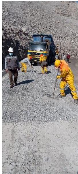
Figura 64. Extendido de arenado para protección
