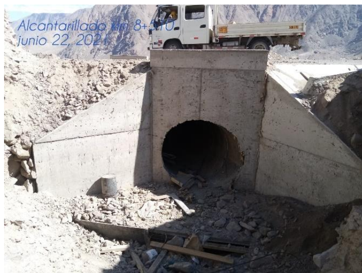
Figura 95. Construcción de alcantarilla
