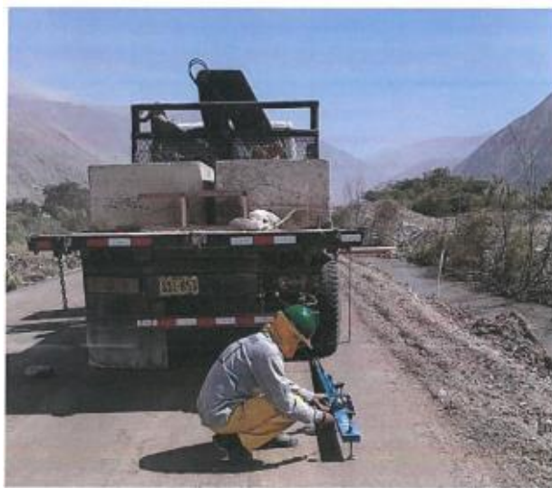
Figura 40. Ensayo de deflectometría con viga Benkelman
