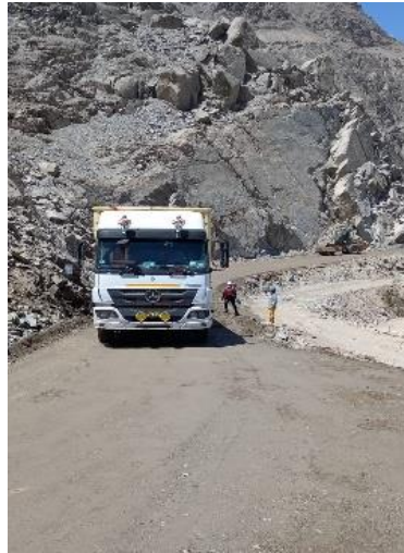
Figura 27. Trabajo de plantileo para colocación de base granular
