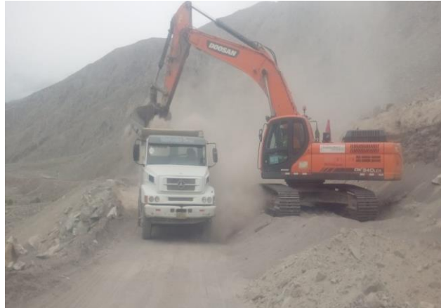
Figura 12. Trabajo de corte de terreno suelto, progresiva 8+600
