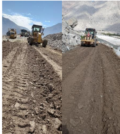
Figura 30. Trabajos de colocación de base granular
