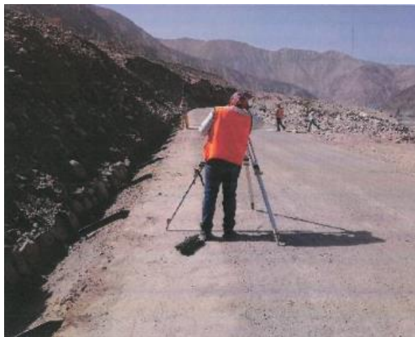
Figura 83. Control topográfico en excavación de cuneta
