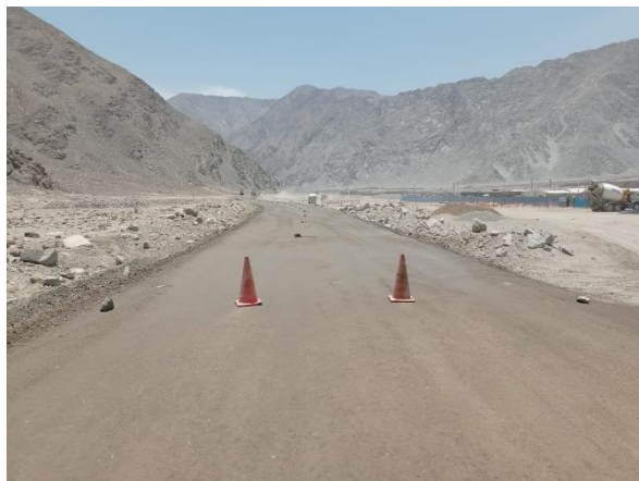
Figura 46. Verificación de base, previo a la colocación del imprimado
