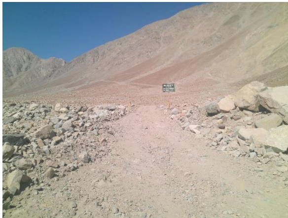
Figura 4. Trabajo de reconocimiento de campo progresiva 8+750, sector de corte de terreno en roca fija
