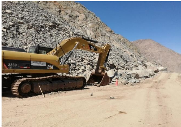
Figura 16. Perfilamiento de terreno natural para colocación de base
