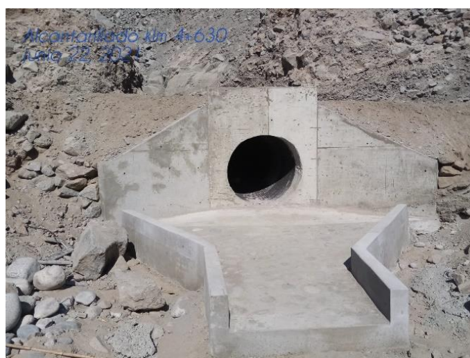
Figura 94. Construcción de alero en alcantarilla
