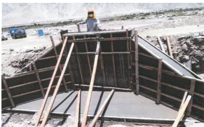
Figura 91. Construcción de alcantarilla
