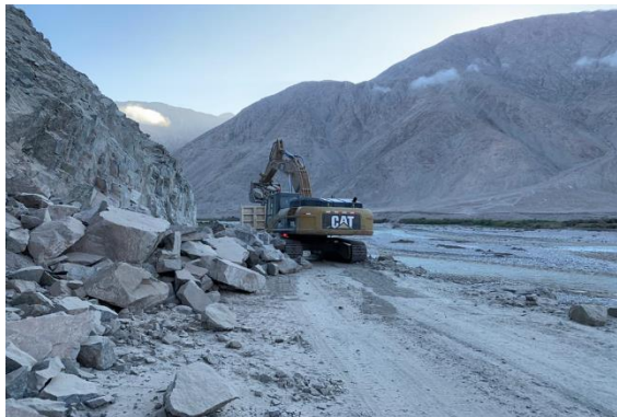
Figura 10. Trabajo de corte de terreno rocoso, progresiva 5+250
