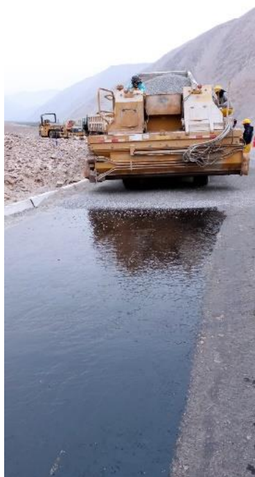
Figura 57. Imprimación de base granular
