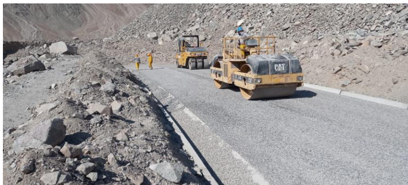
Figura 65. Trabajos de sellado con rodillo compactador
