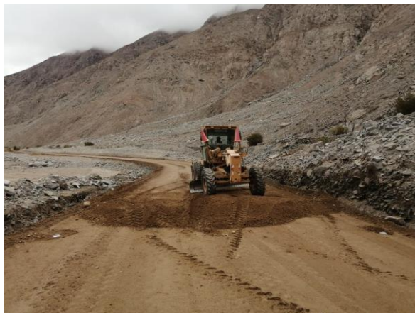
Figura 22. Trabajos de colocación de material de base
