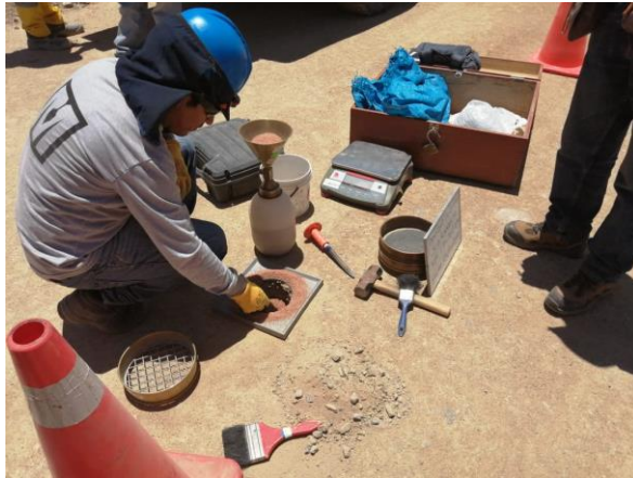
Figura 36. Ensayo de control de densidad de campo
