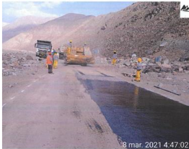
Figura 52. Colocación de líquido asfáltico sobre base granular
