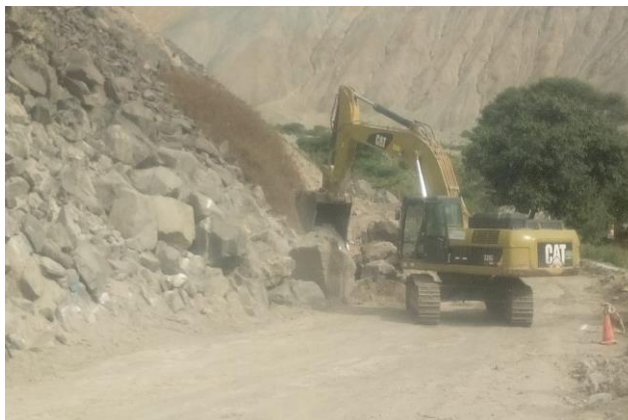
Figura 13. Trabajo de corte y perfilamiento de terreno, progresiva 15+600
