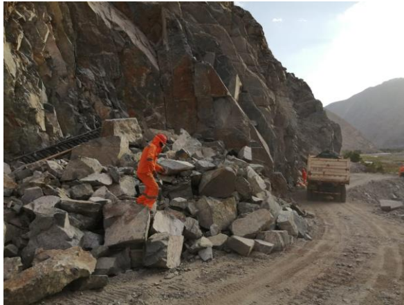
Figura 15. Trabajo de eliminación de material de corte
