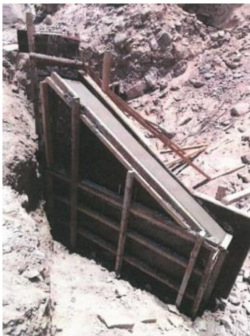
Figura 90. Construcción de alero en alcantarilla
