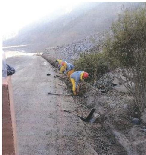
Figura 78. Vaciado de concreto en cuneta
