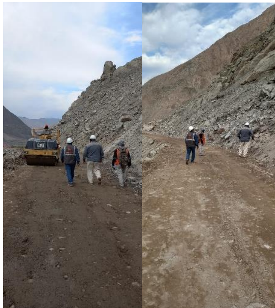
Figura 28. Verificación de trabajos de perfilamiento
