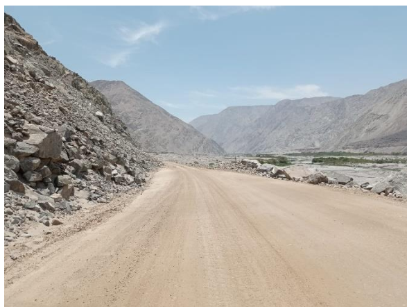
Figura 47. Trabajo de plantilleo para colocación de base granular
