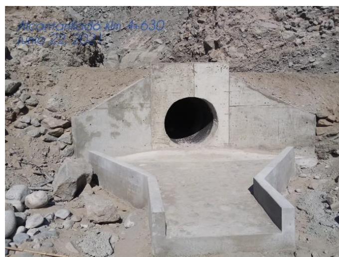
Figura 94. Construcción de alero en alcantarilla
