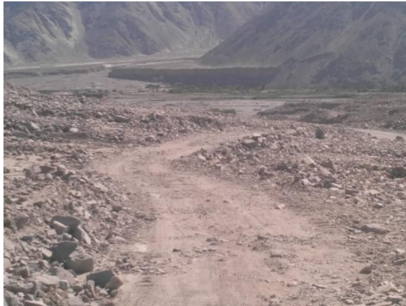
Figura 6. Trabajo de reconocimiento de campo, progresiva 12+260, vía existente
