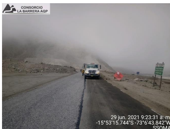
Figura 60. Imprimación de base granular
