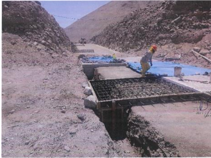
Figura 72. Vaciado de concreto en losa en sector de baden
