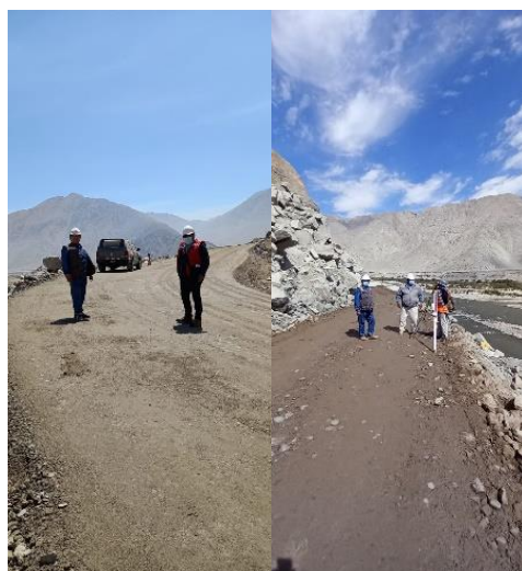
Figura 29. Verificación e inspección de trabajos de colocación de base granular
