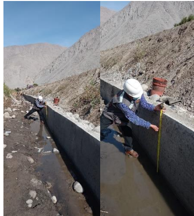
Figura 33. Verificación de trabajos de muros de contención
