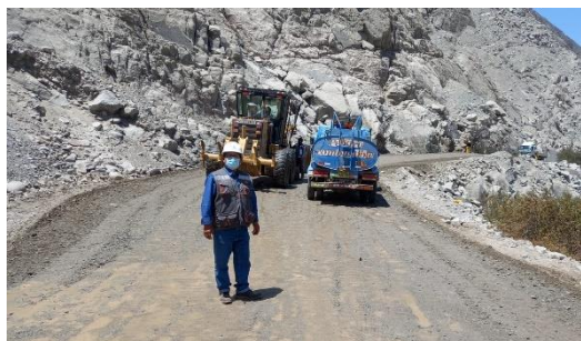
Figura 24. Perfilamiento de terreno natural para colocación de base
