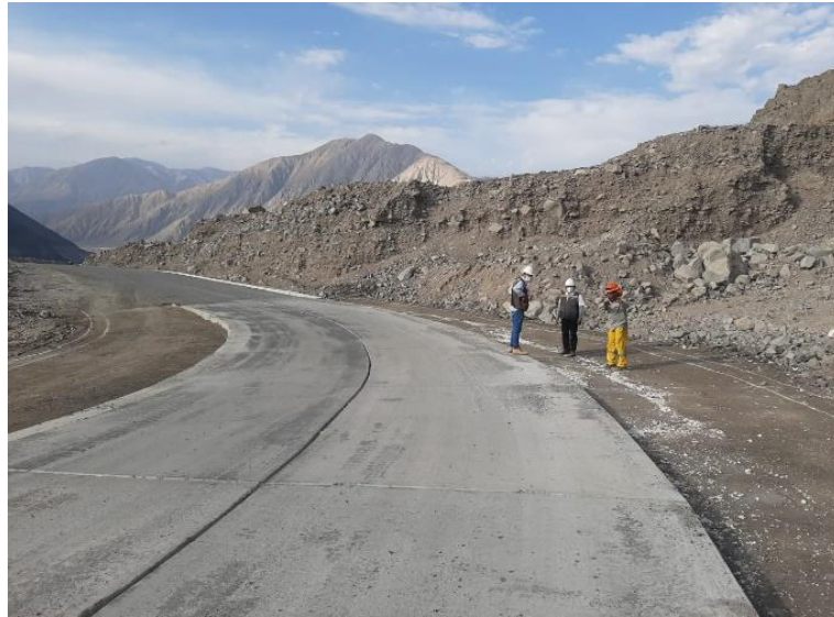
Figura 74. Acabado final de losa de concreto en sector de baden
