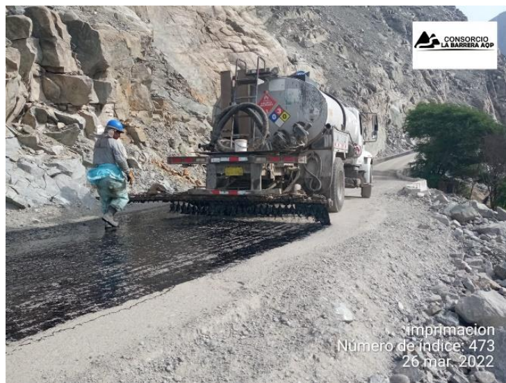
Figura 67. Trabajo de imprimado con líquido asfáltico en caliente
