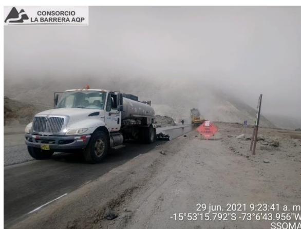
Figura 58. Imprimación de base granular
