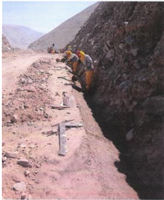
Figura 76. Perfilamiento de terreno para construcción de cuneta
