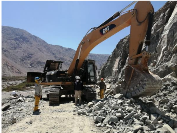
Figura 17. Trabajo de corte de terreno rocoso
