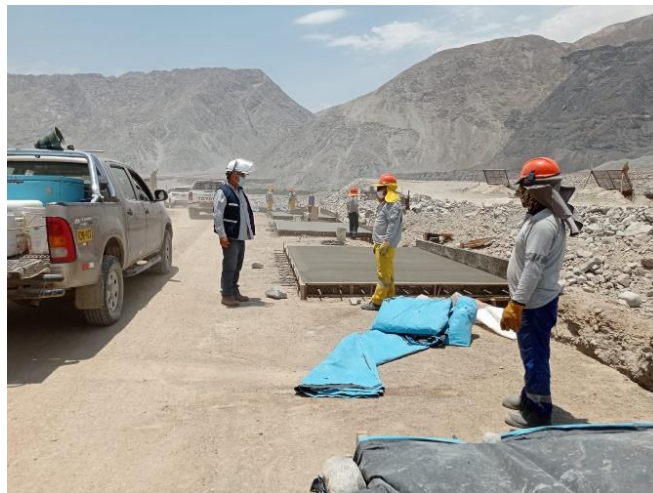
Figura 70. Proceso de tapado con plástico para evitar la deshidratación después del vaciado
