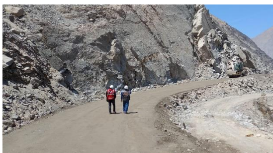
Figura 26. Perfilamiento de terreno natural para colocación de base
