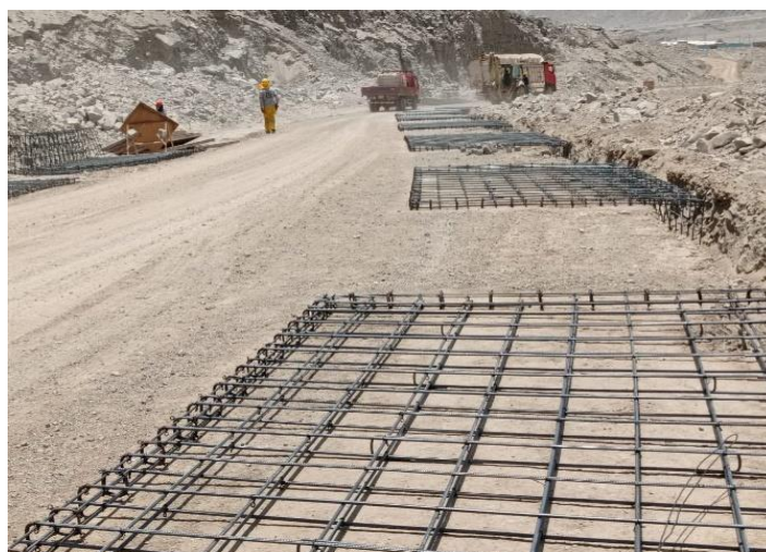
Figura 68. Armado de acero estructural para losa de concreto
