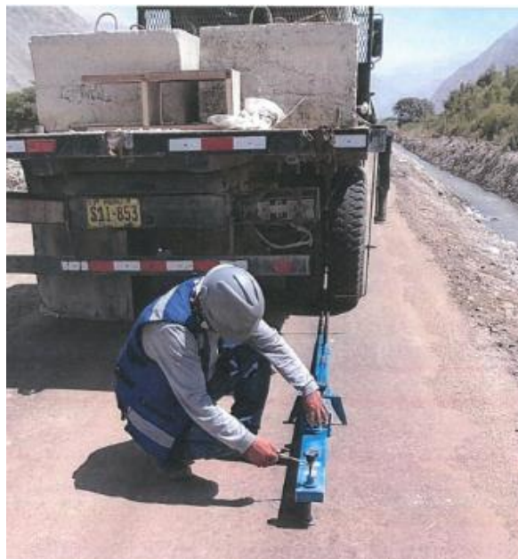
Figura 41. Ensayo de deflectometría con viga Benkelman
