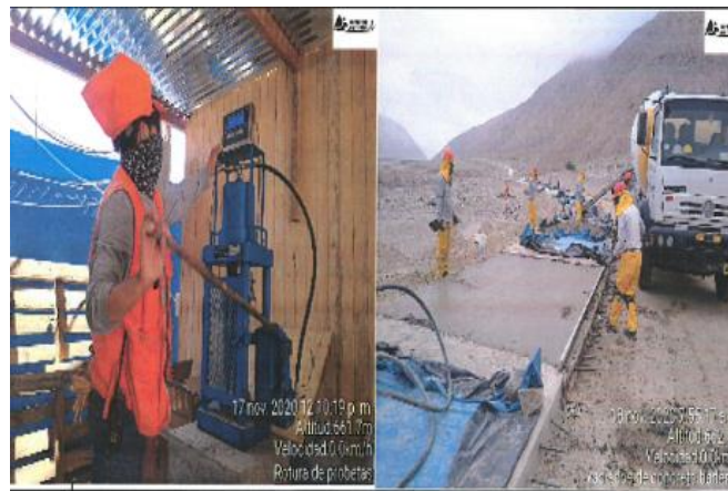
Figura 43. Ensayo de ruptura de briqueta, vaciado de losa de concreto
