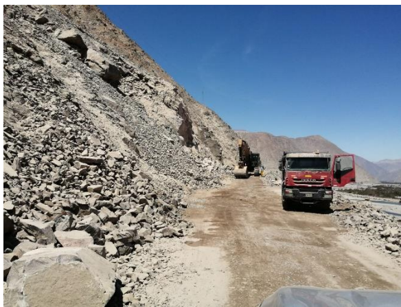
Figura 18. Eliminación de material de corte
