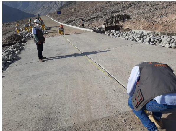
Figura 75. Verificación de metraje de losa de concreto para valorización mensual
