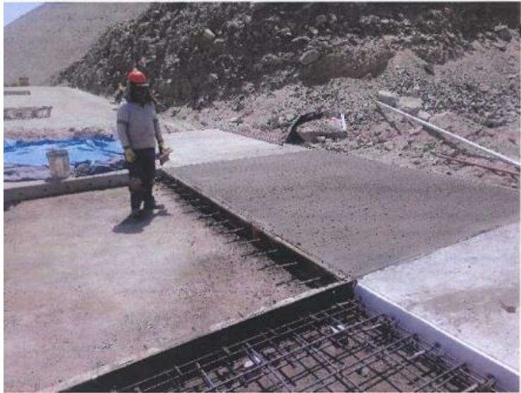
Figura 73. Vaciado de concreto armado para baden
