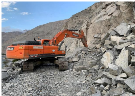
Figura 9. Corte de terreno y eliminación de material suelto
