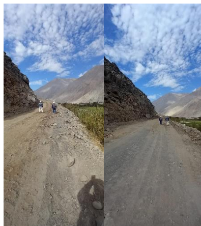
Figura 31. Trabajos de colocación de base granular
