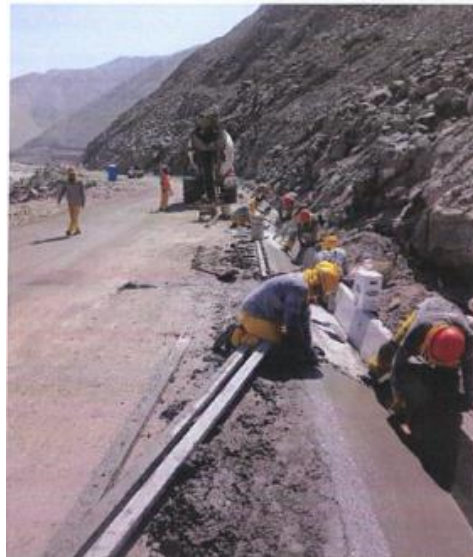
Figura 80. Vaciado de concreto en cuneta
