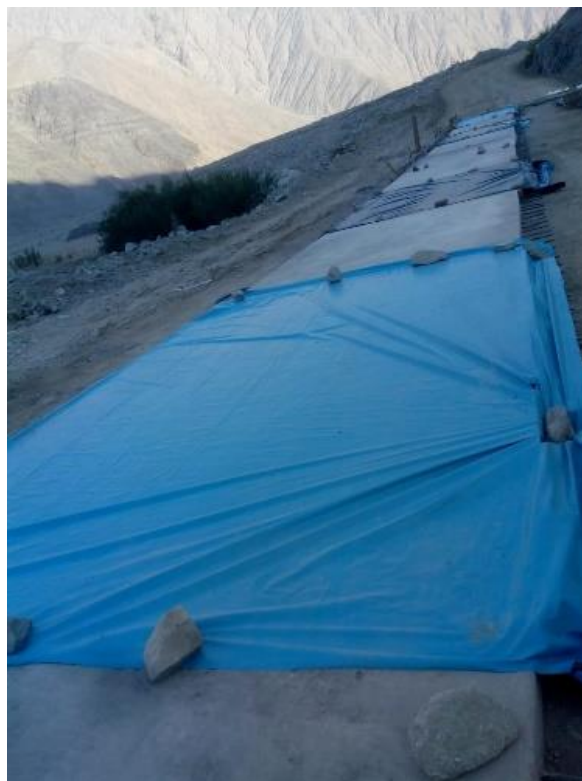
Figura 71. Losa de concreto con protección después de poscurado
