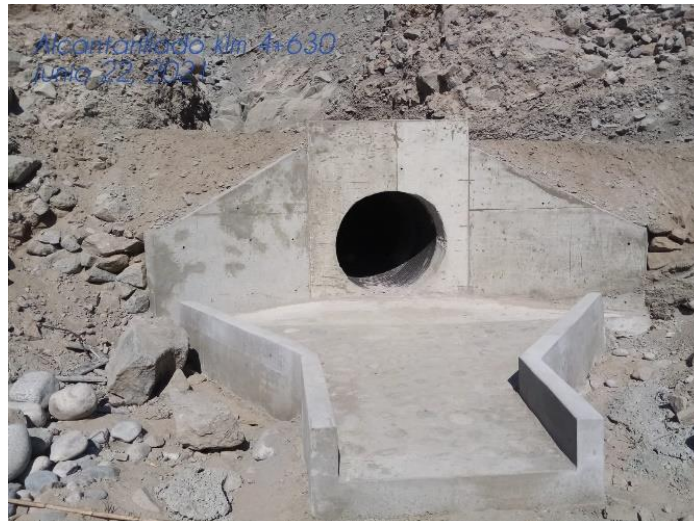
Figura 92. Construcción de alero en alcantarilla
