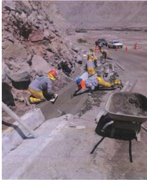
Figura 81. Vaciado de concreto en cuneta
