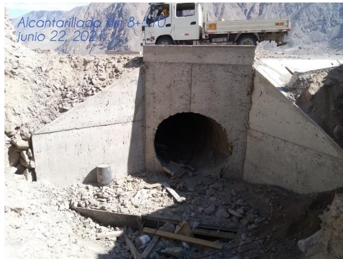
Figura 93. Construcción de alcantarilla
