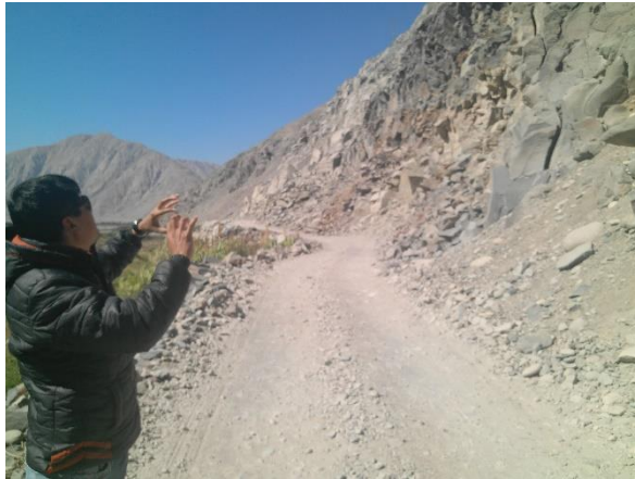
Figura 3. Trabajo de reconocimiento de campo, progresiva 6+020, sector de corte de terreno en roca fija
