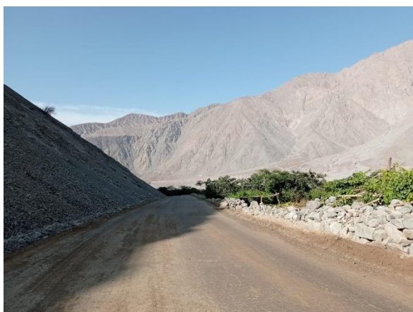
Figura 50. Perfilamiento de terreno natural para colocación de base
