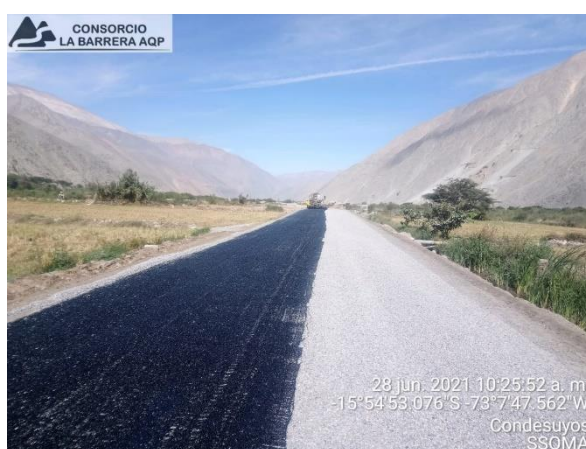
Figura 61. Imprimación de base granular
