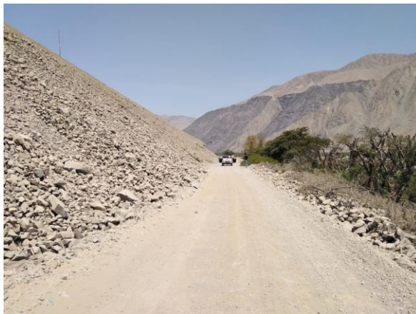
Figura 8. Trabajo de reconocimiento de campo progresiva 19+750, vía existente hasta el sector de La Barrera
