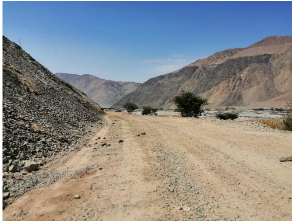
Figura 20. Perfilamiento de terreno natural para colocación de base
