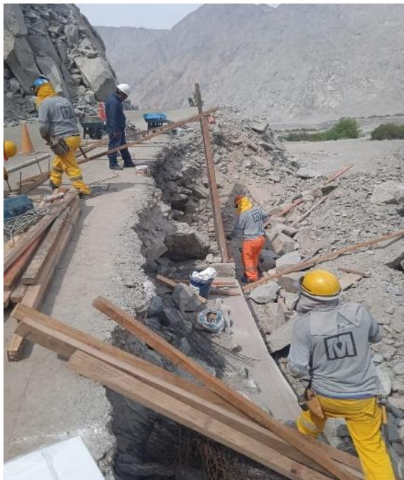
Figura 32. Verificación de trabajos de colocación de muros de contención
