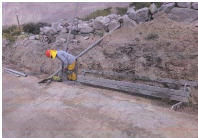
Figura 77. Trabajo encofrado de cuneta
