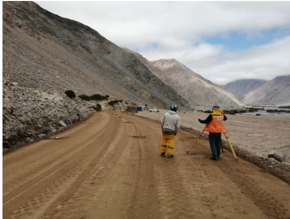
Figura 23. Trabajo de control topográfico en colocación de base
