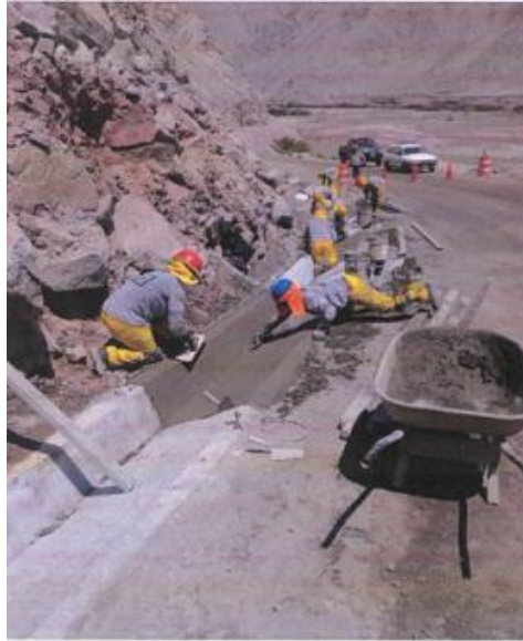
Figura 79. Vaciado de concreto en cuneta
