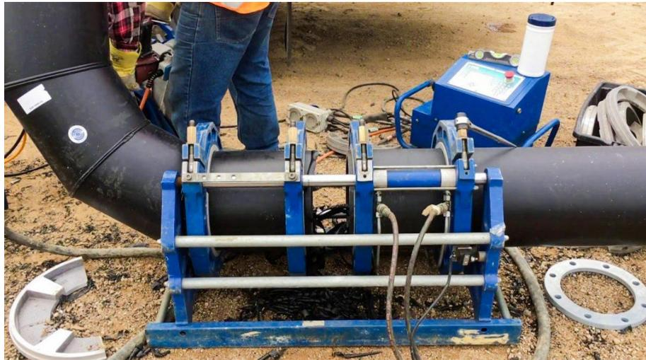
*Figura 3.* Proceso de termofusión. Tomada de «Partes de una máquina de termofusión a tope», por Grupo Hidráulica, 2022.
