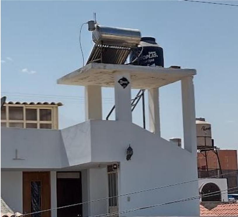
Figura 2. *Terma solar instalada en techo de escalera sin barandas de protección.*
