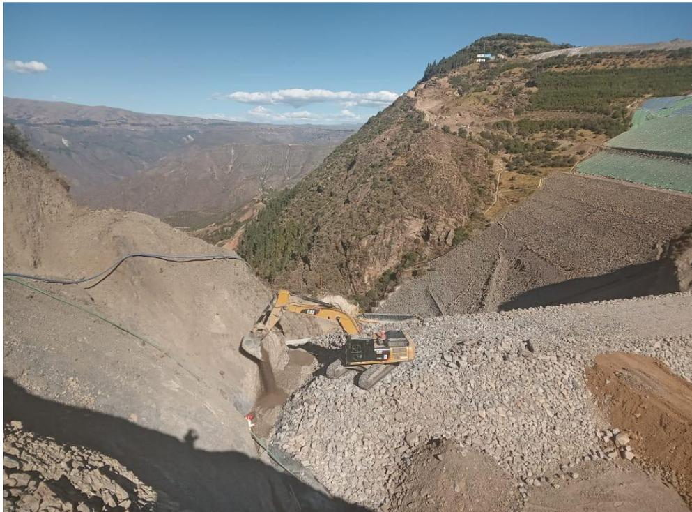
*Figura 15. Colocación de filtro tipo I y tubería Hdpe liso de 4" por posibles filtraciones de agua (dren francés)*
