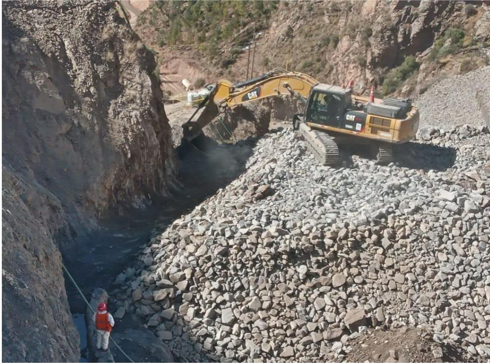
*Figura 14. Colocación de drenaje por posibles filtraciones de agua (dren francés)*
