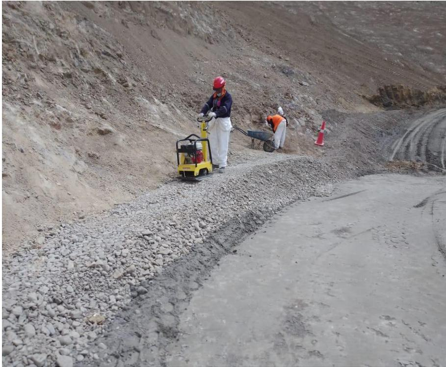
*Figura 27. Conformación de filtro tipo I en los laterales de la plataforma de compactado con ayuda de la plancha compactadora, vibroapizonador ancho 1.00 m*
