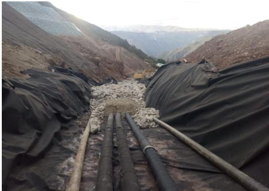
*Figura 36. Colocación de material filtro*
