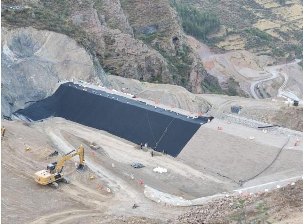
*Figura 18. Impermeabilización del dique por posibles filtraciones*
