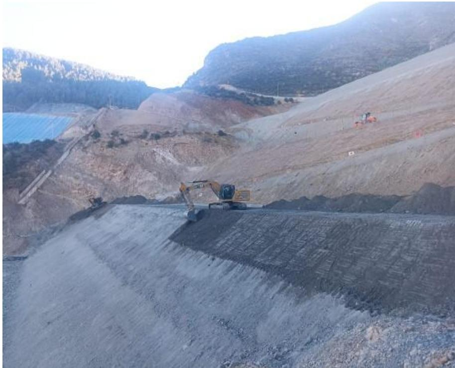
*Figura 23. Perfilado de talud cada 2.5 metros para el alcance del brazo de la excavadora su ángulo de reposo del cuerpo es de 1.75*
