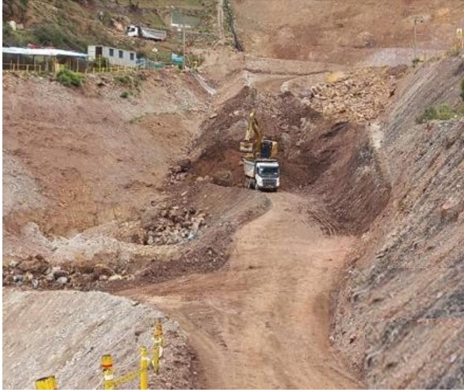
*Figura 32. Limpieza de la zona, eliminación del material suelto*
