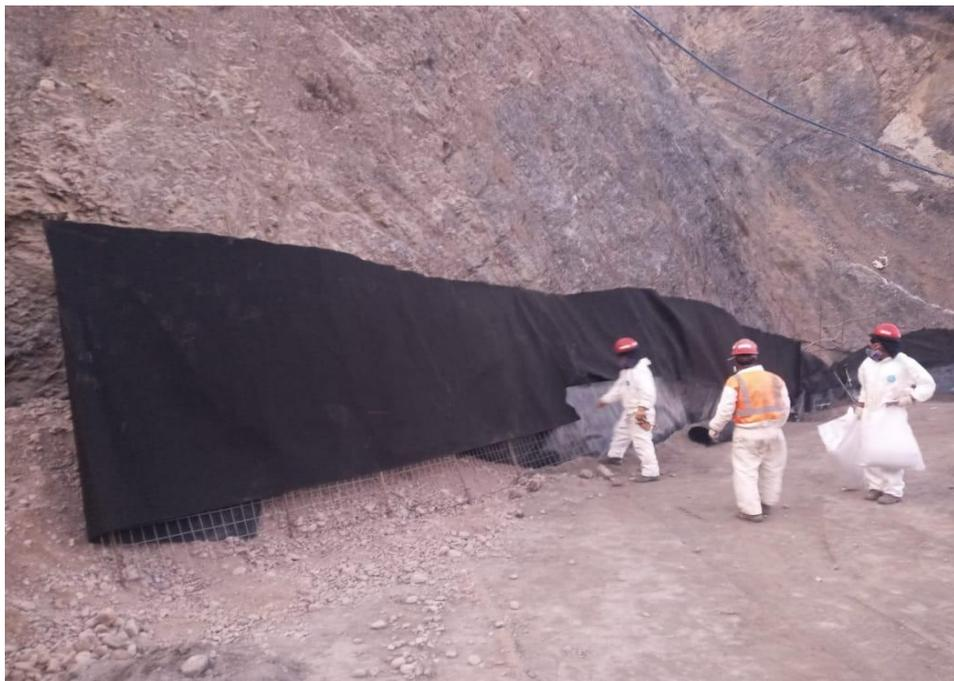
*Figura 28. Colocación de malla, geotextil y geomembrana para contener el filtro tipo I en los laterales de la plataforma, esta práctica se realiza cuando hay taludes pronunciados*
