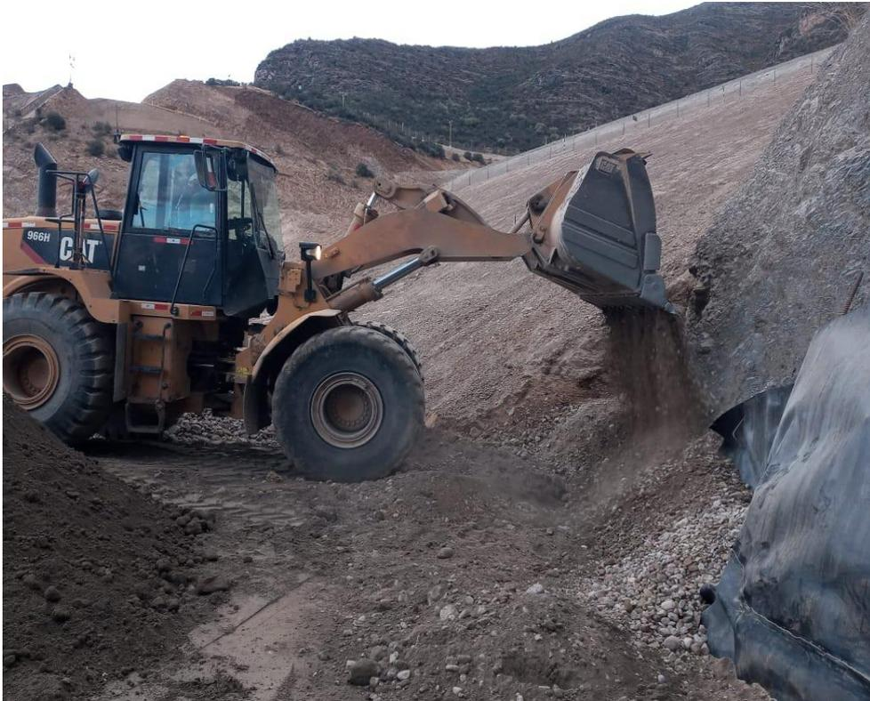
*Figura 29. Colocación de filtro tipo I en ambos laterales con el cargador frontal*
