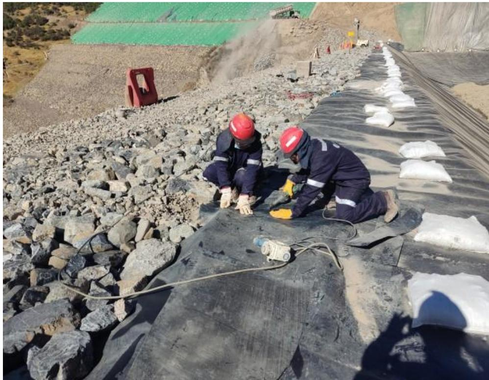
*Figura 19. Anclaje de geomembrana para la impermeabilización del dique*
