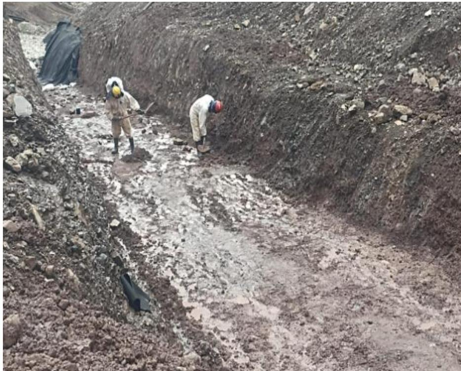
*Figura 33. Limpieza manual de material suelto*
