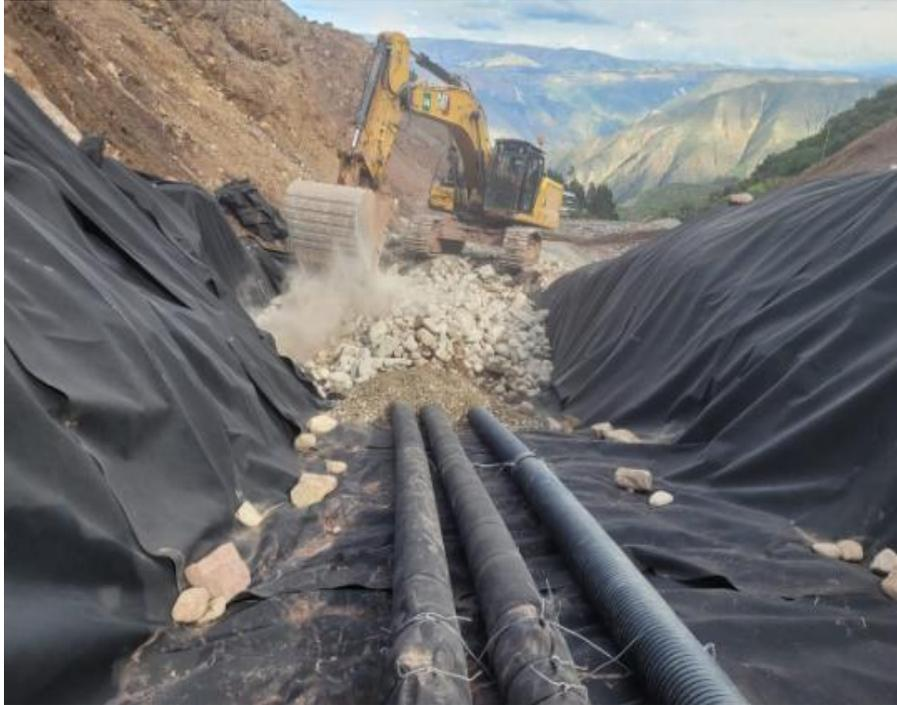
*Figura 37. Colocación de material filtro tipo 3/4*
