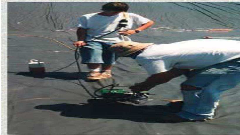
*Figura 43. Soldadura con termofusión*
