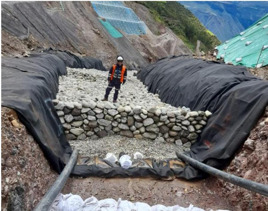
*Figura 38. Colocación de material filtro en su totalidad*
