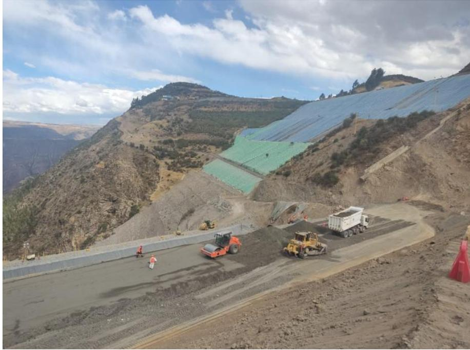
*Figura 24. Escarificado y conformación de material de mezcla en plataforma (relleno en pasta) capas de 0.35 y 0.30*
