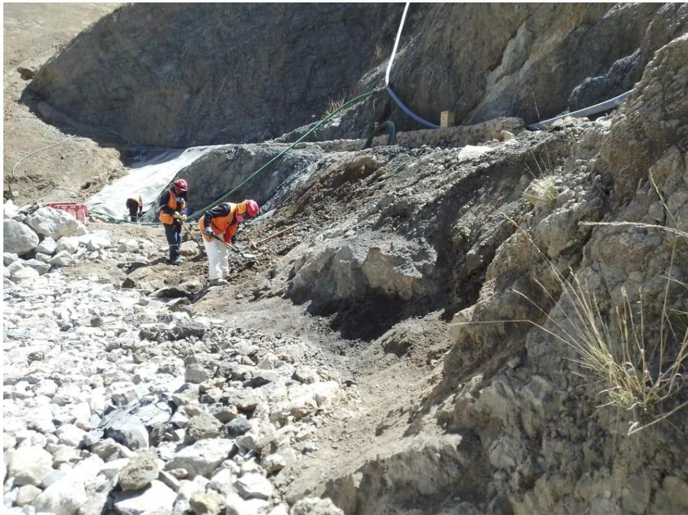
*Figura 13. Limpieza manual de materiales sueltos (encroche)*
