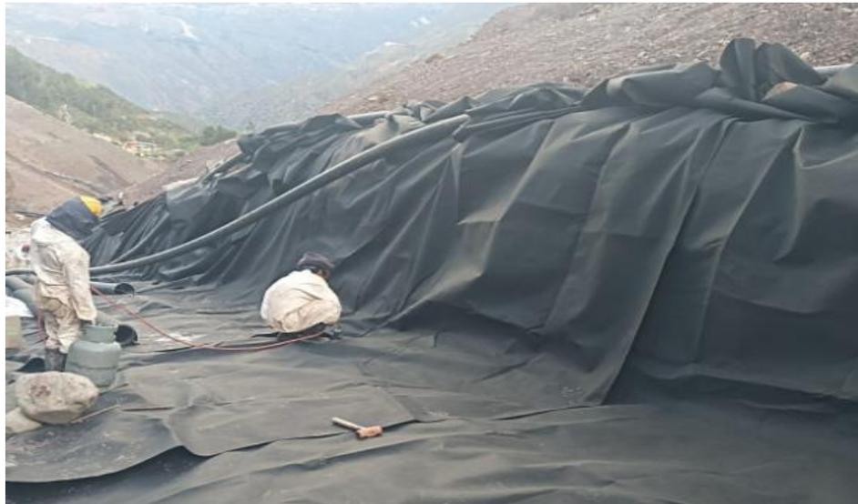
*Figura 35. Impermeabilización de la zanja*
