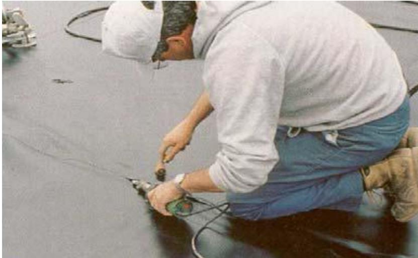
*Figura 42. Soldadura con aire caliente (leister)*
