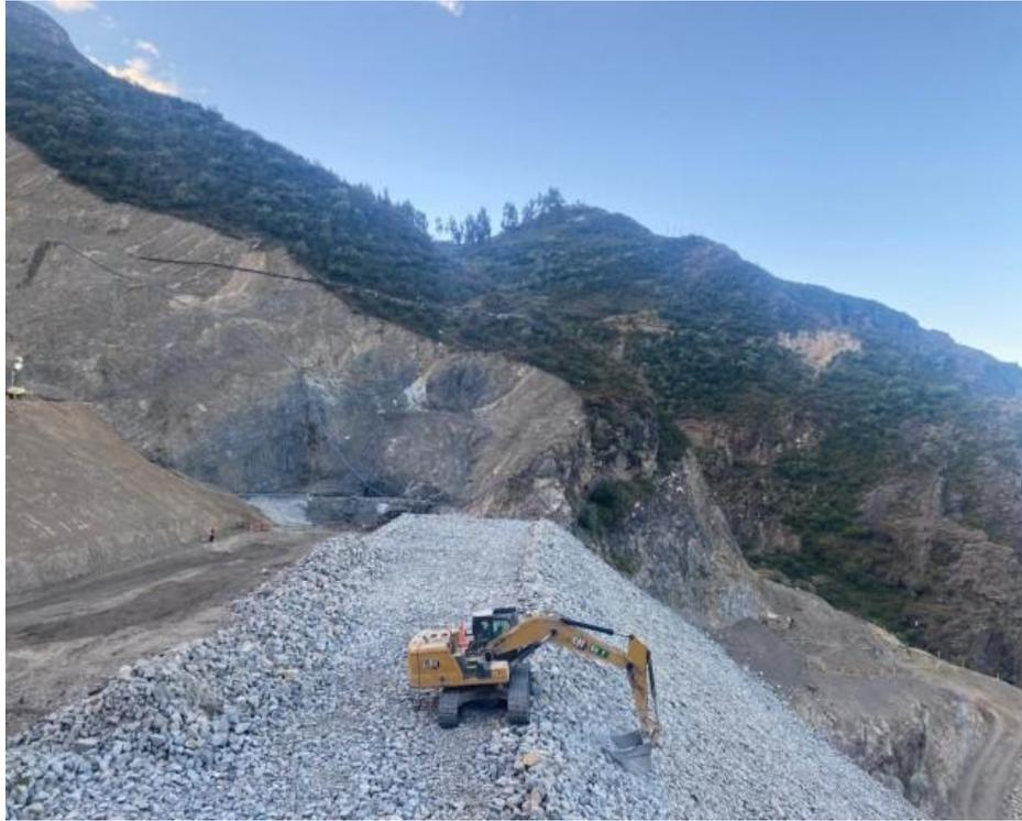
*Figura 16. Conformación de hombro del dique cada 2.5 m*
