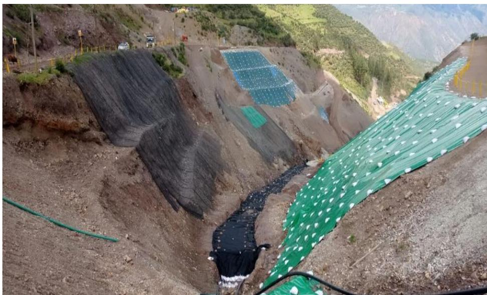
*Figura 39. Recubrimiento de dren con geotextil*
