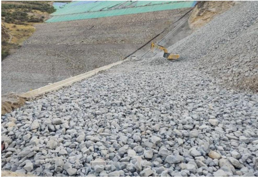
*Figura 12. Conformación de piedra en el dique (pedraplén)*
