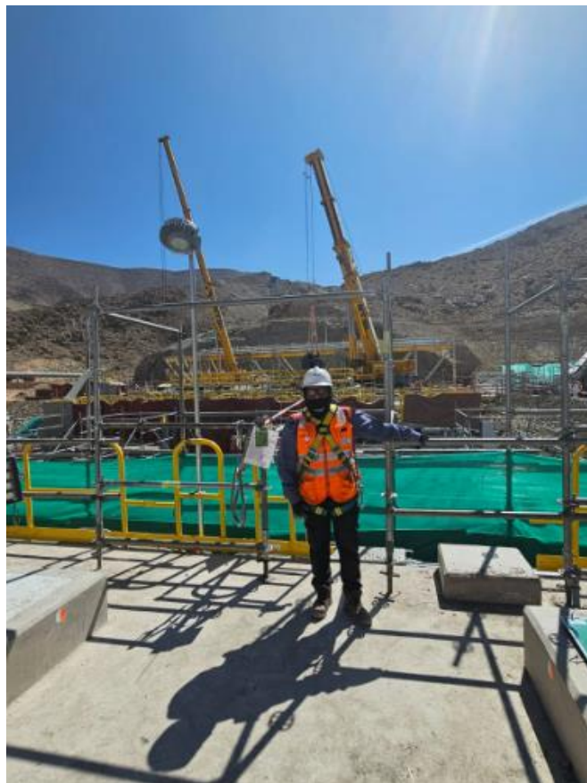
Imagen 67: Asistencia en la Supervisión de los avances en la Losa Techo
