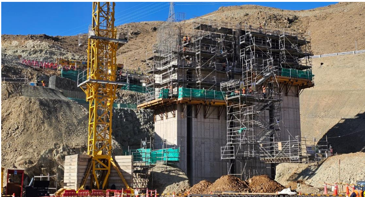
Imagen 59: Torre de Captación N°5 en el Cuarto Nivel luego de ser vaciado
