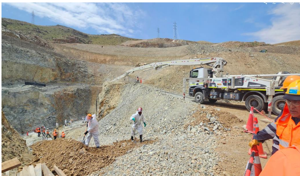
Imagen 21: Inicio del vaciado de la Zapata de la Torre de Captación 05
