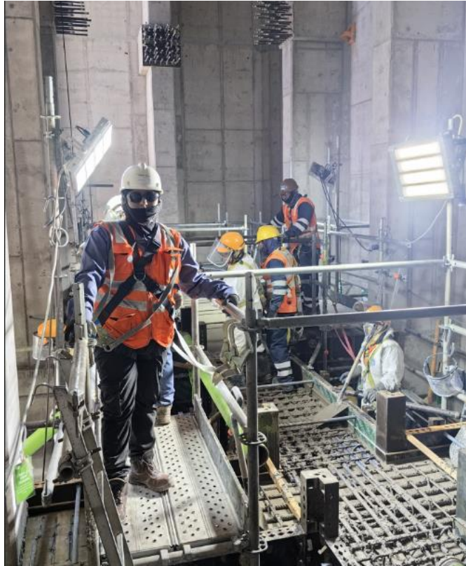
Imagen 66: Asistencia en la Supervisión del vaciado de la Viga 01 interna, TC.05
