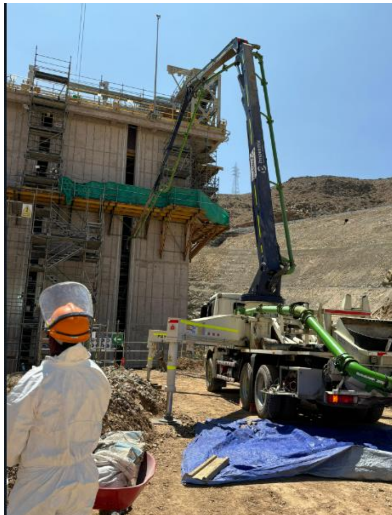
Imagen 65: Vaciado de las vigas internas de la Torre de Captación N°5
