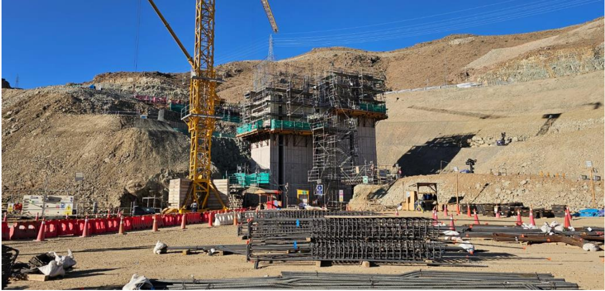
Imagen 60: Torre de Captación N°5 vista panorámica
