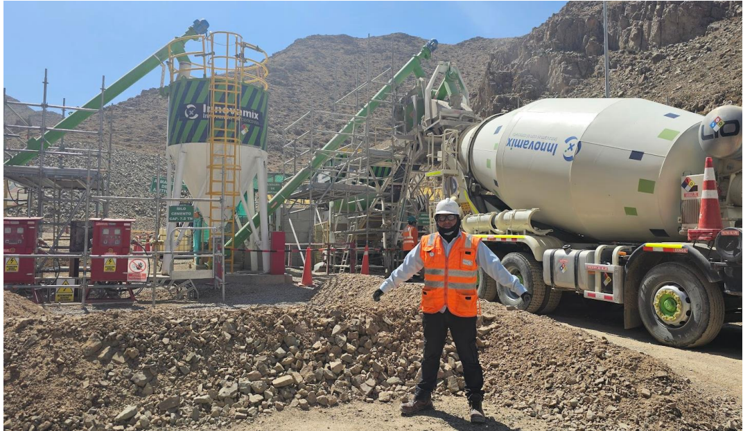
Imagen 30: Planta de Concreto COSAPI, Torre de Captación 05
