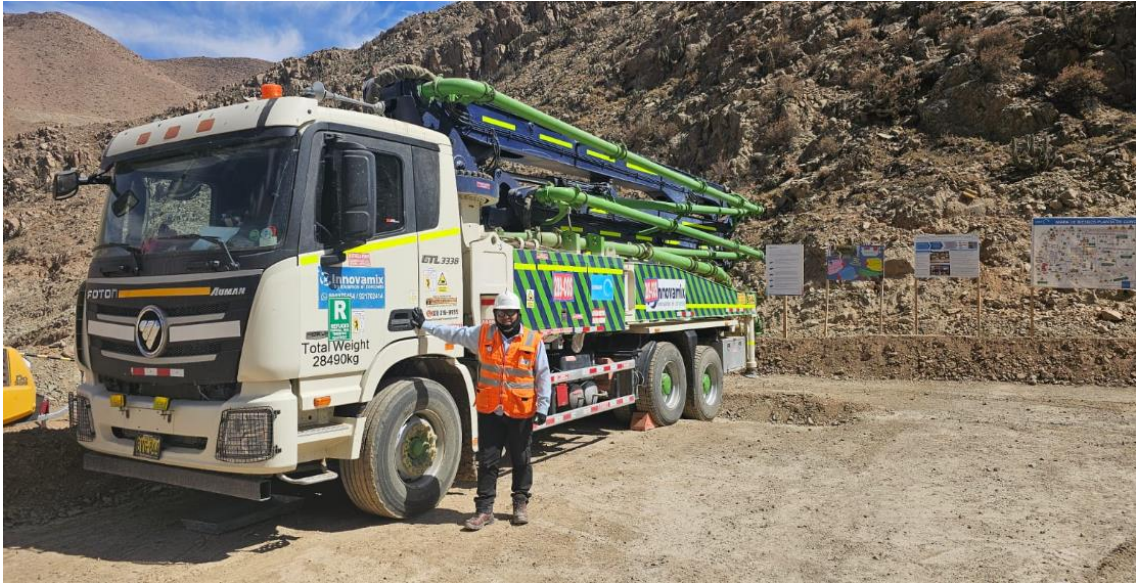
Imagen 70: Verificando la Planta de Concreto
