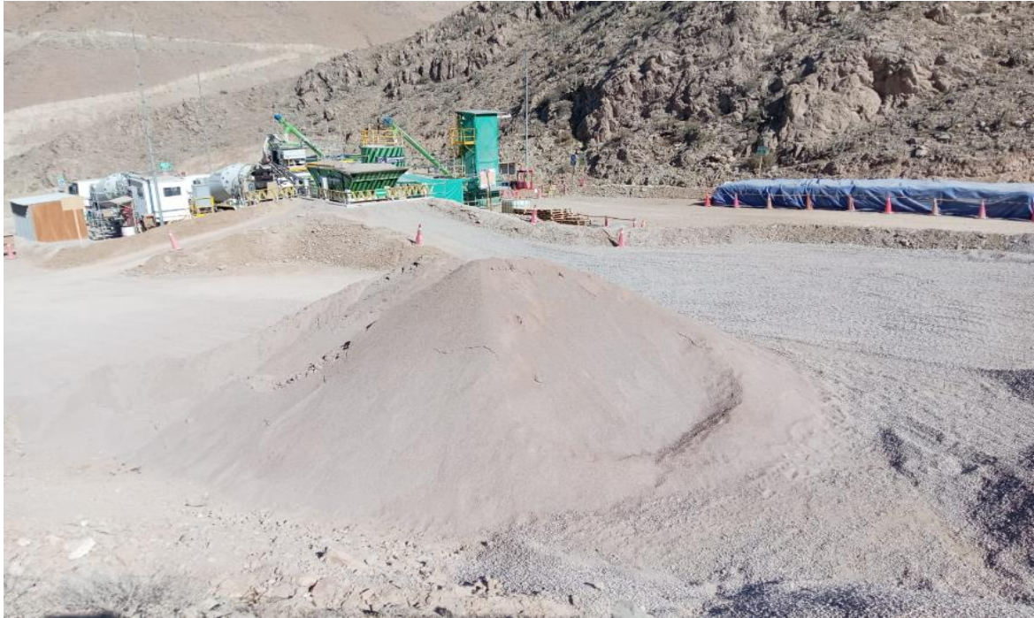
Imagen 72: Vista panorámica de la Planta de concreto (Parte de atrás)
