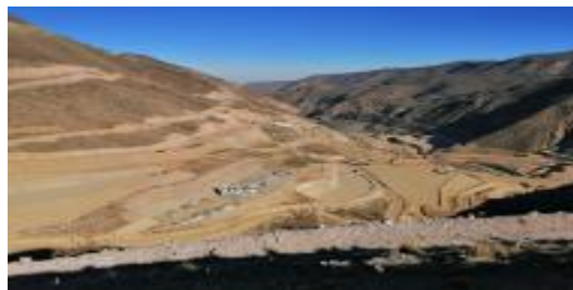
Imagen 3: Movimiento de Tierras masivo en Mina Quellaveco
