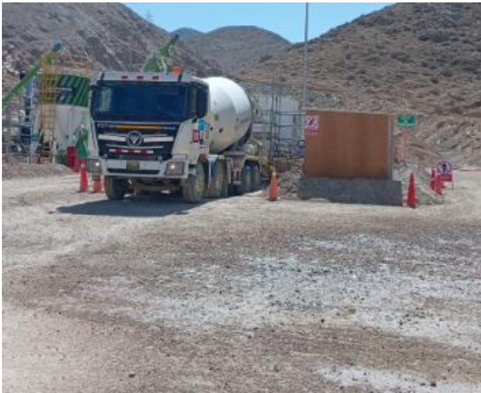
Imagen 73: Carguío de Concreto en el Mixer en la Planta de Concreto
