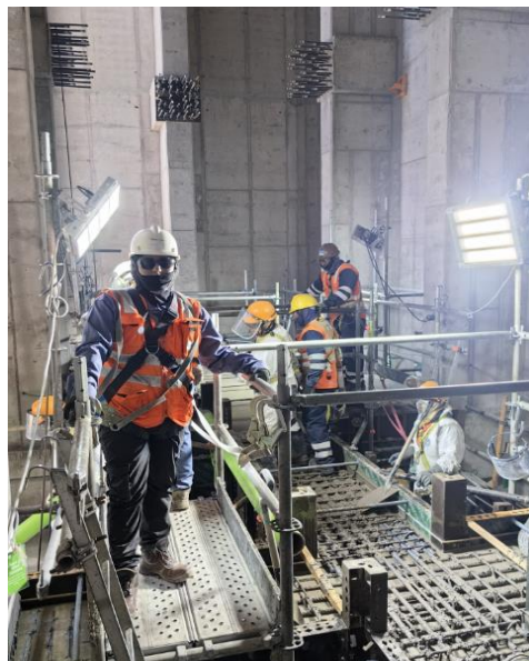
Imagen 44: Foto asistiendo en la supervisión del vaciado de la Viga Interna, TC.05
