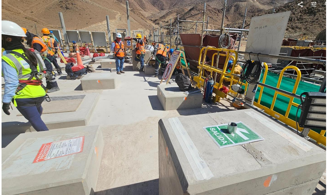
Imagen 41: Vaciado de la Losa Techo y sus pedestales, TC.05
