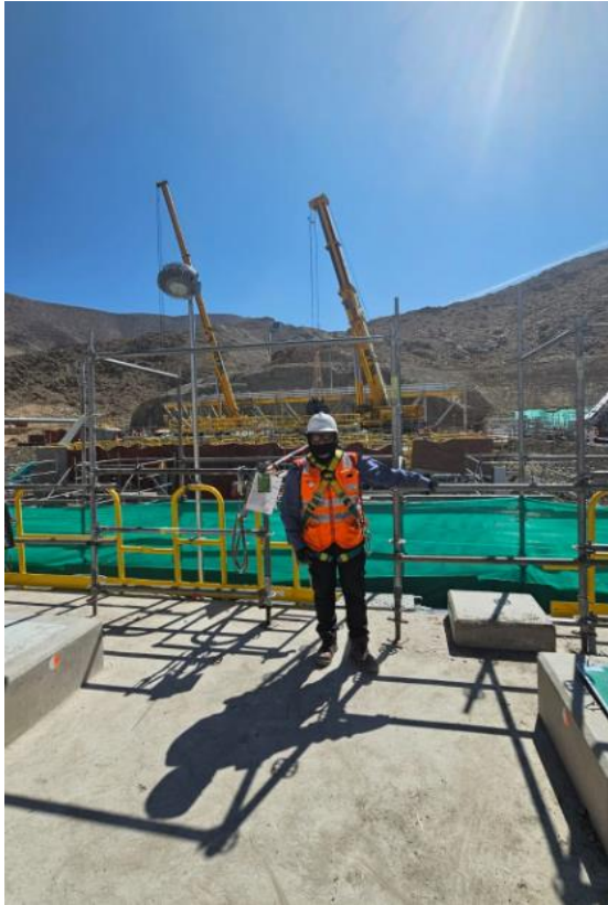
Imagen 14: Fotografía del Bachiller en la Losa techo de la TC.05
