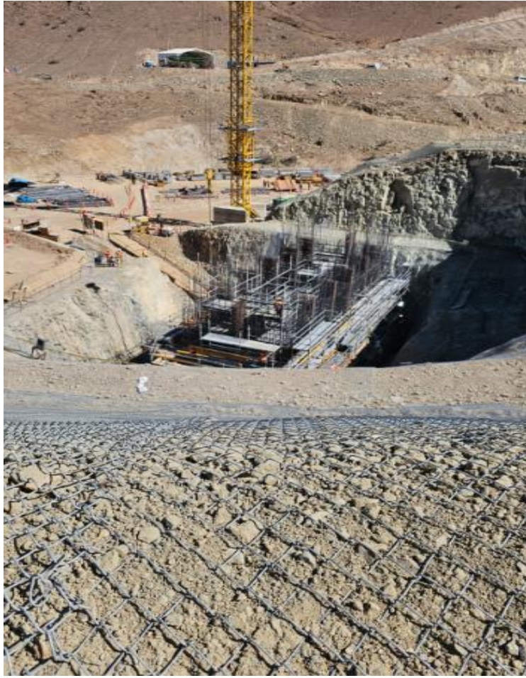
Imagen 54: Inicios de la Torre de Captación N°5 luego de vaciar la Zapata
