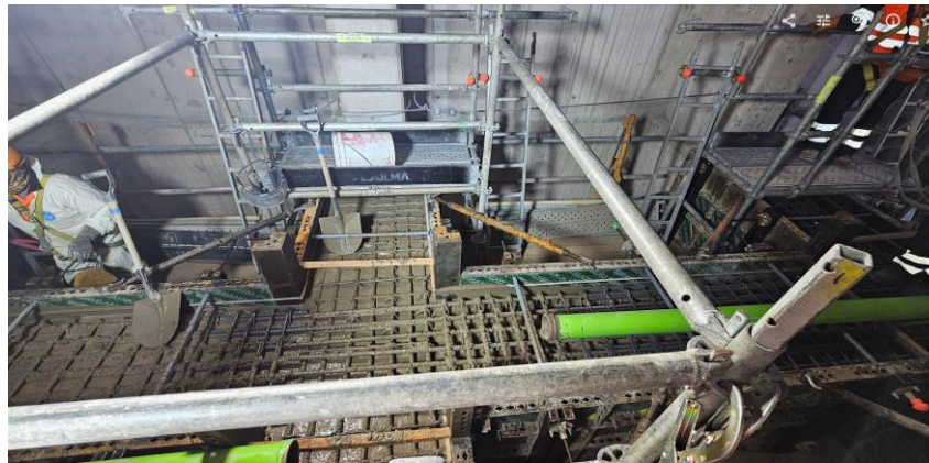
Imagen 43: Vaciado de la Viga interna, Concreto f'c = 300 \text{ kg/cm}^2 , TC.05
