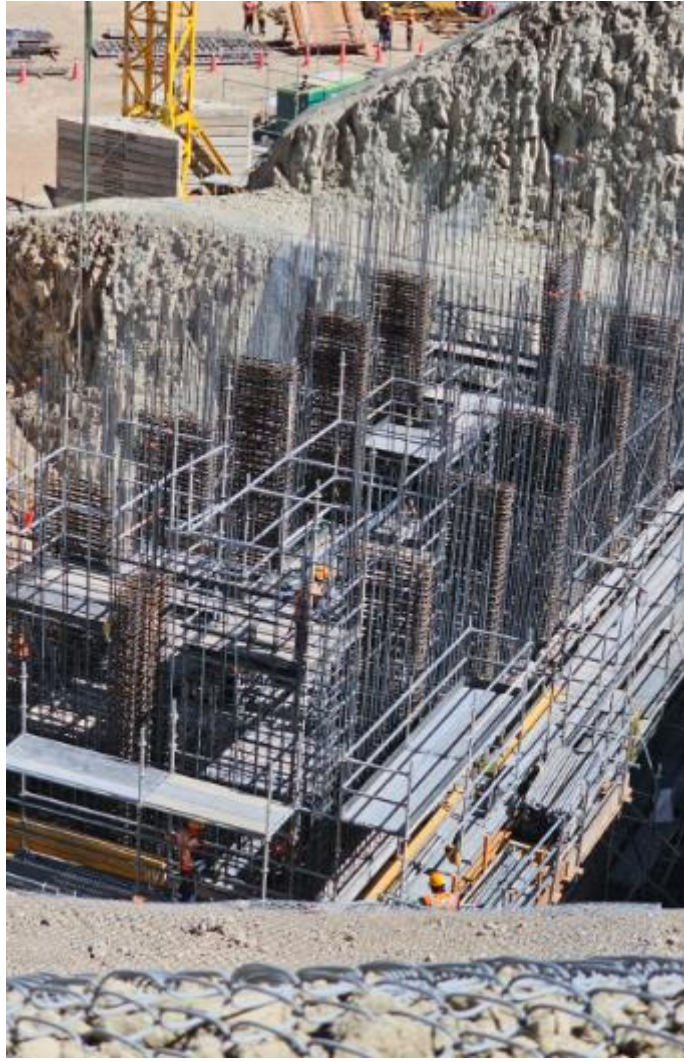
Imagen 57: Avance de la Torre de Captación N°5 en su Tercer Nivel
