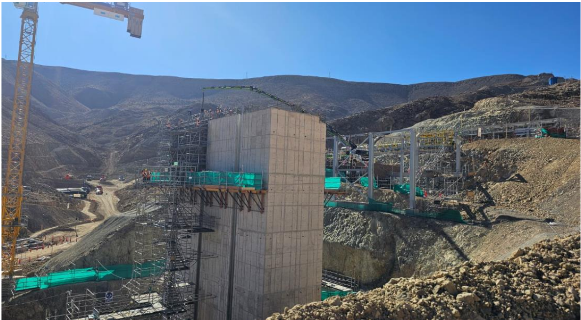
Imagen 61: Torre de Captación N°5 vaciado los 5 niveles
