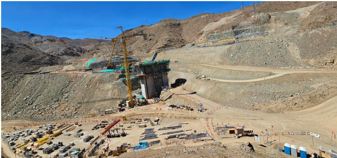
Imagen 69: Vista panorámica de la obra finalizando actividades
