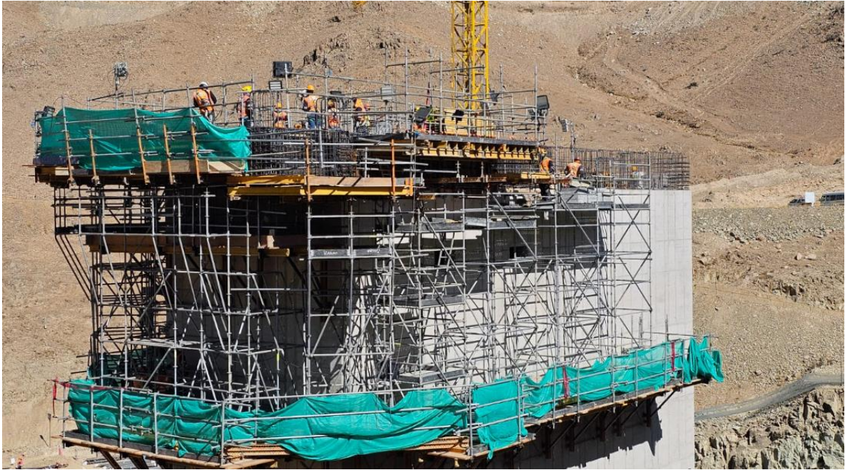
Imagen 62: Proceso Constructivo de la Losa Techo de la Torre
