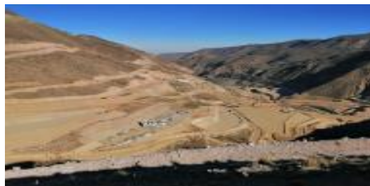
Imagen 3: Movimiento de Tierras masivo en Mina Quellaveco
