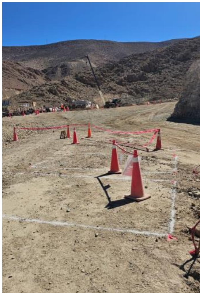
Imagen 58: Trazos de Topografía para excavación y colocación de los cajones disipadores y drenajes.
