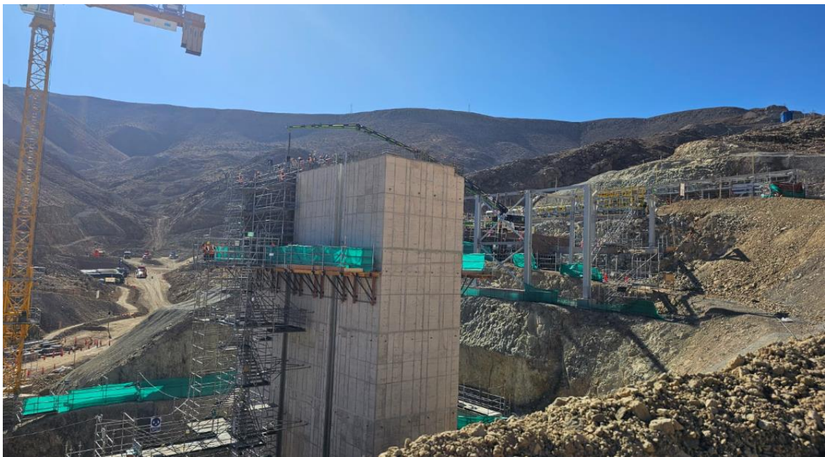
Imagen 61: Torre de Captación N°5 vaciado los 5 niveles
