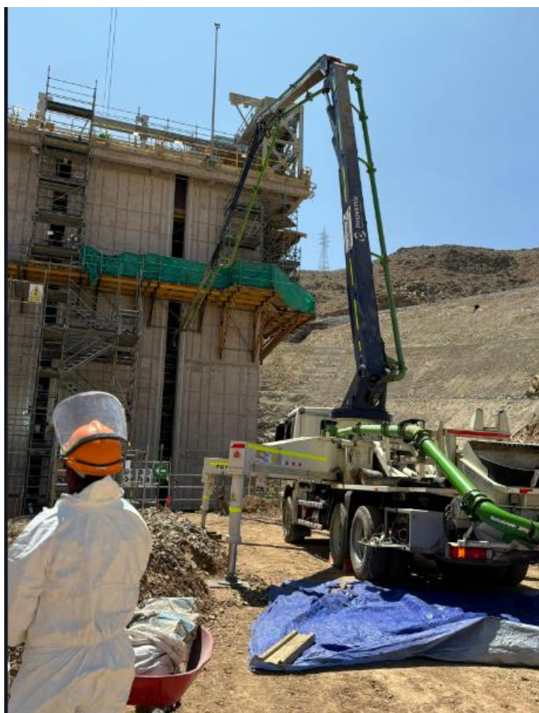
Imagen 65: Vaciado de las vigas internas de la Torre de Captación N°5
