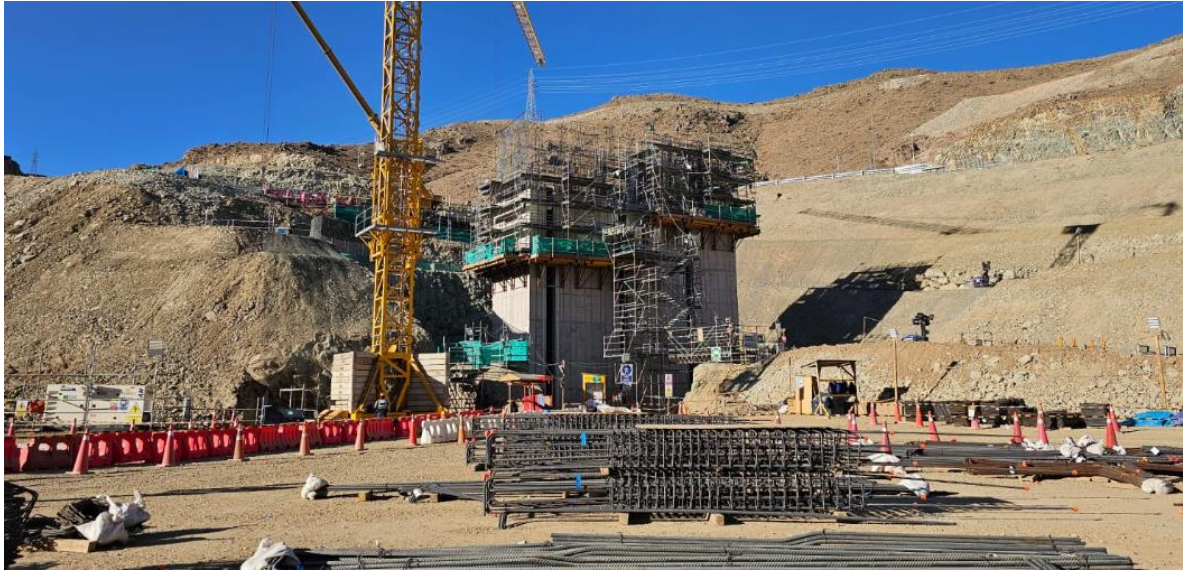
Imagen 60: Torre de Captación N°5 vista panorámica
