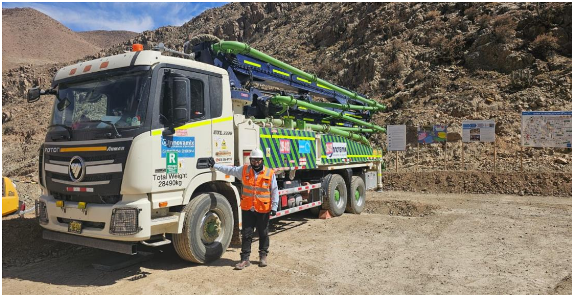
Imagen 70: Verificando la Planta de Concreto
