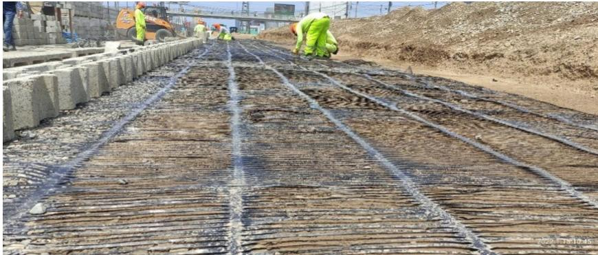
*Fuente: Elaboración propia***Figura 35.***Aseguramiento de geomallas uniaxiales*
