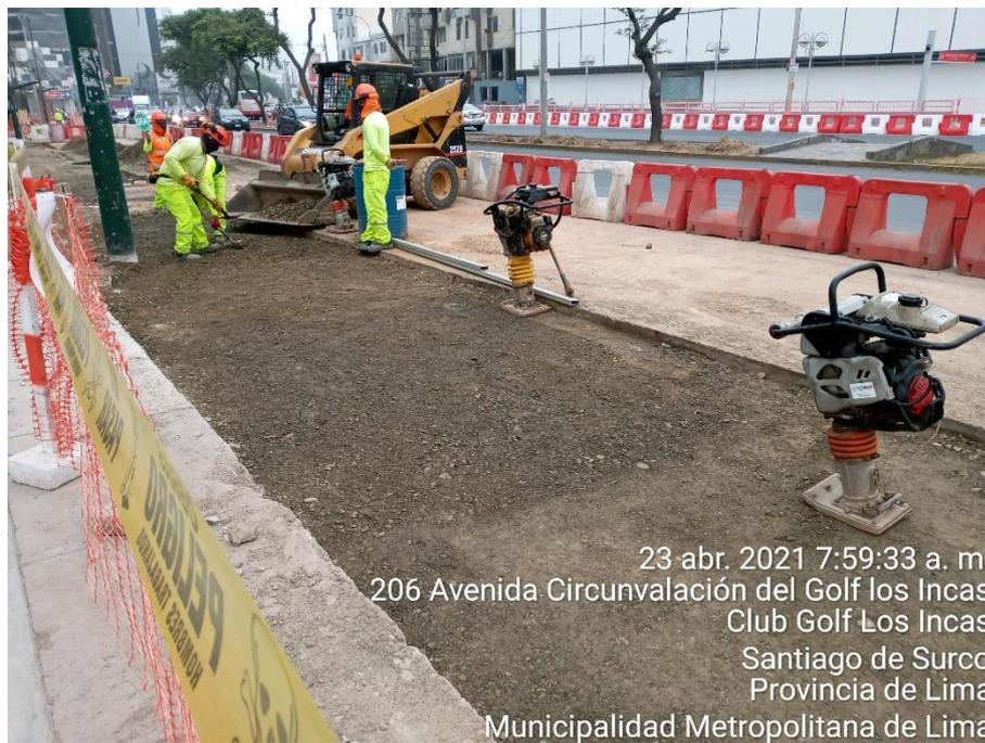
*Nota.* Supervisión de la conformación de base granular como parte de la estructura del muro de tierra armada.
