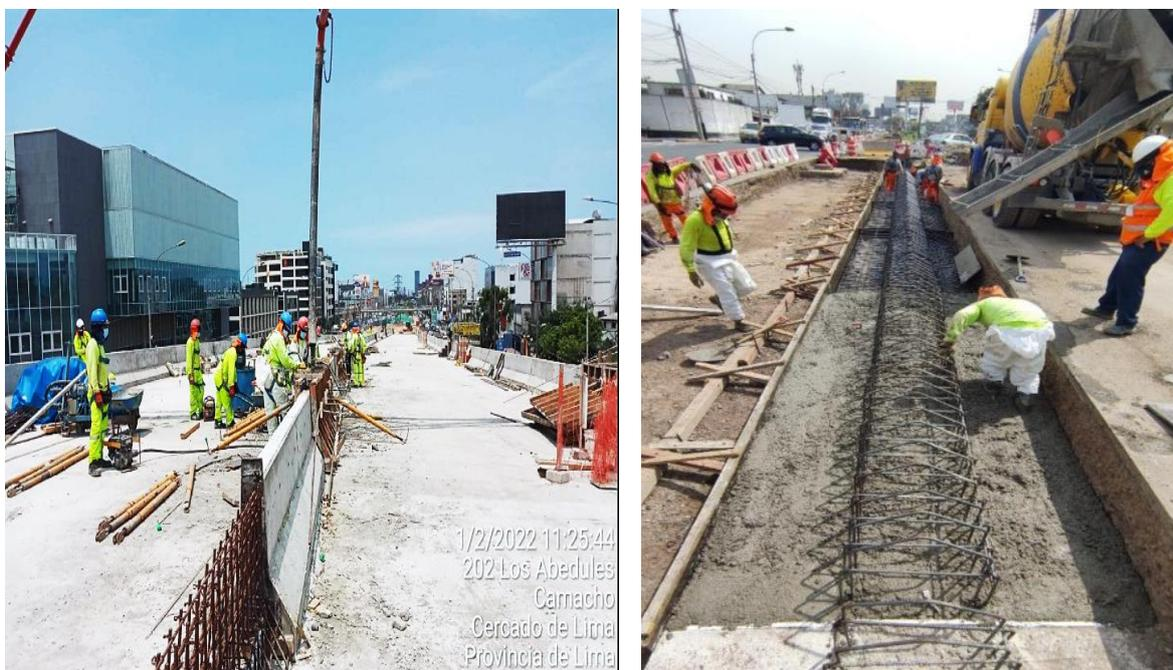
*Nota.* Proceso de vaciado de muros New Jersey (resistencia  $f'c=280$  kg/cm<sup>2</sup>). Se observa el vaciado en el tablero (izquierda) y en infraestructura vial (derecha). Fuente: Elaboración propia.
