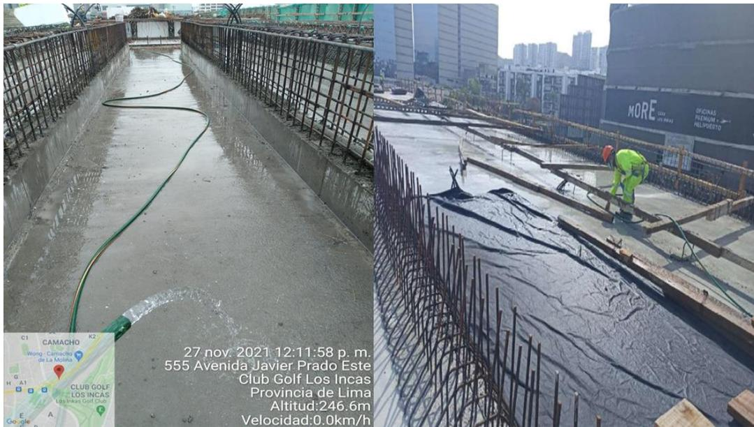
*Nota.* Proceso de curado de la losa del puente: a la izquierda, curado correspondiente a la primera etapa; a la derecha, curado en la segunda etapa. Fuente: Elaboración propia.
