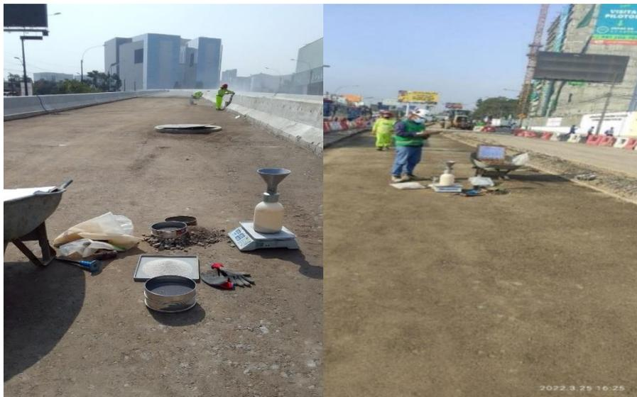
*Nota.* Ensayos de densidad de campo en capas de base granular y subbase granular, ejecutados en el muro de tierra armada. Fuente: Elaboración propia.
