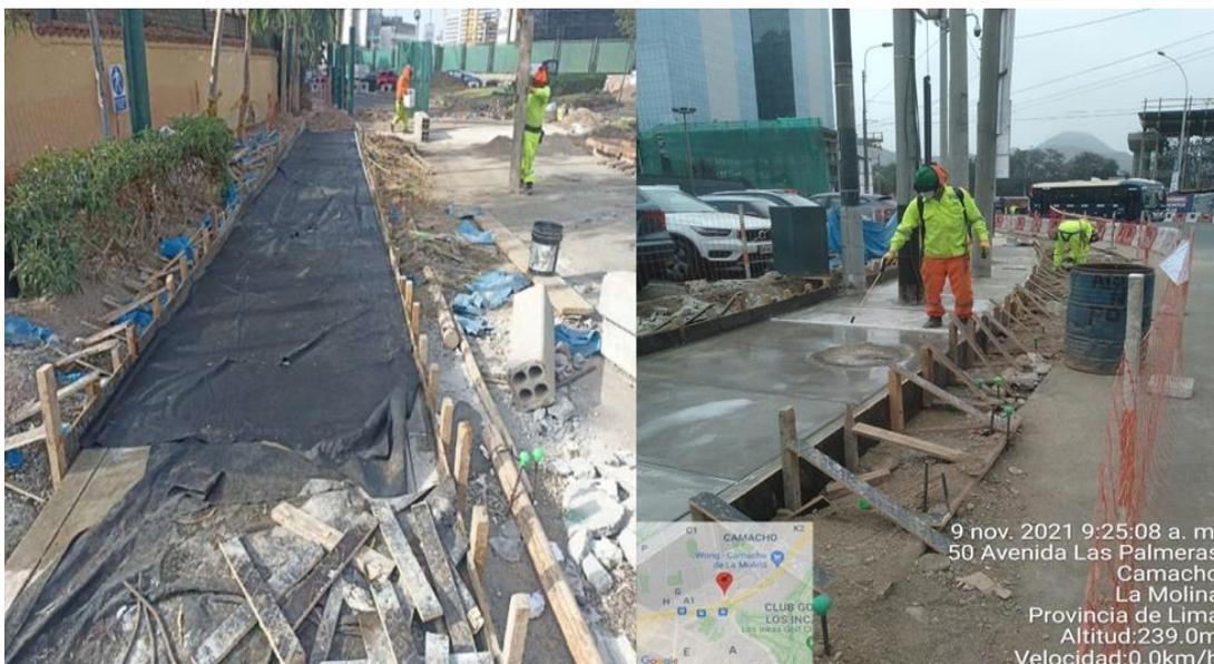
*Nota.* Curado de veredas: a la izquierda, se observa el uso de agua y geotextil; a la derecha, la aplicación de un curador químico por aspersión. Elaboración propia.
