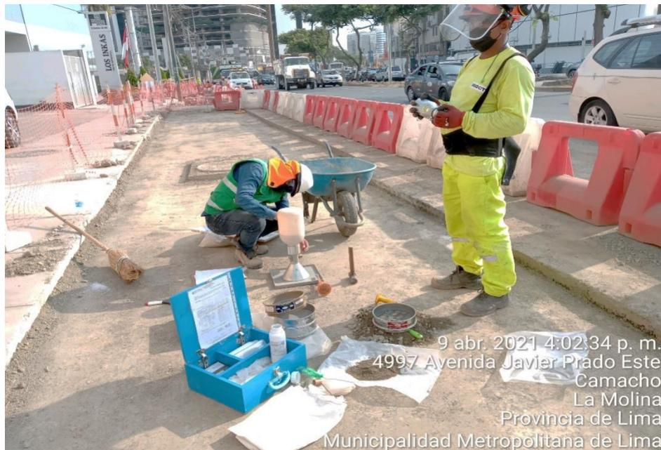
*Nota.* ensayos de densidad de campo en capas de base granular y subbase granular, en muro de tierra armado.
