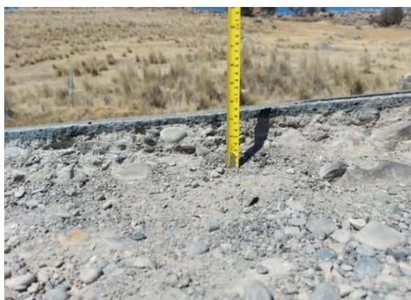
Figura 3. Pavimento de la carretera.
