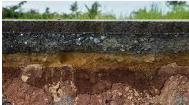
Figura 6. Capa base del pavimento flexible.
