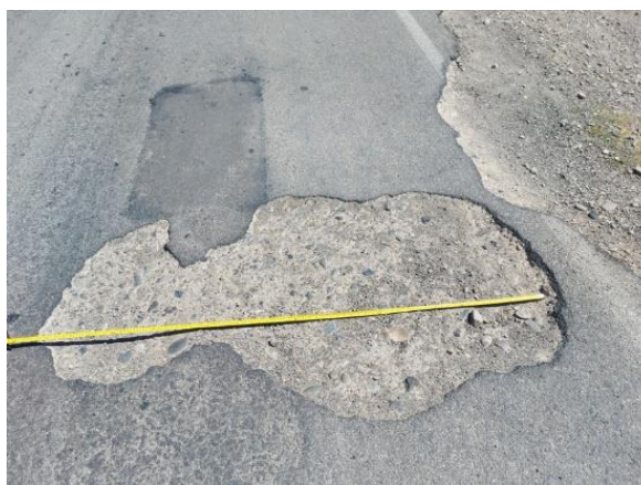
Figura 4. Tramo siguiente de la carretera
