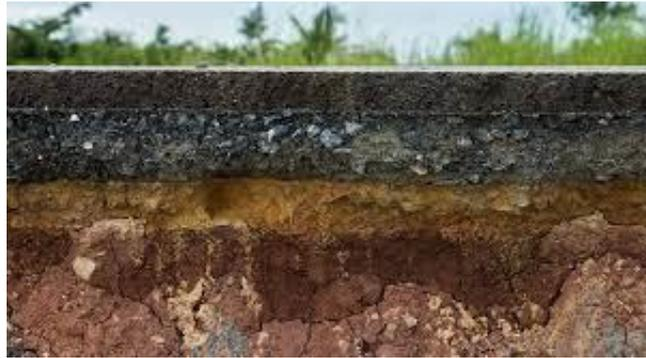
**Figura 6.** Capa base del pavimento flexible.
