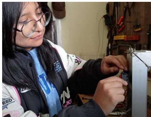
Figura 12. Instalación de los switches en el soporte del sistema.
