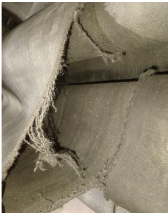
Figura 5. Rotura producida por desgaste de tela filtrante
