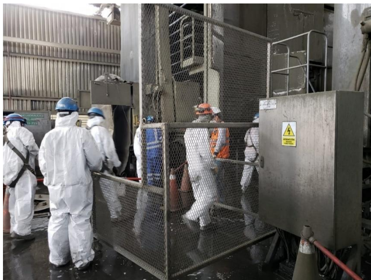
Figura 4. Preparativos para intervención de filtro FL001
