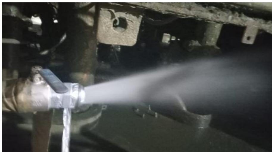
Figura 18. Evaluación de funcionamiento de sistema de lavado Fuente: Elaboración propia
