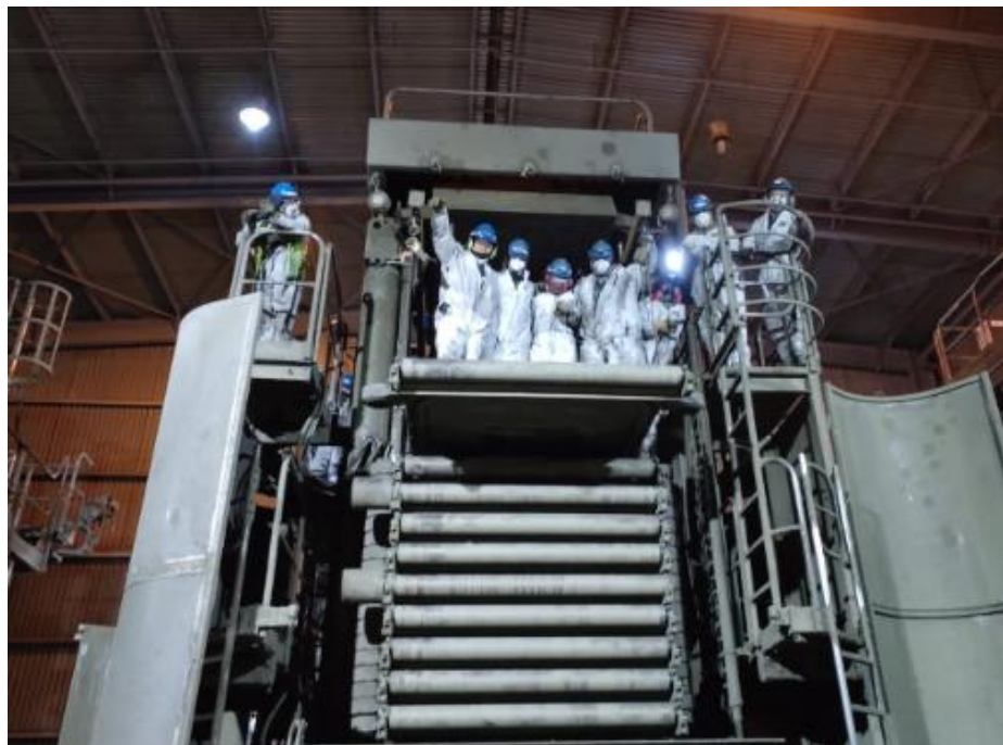
Figura 16. Instalación completada de sistema de lavado Fuente: Elaboración propia
