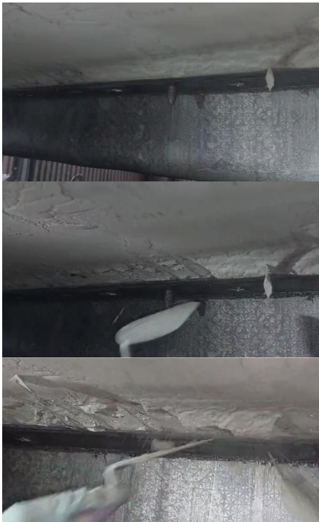
Figura 9. Proceso de retiro de calicha acumulada en raspador Fuente: Elaboración propia
