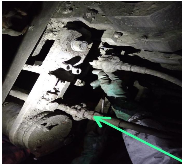
Figura 14. Proceso de conexión de mangueras Fuente: Elaboración propia
