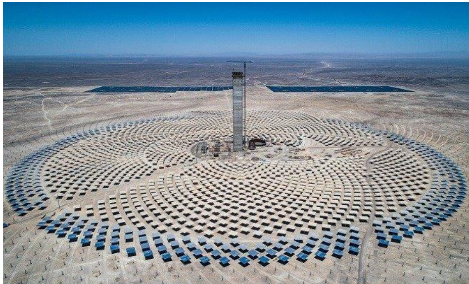
Figura 1. Reflectores de torre de energía. Tomada de Diseño de sistemas solares concentrados: análisis y perspectivas, por Martínez y López, A., 2018.
