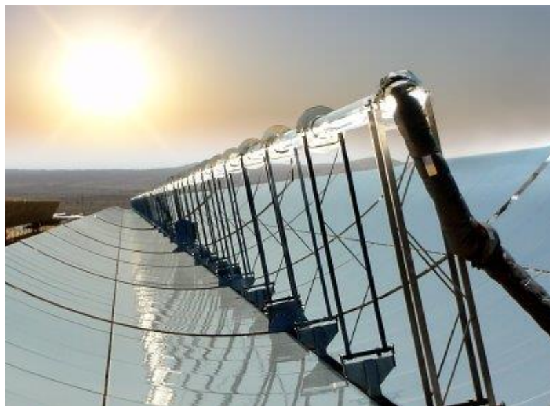
Figura 2. Colectores cilindro-parabólicos. Tomada de: Solar Engineering of Thermal Processes, por Duffie y Beckman, 2013.
