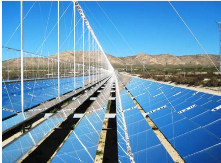
Figura 5. Reflectores lineales Fresnel de concentración. Tomada de: Solar Engineering of Thermal Processes, por Duffie y Beckman, 2013.
