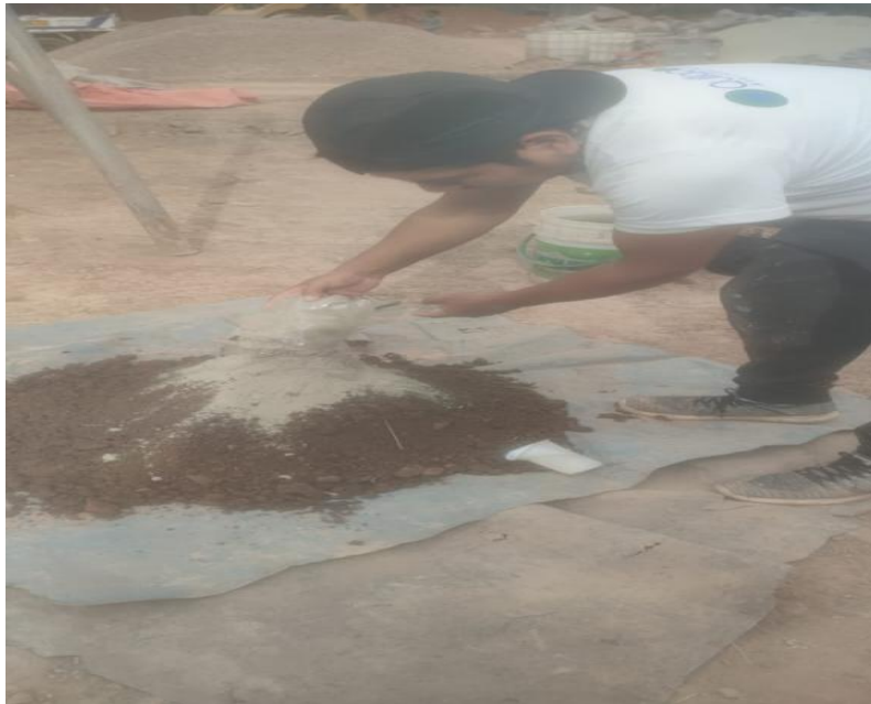
Figura 47. Mezclado de cemento Portland (tipo IP) para el mezclado con tierra para adobes
