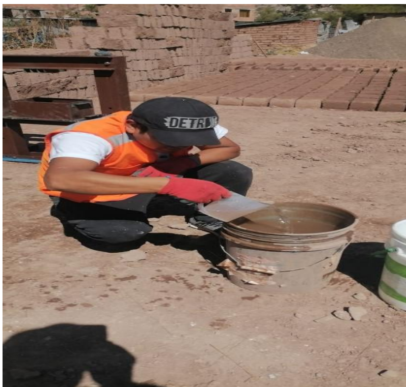
Figura 45. Mezclado de Estabilizador (Z) con agua
