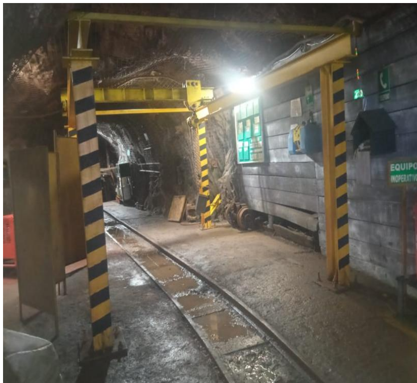
Figura 41. Trabajos en interior de mina nivel 18 vetas
