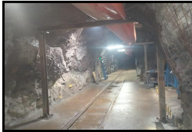
Figura 11. Talleres en interior mina sin condicion para reparacion y mantenimientos de locomotora y carros Gramby
