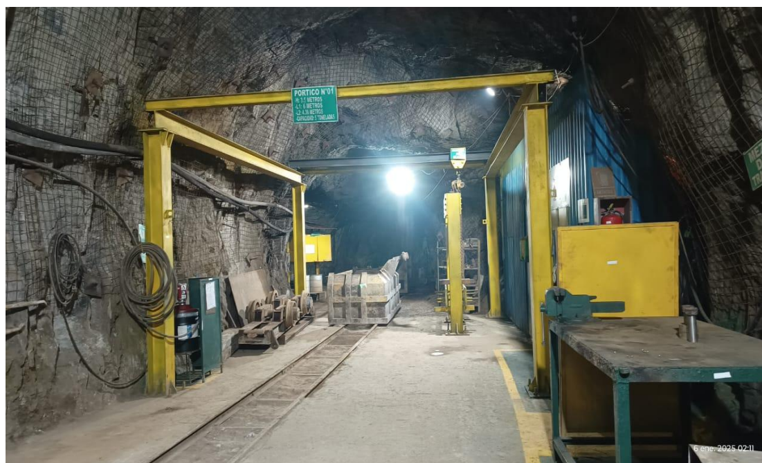
Figura 43. Taller nivel 21 vetas se implementó un pórtico para el izaje de las reparaciones .
