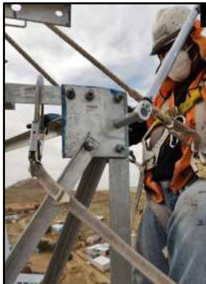
Figura 69. Torque de la torre.
