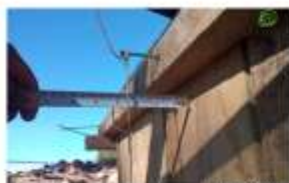
VERIFICACION DE ESPACIAMIENTO DE ACERO EN PLATEA
