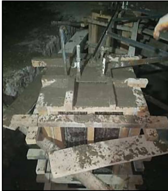
Figura 44. Vaciado de concreto en platea y pedestales.
