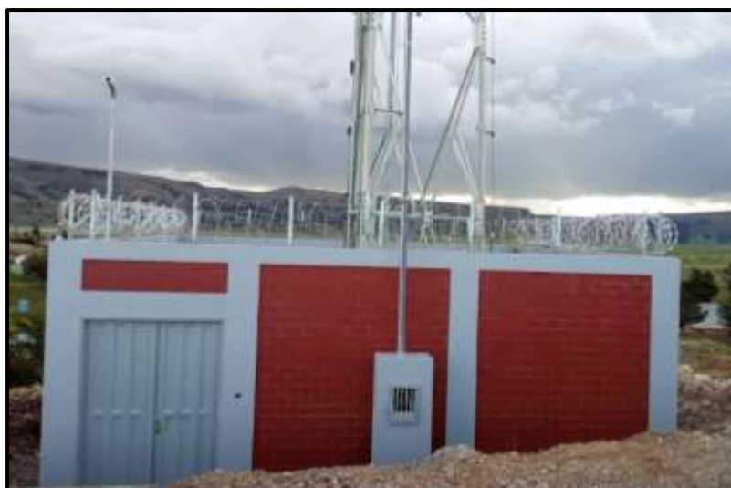
Figura 91. Control de termino de pintura.
