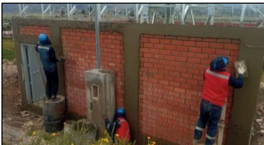
Figura 88. Control del acabado en columnas, vigas y sobrecimientos.
