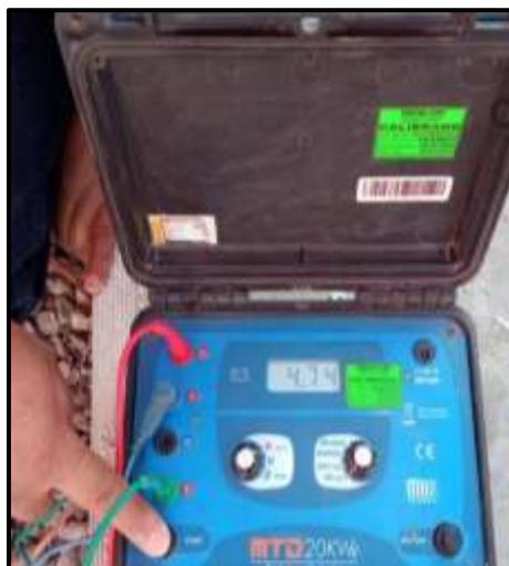
Figura 99 Medición de los pozos a tierra.
