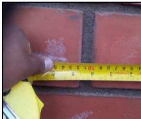
Figura 81. Control de juntas en muro de ladrillo.
