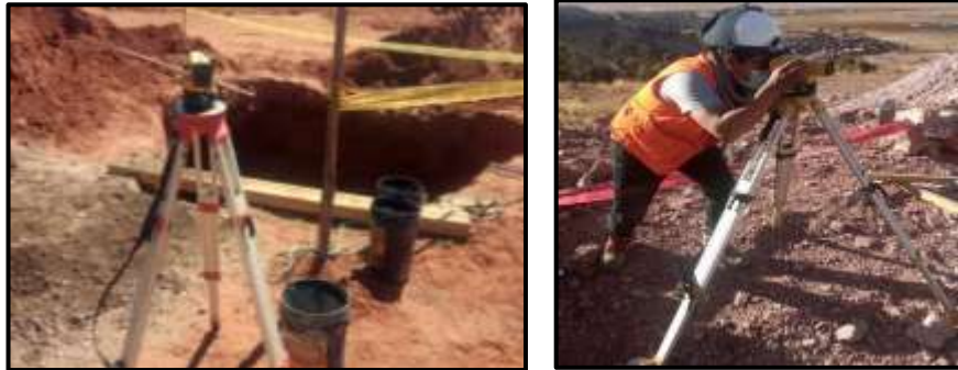
Figura 22 y figura 23. Control de nivelación de la excavación.
