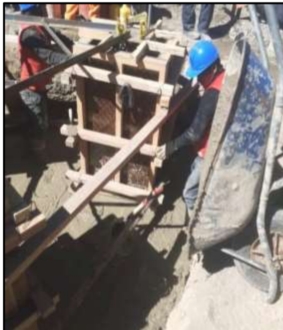
Figura 41. Concreto en platea y pedestales.
