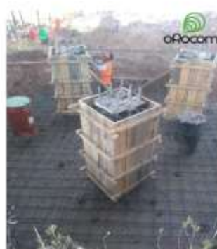
VERIFICACION DE ENCOFRADO DE PEDESTALES
