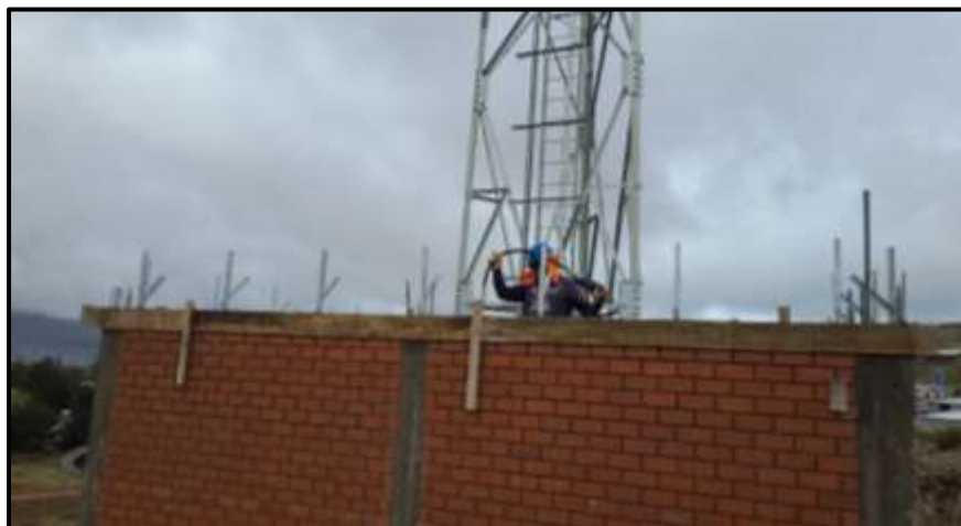
Figura 87. Vaciado de vigas de confinamiento.
