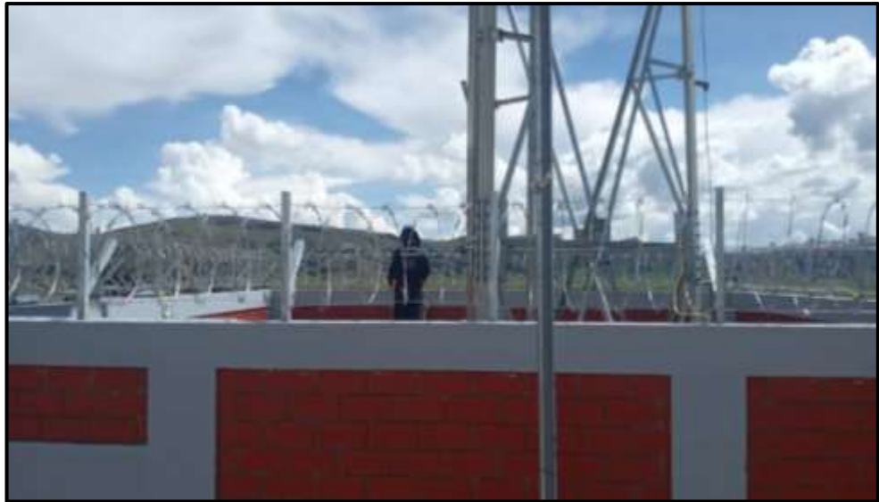
Figura 89. Control de la instalación de concertina.
