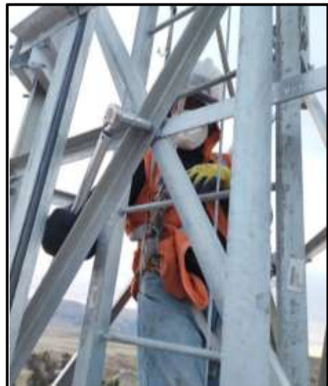
Figura 70. Torque de la torre.
