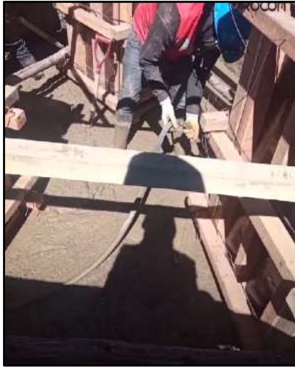
Figura 42. Vibrado de concreto.
