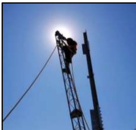
Figura 61. Montaje de torre.
