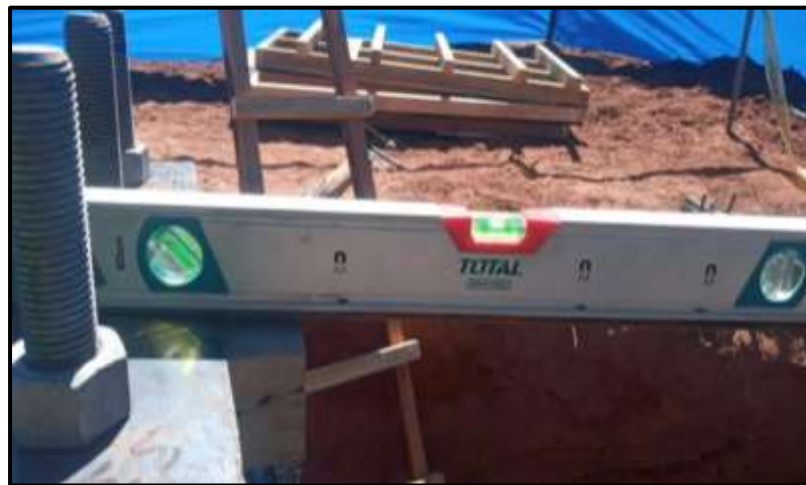
Figura 35. Nivelado de plantilla.
