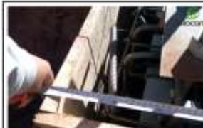
VERIFICACION DE ALTURA DE PEDESTALES
