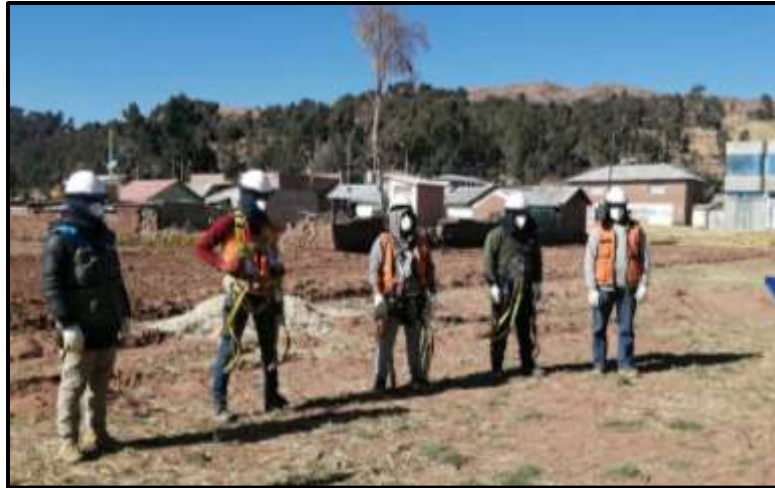
Figura 60. Cuadrilla de montaje de torre.
