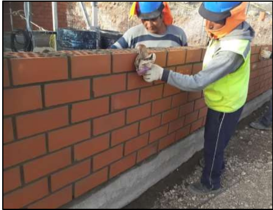
Figura 85. Control de bruñado en muro.
