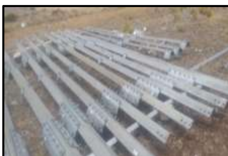
Figura 57. Prearmado de elementos de la torre.
