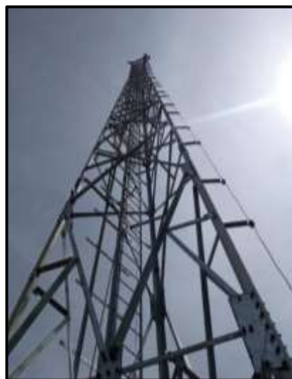
Figura 78. Cable de pararrayo. Fuente: Elaboración propia
