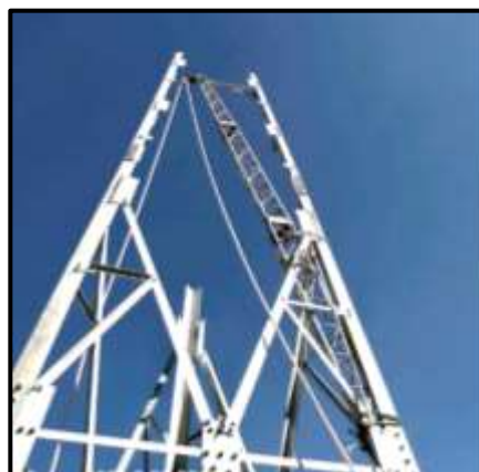
Figura 62. Montaje de torre.
