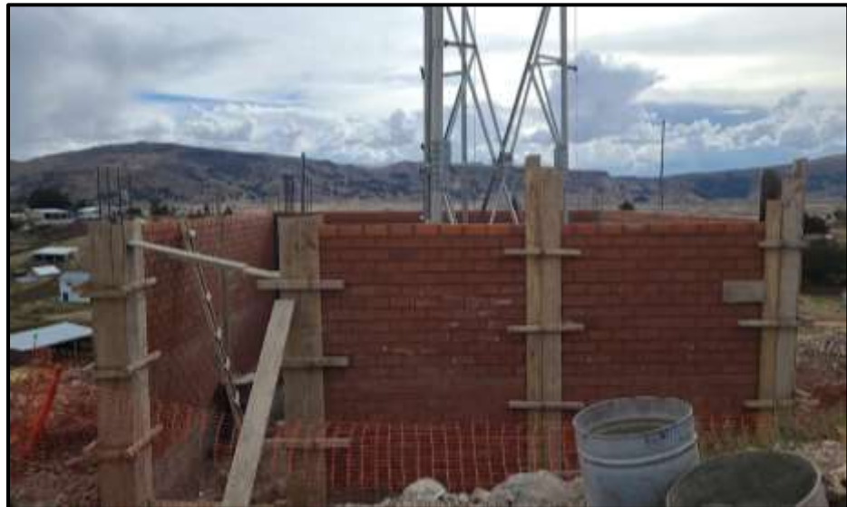
Figura 86. Vaciado de columnas de confinamiento.
