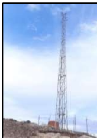
Figura 64. Montaje de torre.
