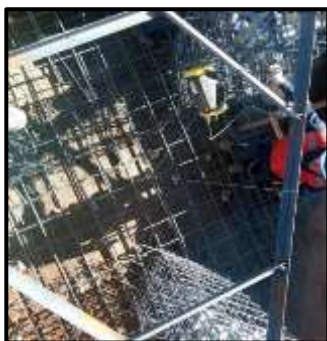
Figura 33. Instalación de plantilla
