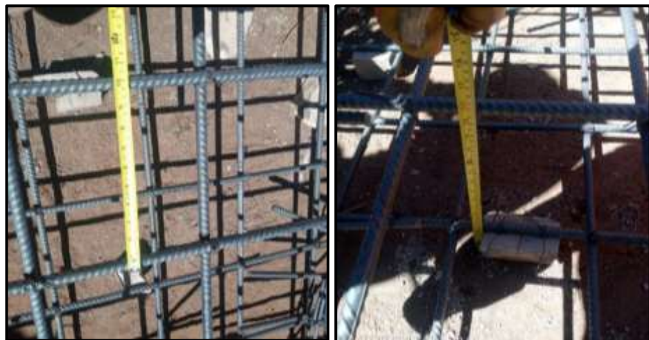
Figura 37 y figura 38. Verificación de acero en platea.
