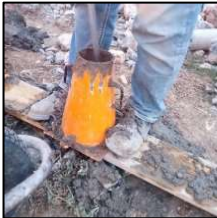
Figura 51 y figura 52. Control del slump.
