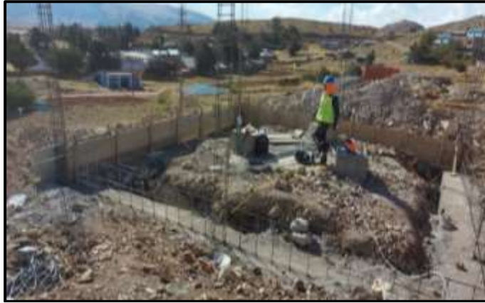
Figura 50. Tejido de acero en sobrecimiento.
