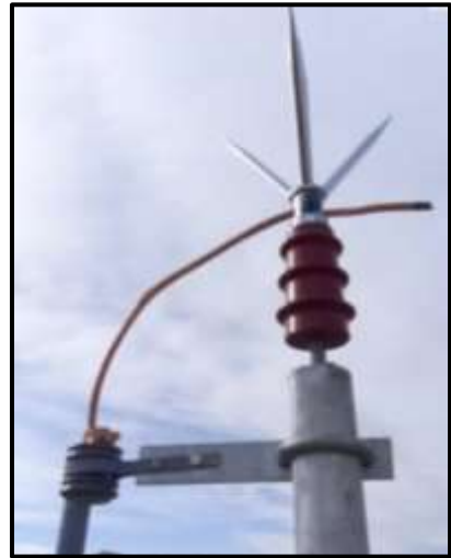
Figura 72. Pararrayo tipo franklin. Fuente: Elaboración propia
