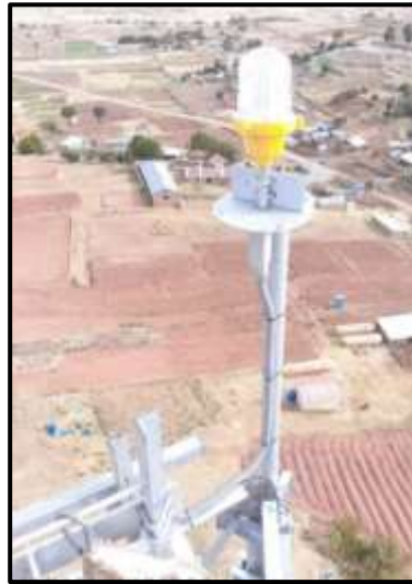
Figura 71. Luz de balizaje. Fuente: Elaboración propia
