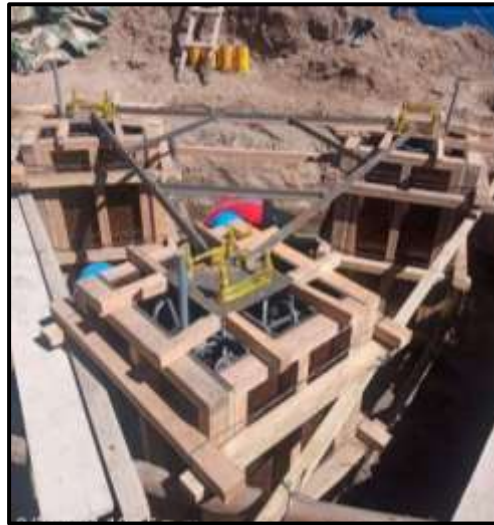
Figura 34. Encofrado de pedestales.
