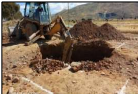
Figura 21. Excavación de terreno
