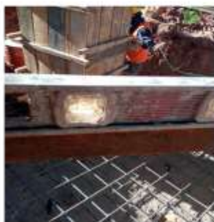
VERIFICACION DE LA NIVELACION DE LA PLANTILLA
