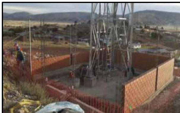
Figura 84. Jornada de trabajo de muro de ladrillo.
