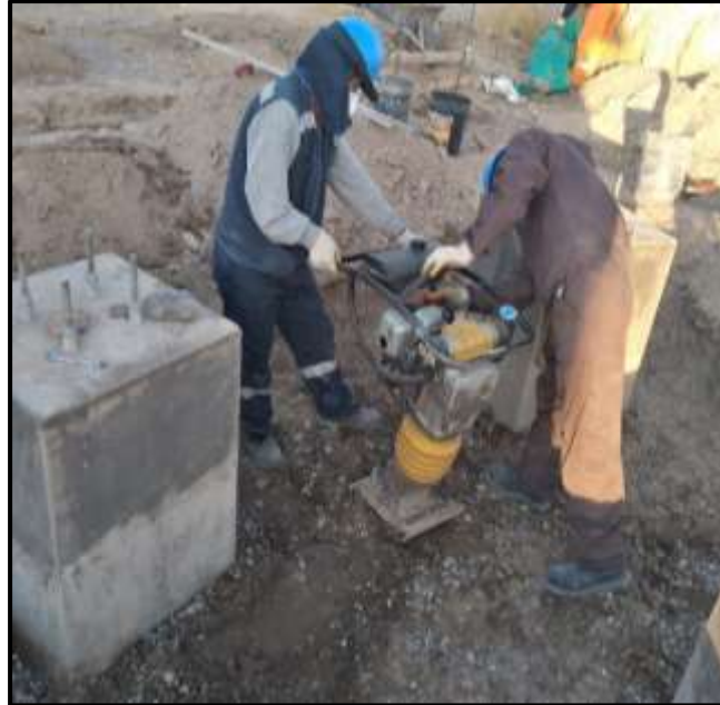
Figura 46 Proceso de compactado de terreno.
