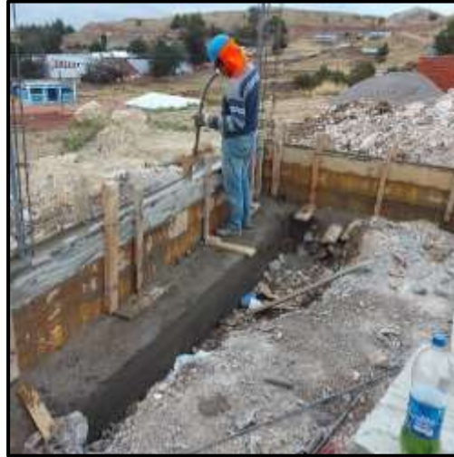
Figura 53. Proceso de vibrado de concreto.
