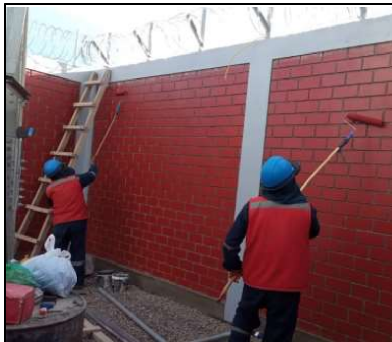
Figura 90. Control de pintura en cerco perimetrico.
