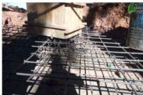
VERIFICACION DE ESPACIAMIENTO DE ACERO EN PLATEA
