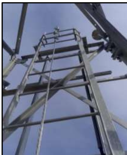
Figura 75. Línea de vida. Fuente: Elaboración propia
