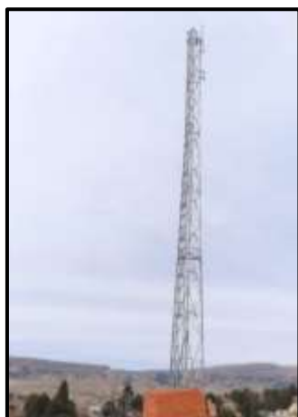
Figura 63. Montaje de torre.
