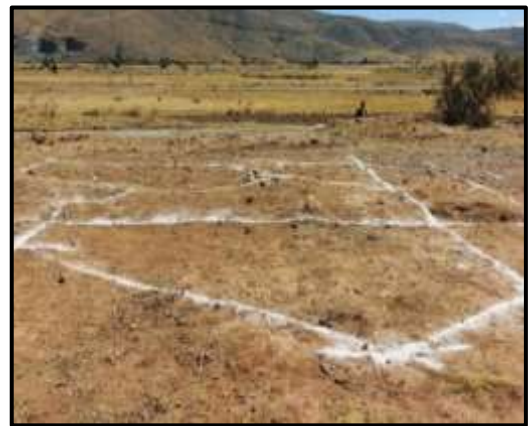
Figura 20. Trazo área de cimentación de torre
