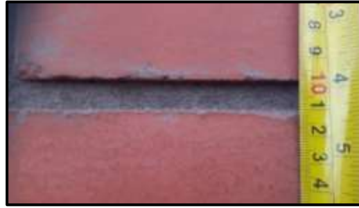
Figura 82. Control de juntas en muro de ladrillo.
