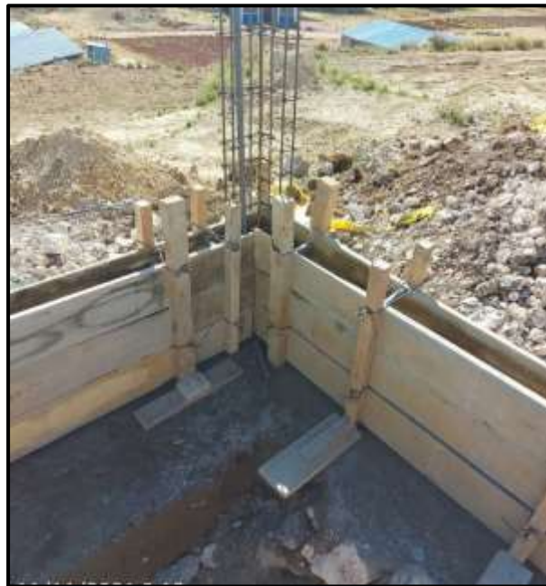
Figura 49. Encofrado de sobrecimiento.
