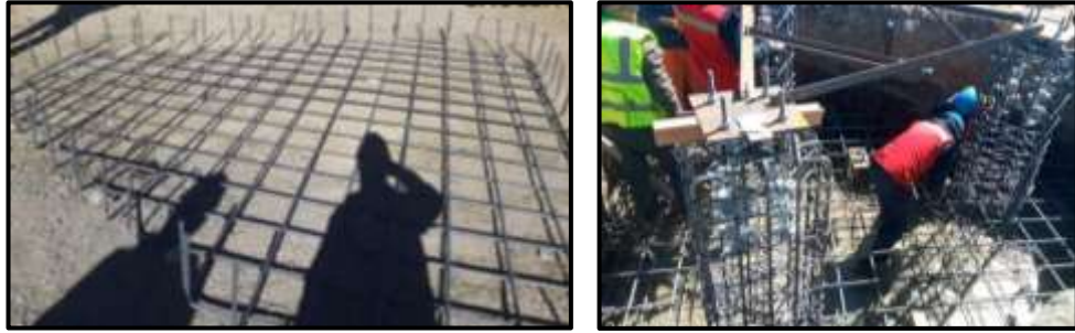
Figura 29 y figura 30. Acero para platea y pedestales.
