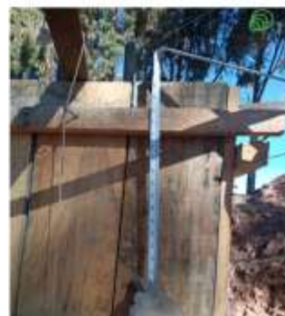
VERIFICACION DE ALTURA DE PEDESTALES
