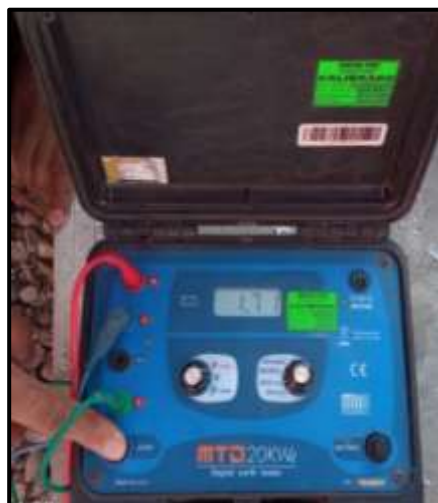
Figura 97. Medición de los pozos a tierra.
