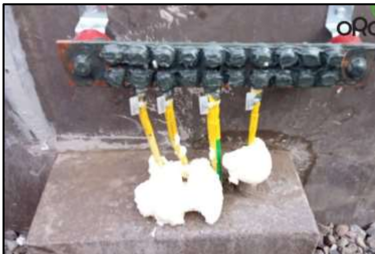
Figura 100. Barra bornera MGB.
