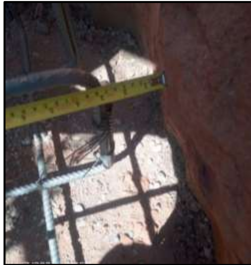
Figura 36. Recubrimiento del acero en platea.
