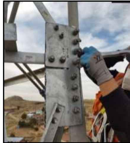
Figura 68. Torque de la torre.
