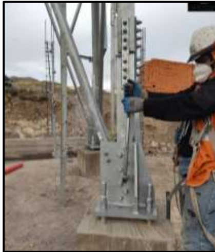
Figura 67. Torque de la torre.
