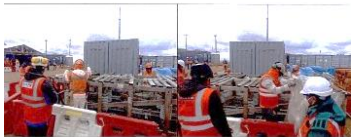
Figura 11. Inspecciones respectivas por la supervisión CQA y CQC
