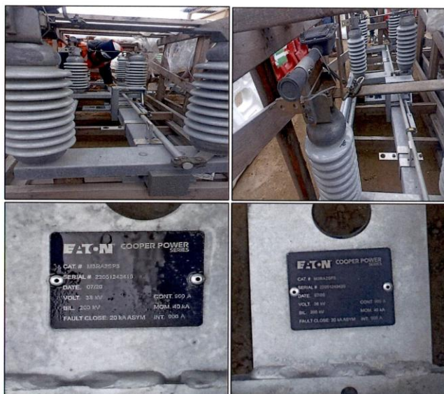
Figura 12. Prueba de equipos – Test Report de dos seccionadores
