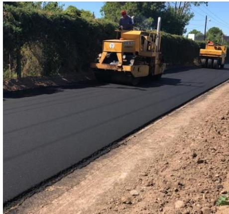
**Figura 8.** *Carpeta Asfáltica*
