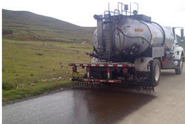
**Figura 7.** *Imprimación Asfáltica*
