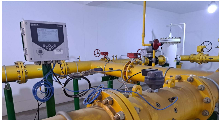
Figura 27. Unidad correctora – Medidor de Gas Natural sincronizados
