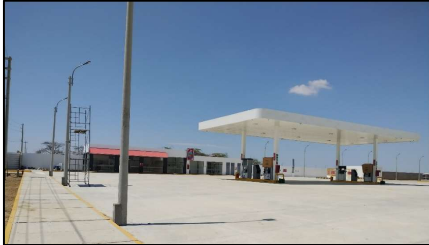
Figura 15. Verificación de edificaciones existentes
