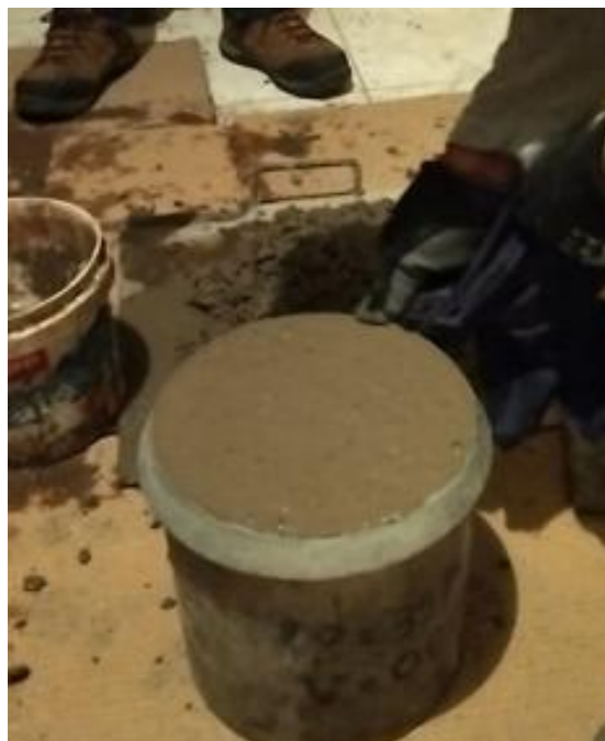
Figura N°4: Enrazado de ultima capa de concreto en estado fresco
