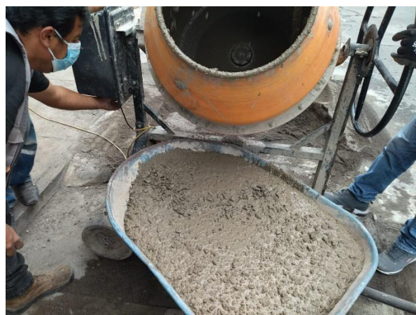
Figura N°6: Verificación visual de la mezcla de concreto
