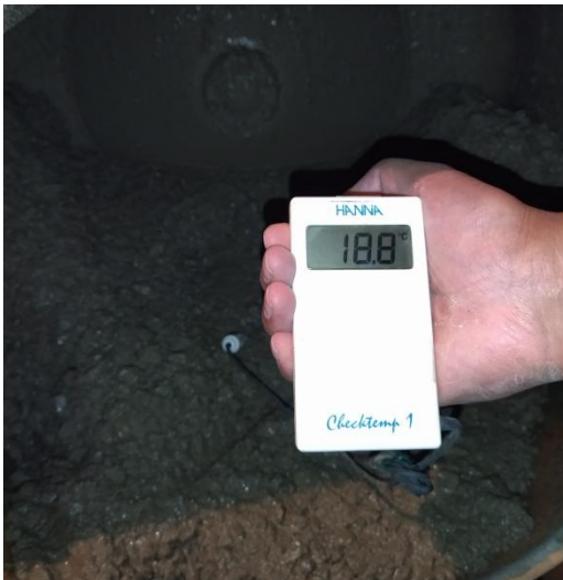
Figura N°3: Temperatura del concreto en estado fresco
