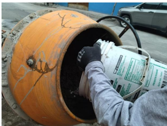
Figura N°1: Colocación de agregados grueso, cemento y agua para la mezcla
