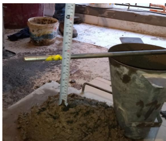
Figura N°6: Medición de Slump
