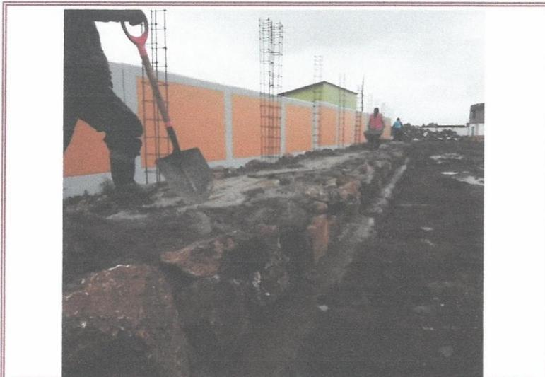
VISTA 05: Se puede apreciar el vaciado de concreto ciclópeo 1:10 + 30% pg en graderíos (primer peldaño).
