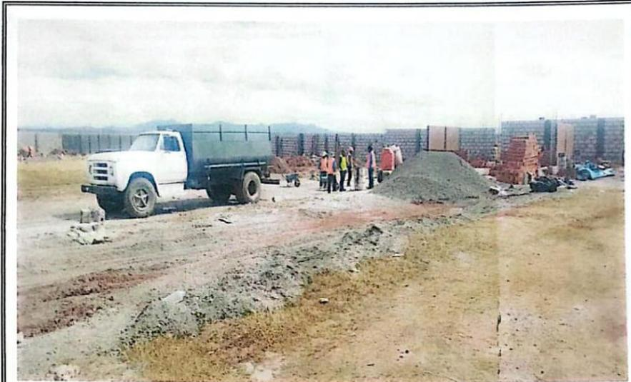
FOTOGRAFIA 11.- EN LA FOTOGRAFÍA SE OBSERVA REALIZANDO EL ASENTADO DE LOS MUROS DE LADRILLOS KING KONG DE 18 HUECOS PARA LOS SSHH. COMO TAMBIEN SE MUESTRA LA TRASLADO DE AGUA CON LA CISTERNA DE LA MUNICIPALIDAD.
