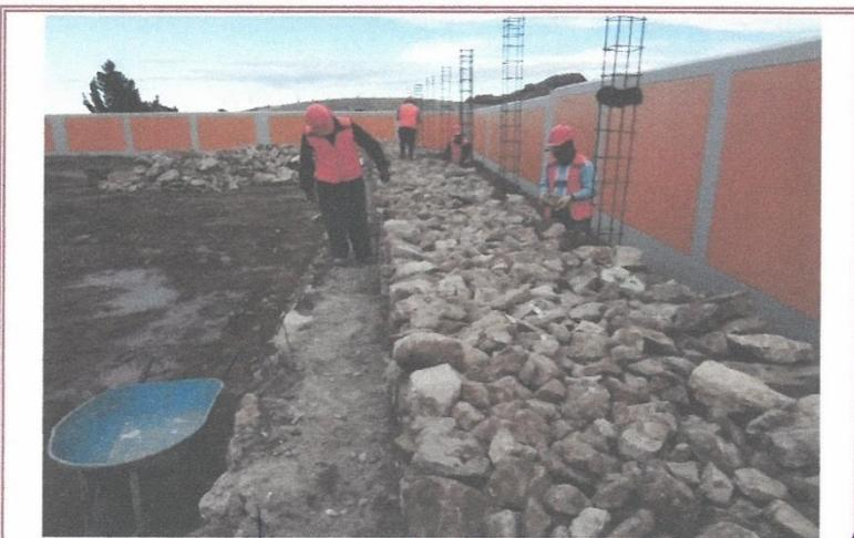
VISTA 06: Se puede apreciar la colocación de piedra grande en graderíos(segundo peldaño).
