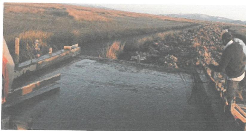
En la imagen se aprecia la culminación del vaciado de la losa en pontón.
