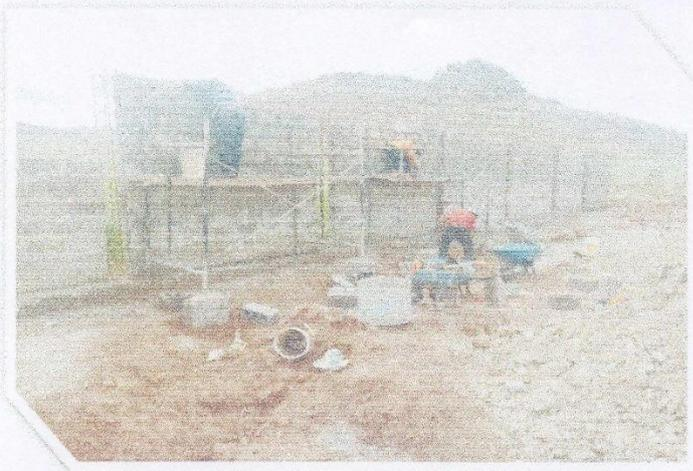
FIGURA N° 10: Se Observa En La Vista Fotográfica Los Trabajos De Asentado de Muros de Bloqueta
