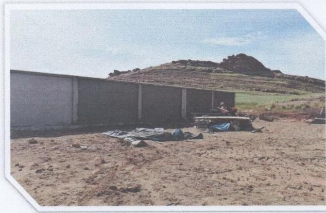
FIGURA N° 04: Se Observa En La Vista Fotográfica Los Trabajos de Tarrajeo de Muros y Sobrecimiento
