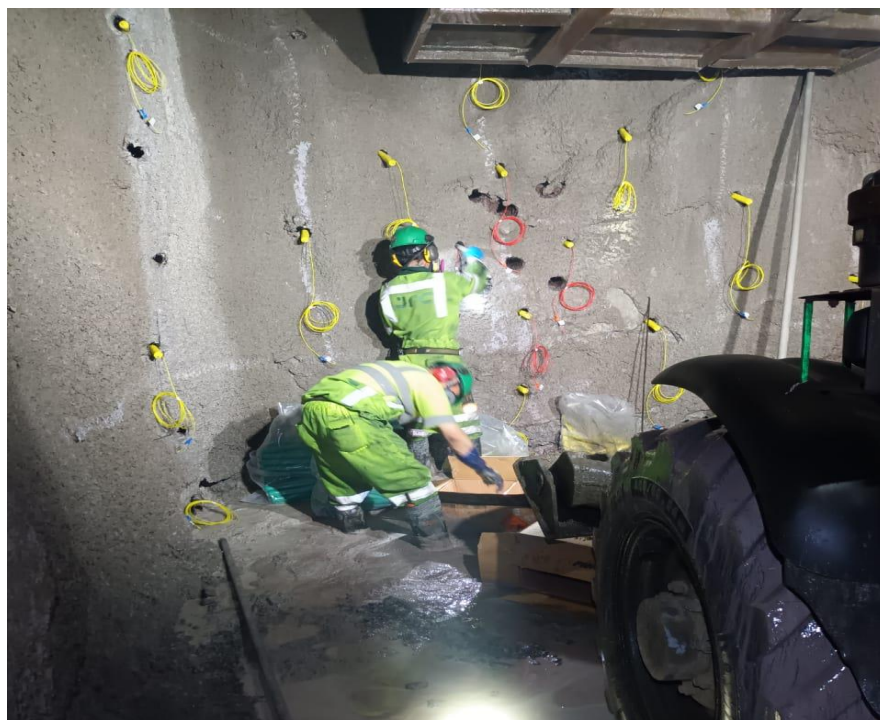
Figura 18: Proceso de carguío de frente con explosivos
