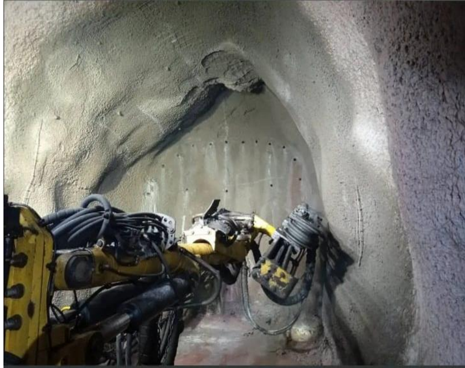
Figura 16: Proceso de perforación de frente
