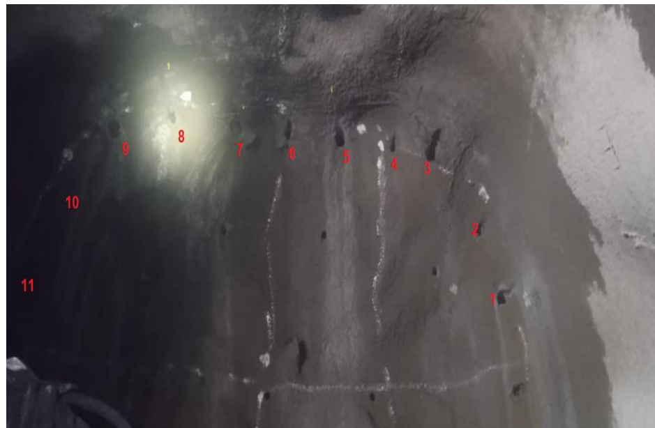
Figura 17: Precorte con 11 taladros de alivio rimados en la corona
