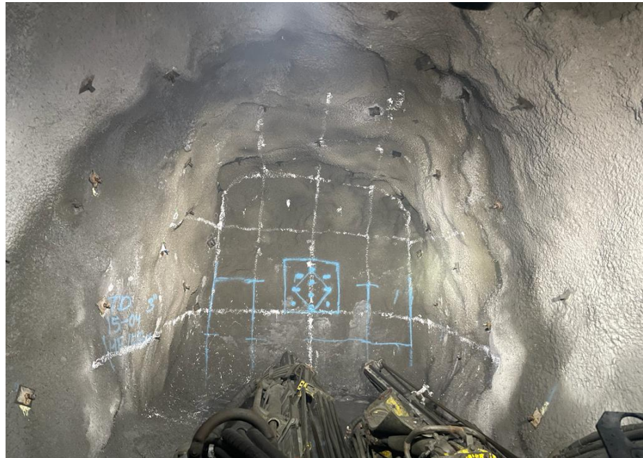
Figura 15: Pintado de la malla de perforación en el frente
