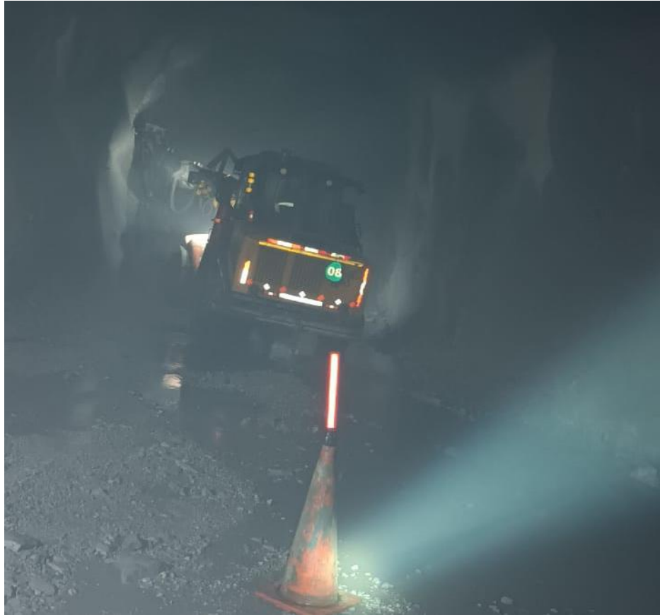
Figura 19: Proceso de desate mecanizado con Scailer
