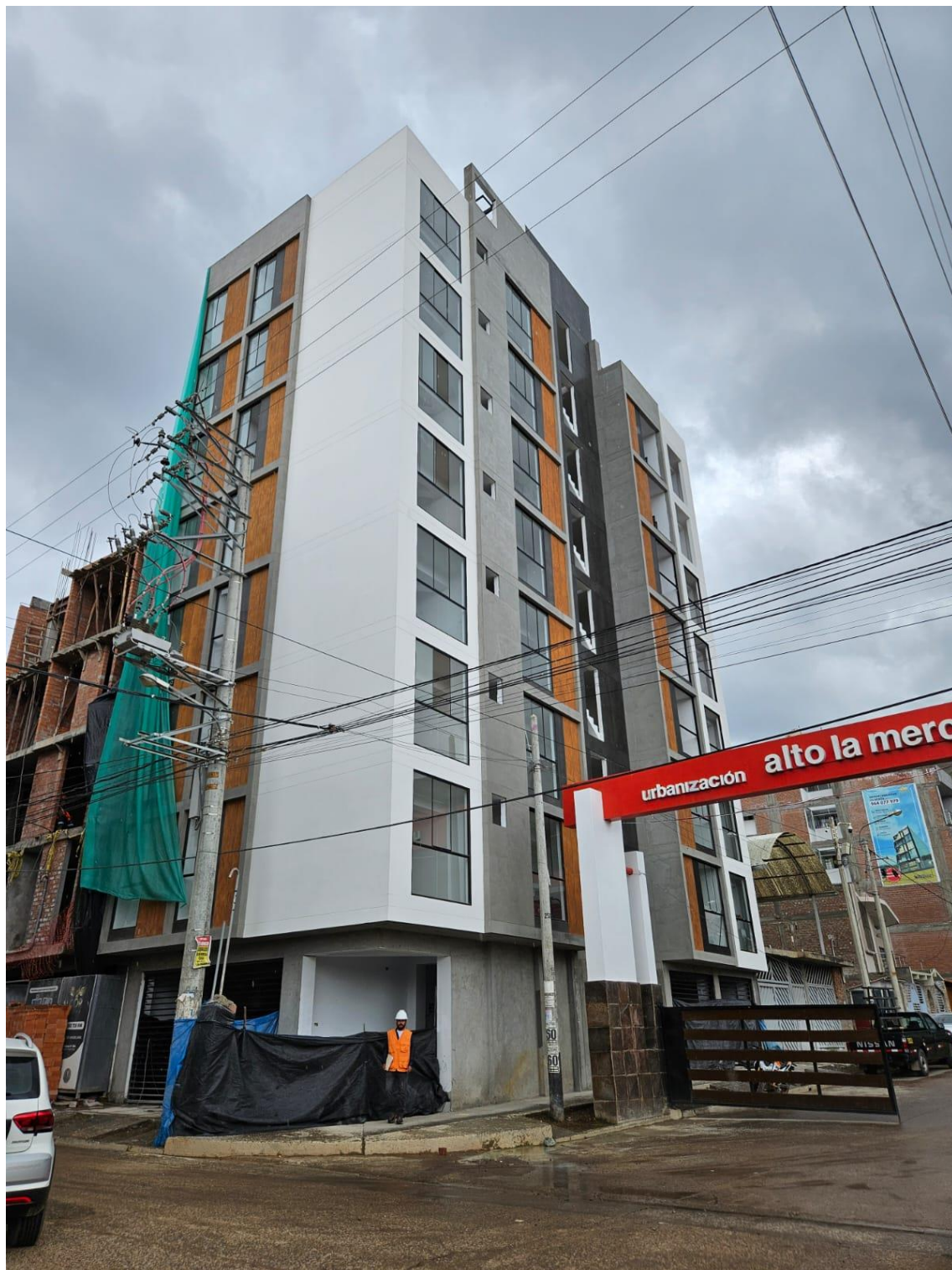
Fotografía 7. Vista frontal y lateral de la edificación
