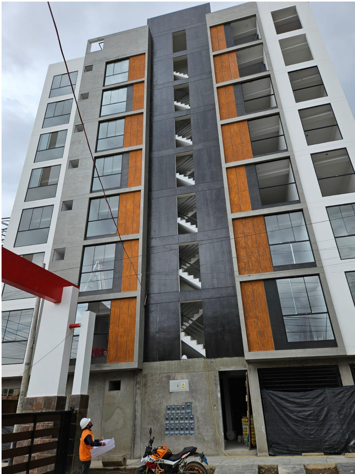
Fotografía 2. Vista lateral de la edificación
