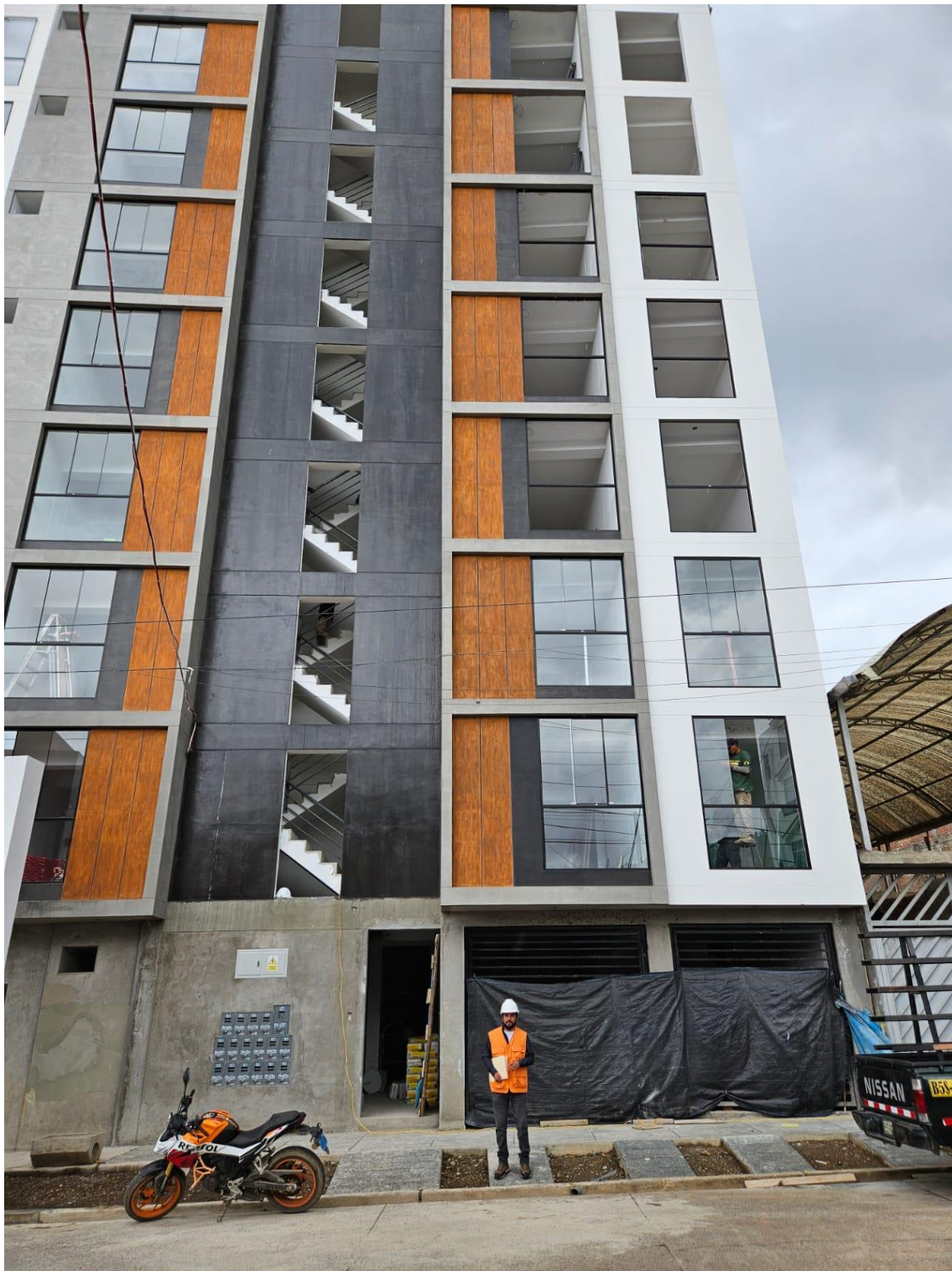
Fotografía 4. Vista lateral de la edificación
