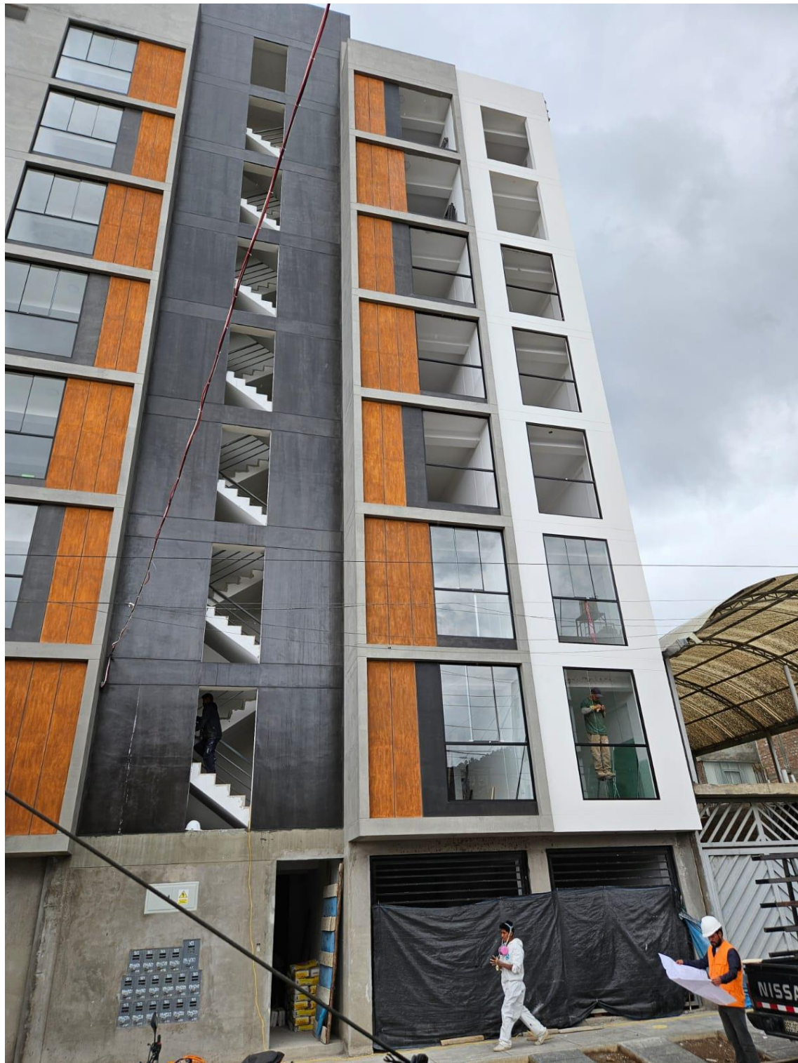
Fotografía 3. Vista lateral de la edificación
