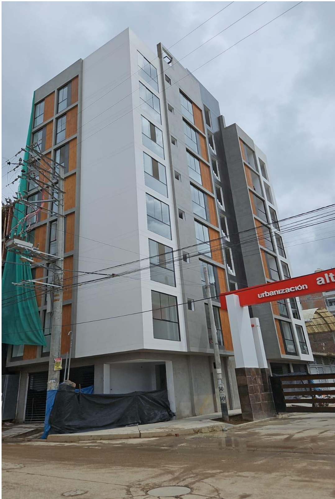
Fotografía 1. Vista principal de la edificación
