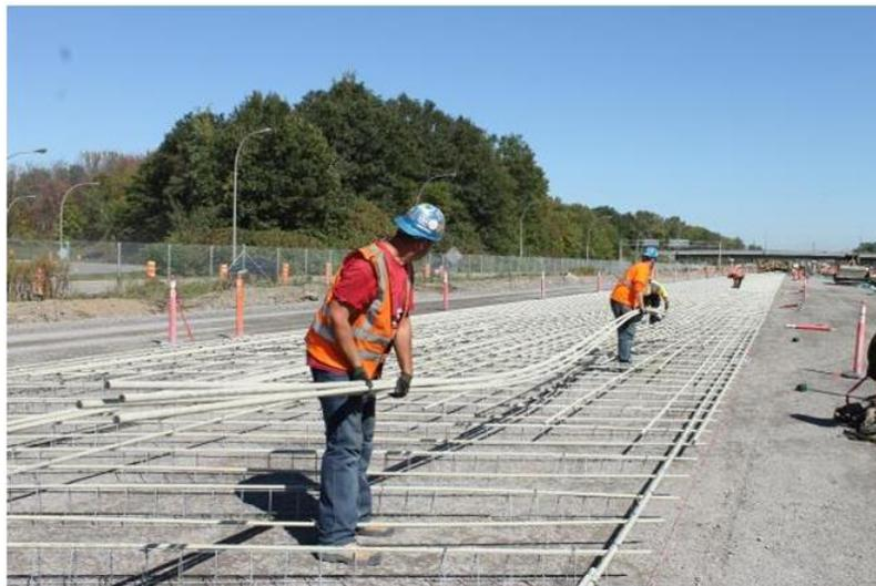
*Figura 5.* Colocación de barras de PRFV en el carril central de la autopista 40, Fuente: Montreal-2013.
