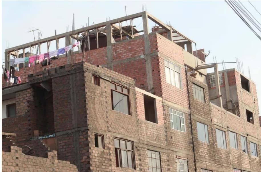
**Figura 1.** Edificaciones construidas con ladrillos pandereta presentan un riesgo significativo para su estabilidad estructural. Fuente: El Comercio, 2017.
