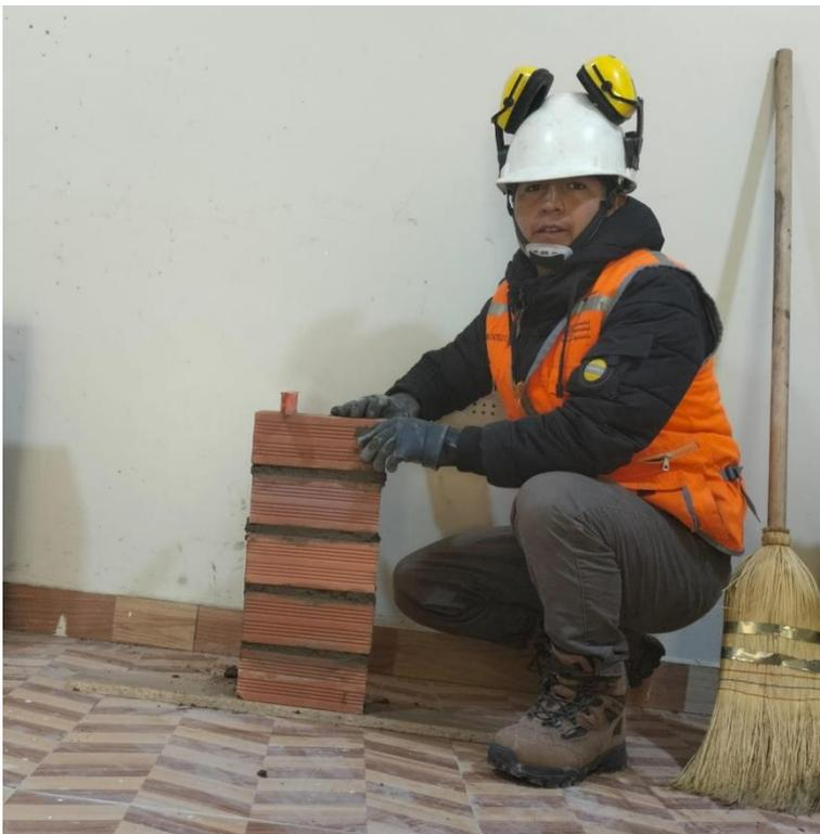
**Figura 79.** Detalle de la fase final de asentamiento y nivelación de la hilada de ladrillos, asegurando la correcta alineación y la uniformidad del mortero de asiento para una transmisión óptima de cargas en la pila de ladrillo tubular. Fuente: Elaboración propia.
