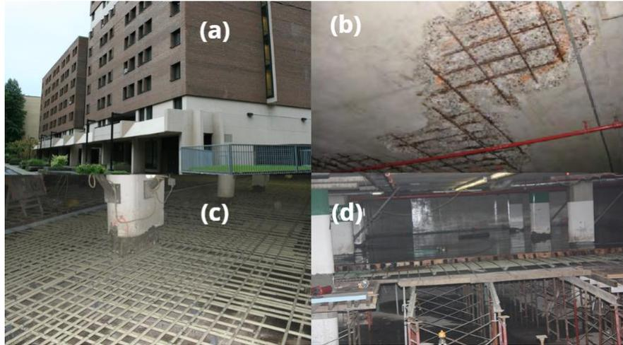
**Figura 7.** (a) Estacionamiento La Chanceliere en Quebec, Canadá, (b) Acero corroído en la losa del estacionamiento, (c) Refuerzo con GFRP en la losa, (d) Vaciado de piso (Ahmed et al., 2016).
