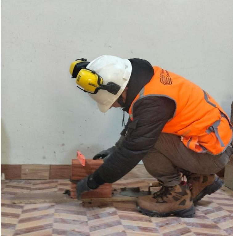
**Figura 78.** Asentamiento y nivelación de las primeras hiladas de ladrillos para garantizar la estabilidad y la transmisión uniforme de cargas en la pila. Fuente: Elaboración propia.
