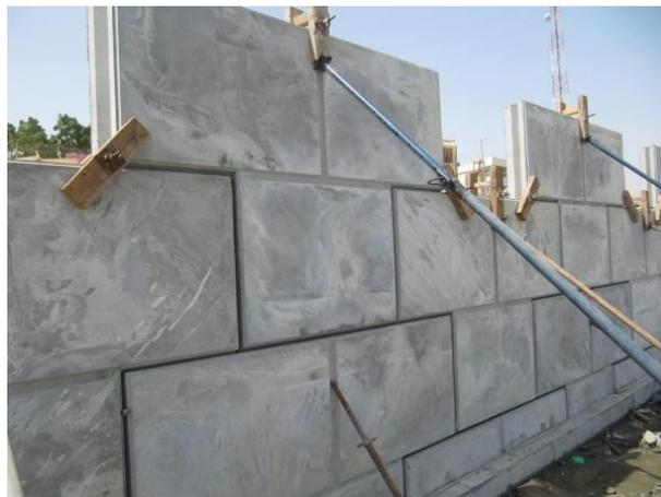
**Figura 8.** Paneles de concreto prefabricado para el canal del puerto de Dibba en Emiratos Árabes Unidos, tomado de MATEENBAR, 2023.
