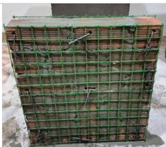
A continuación, se humedecieron las superficies con agua y se aplicó una lechada de cemento para favorecer una adherencia adecuada. Posteriormente, se procedió al enlucido en ambas caras de la pared, con un espesor uniforme de 2.5 cm.
