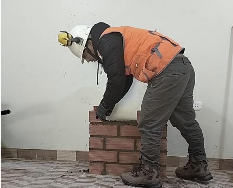
**Figura 86.** Colocación del ladrillo durante el proceso de asentado en murete. Fuente: Elaboración propia.
