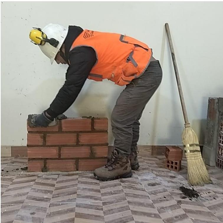
**Figura 85.** Colocación del mortero durante el proceso de asentado en murete. Fuente: Elaboración propia.
