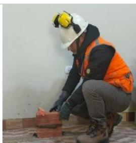
Tercero, se aplicó mortero de 1.5 cm entre cada una de ellas, utilizando un nivel de mano para asegurar que las hiladas estuviera niveladas y rectas. Esto es de suma importancia para su estabilidad y la horizontalidad del murete.
