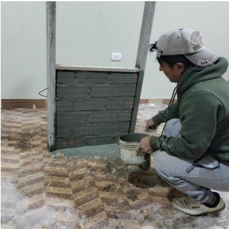
**Figura 89.** Lechada de cemento sobre la superficie del murete para asegurar una correcta adherencia entre el murete y el mortero de tarrajeo. Fuente: Elaboración propia.
