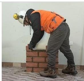
Cuarto, se aplicó mortero de 1.5 cm entre cada una de ellas, utilizando un nivel de mano para asegurar que las hiladas estuviera nivelada y recta. Esto es de suma importancia para su estabilidad y la horizontalidad del murete.
