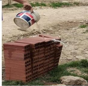
Primero, un día antes de la construcción de los muretes, se regaron con agua potable todas las unidades de albañilería. Esta acción se realizó con el fin de mejorar la adherencia entre ladrillo y el mortero, así como para reducir la absorción.
