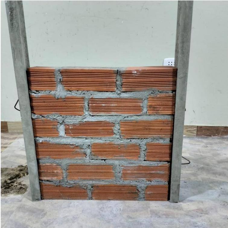
**Figura 88.** Colocación de reglas de aluminio para establecer las guías de nivel durante el inicio del tarrajeo de muretes. Fuente: Elaboración propia.
