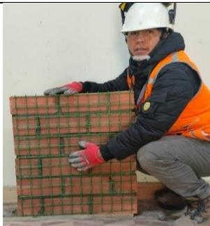
Transcurridos catorce días, se colocó malla de GFRP en ambos lados del murete y se empotraron conectores de acero de grado 60 de 6 mm de diámetro a intervalos de 30 cm. Luego, se humedece toda la superficie con agua para garantizar unas condiciones de aplicación adecuada.
