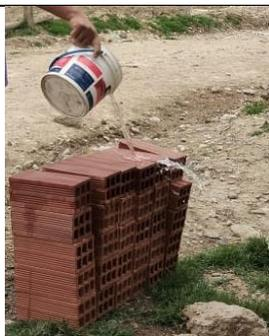
Primero, un día antes de la construcción de las pilas, se regaron con agua potable las unidades de albañilería. Esta acción se realizó con el fin de mejorar la adherencia entre ladrillo y el mortero, así como para reducir la absorción.
