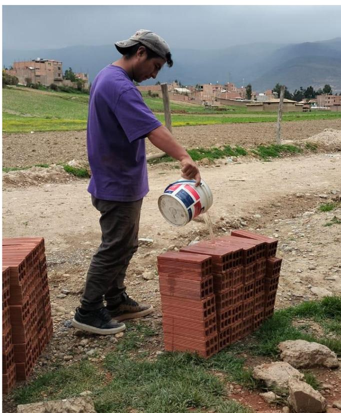
**Figura 75.** Mojar ladrillos tubulares antes del asentado con mortero. Fuente: Elaboración propia.
