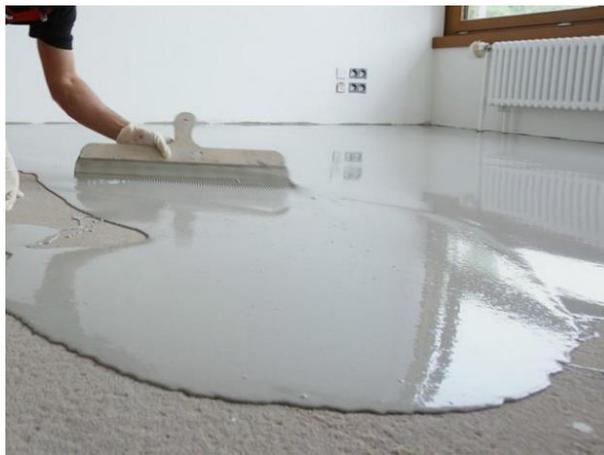
**Figura 4.** Resina Epoxi Autonivelante. No se extiende rápidamente durante el trabajo y se puede nivelar a lo largo de la superficie con mayor facilidad. Tomado de EPOXIDECO.
