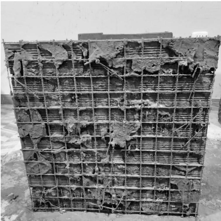
**Figura 91.** Tarrajeo de la superficie del murete mediante la aplicación de mortero, asegurando un acabado uniforme y adecuada protección del muro. Fuente: Elaboración propia.
