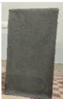
Después, se aplicó lechada de cemento antes del enlucido para garantizar una fuerte adherencia entre la superficie, la malla y el mortero. Y luego, se procedió con el tarrajeo.
