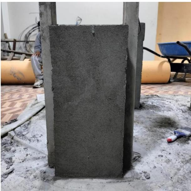
**Figura 81.** Tarrajeo de las pilas con mortero, asegurando un recubrimiento uniforme. *Fuente: Elaboración propia.*
