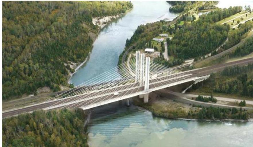
**Figura 6.** Puente atirantado sobre el río Nipigon, Fuente: Ontario, 2015.
