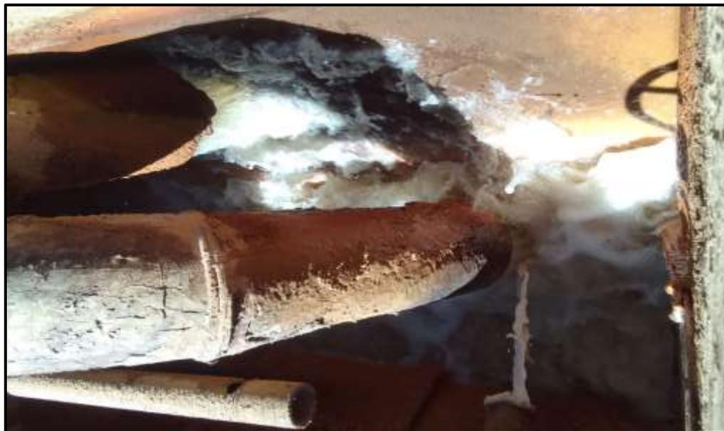
**Figura 14.** Dosificación de la lechada de cal en el tanque de neutralización N° 1.
