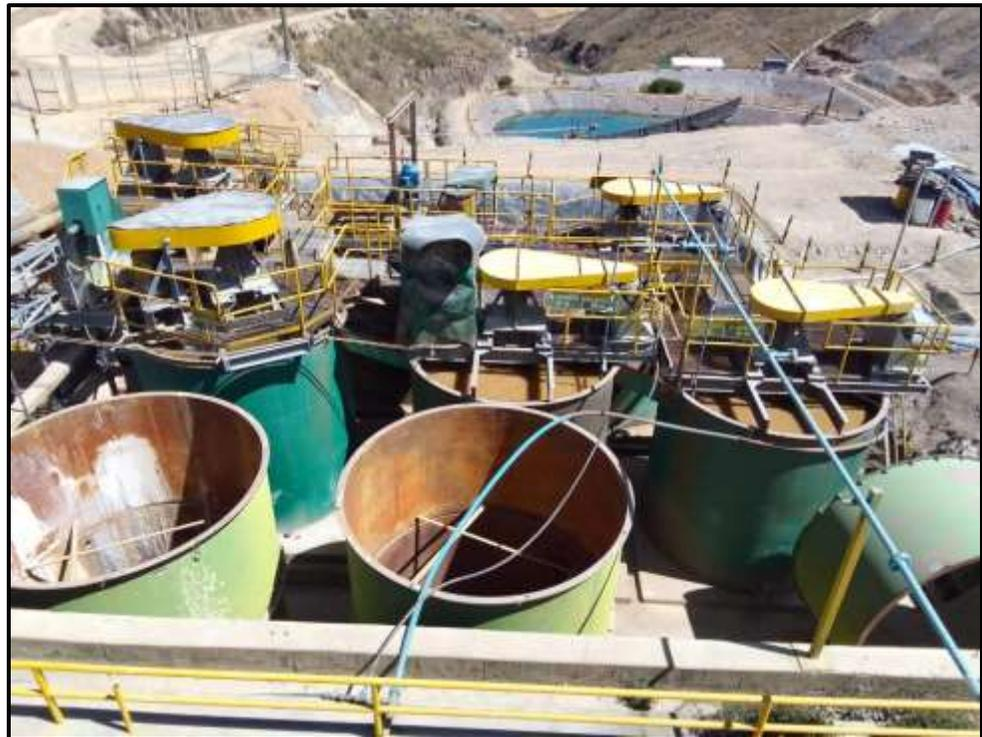
**Figura 15.** Tanques de neutralización y oxidación para la medición de los parámetros fisicoquímicos.
