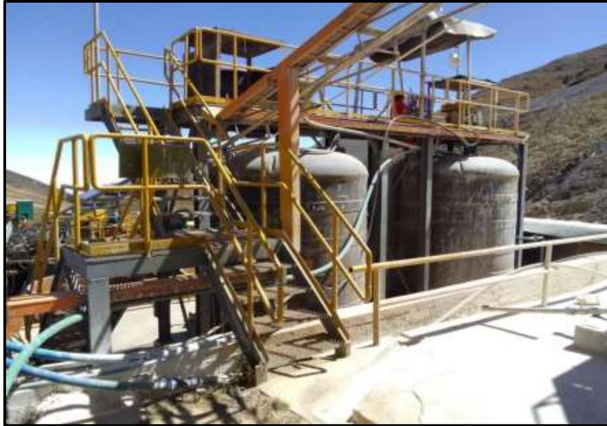
**Figura 13.** Tanques de preparación de floculante N° 1 y N° 2
