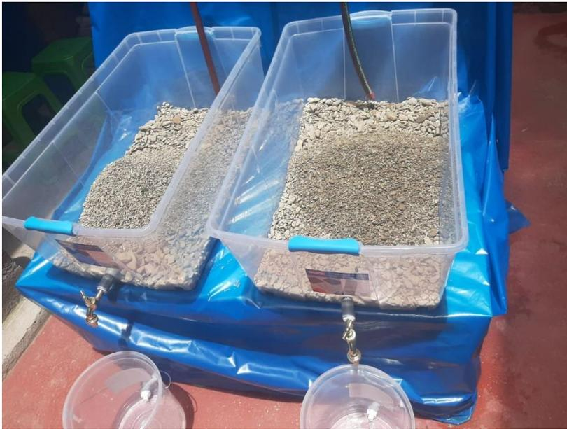
*Fotografía 7. Aplicación de sustrato al humedal artificial*
