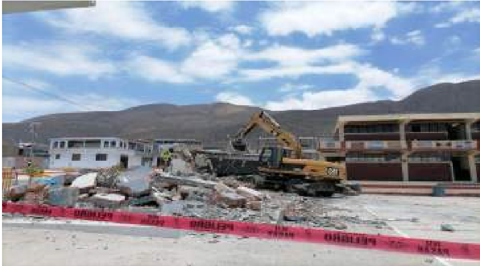
Figura 30. Demolición de depósito con maquinaria
