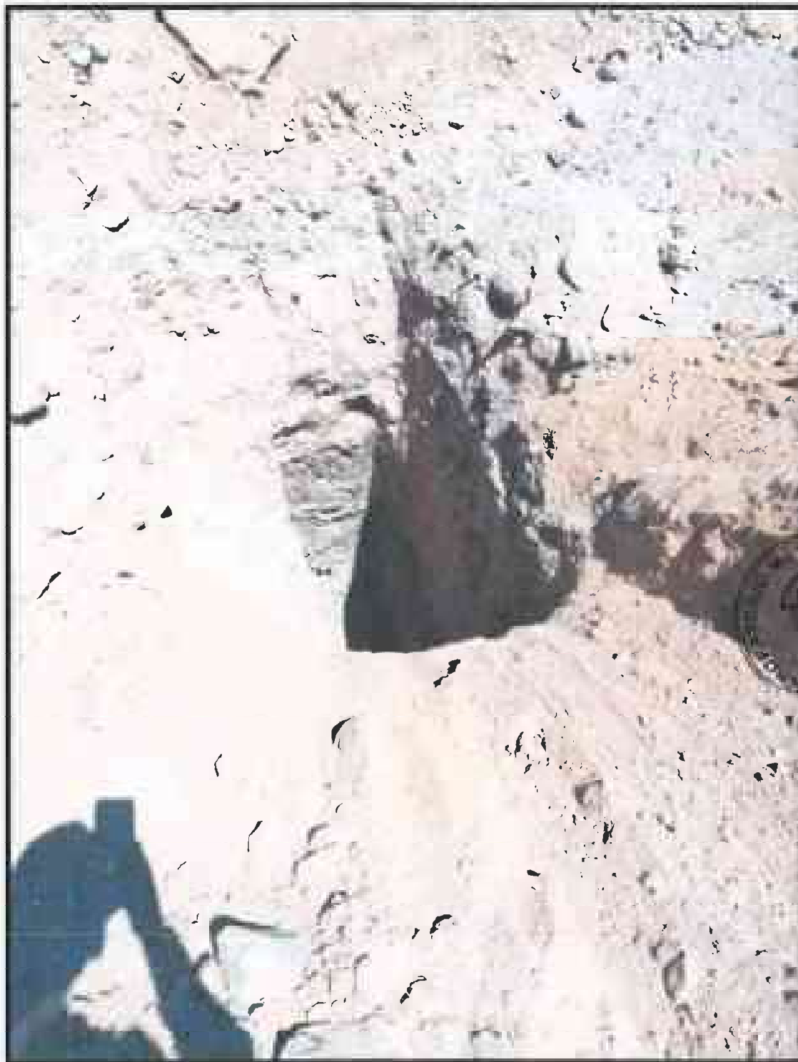
CALICATA 1, FOTO DE DETALLE
