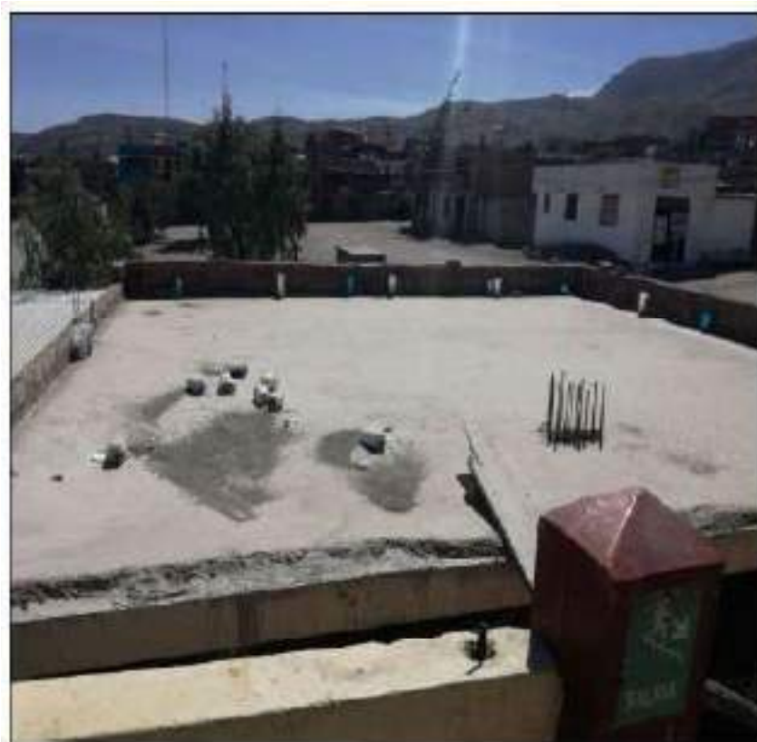
Figura 6. Área para construcción de talleres
