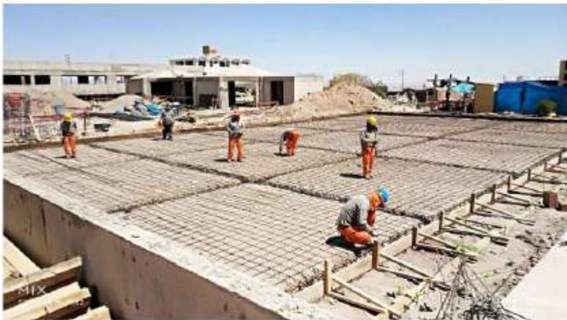
Figura 53. Habitación y colocación de acero, encofrado en losa deportiva
