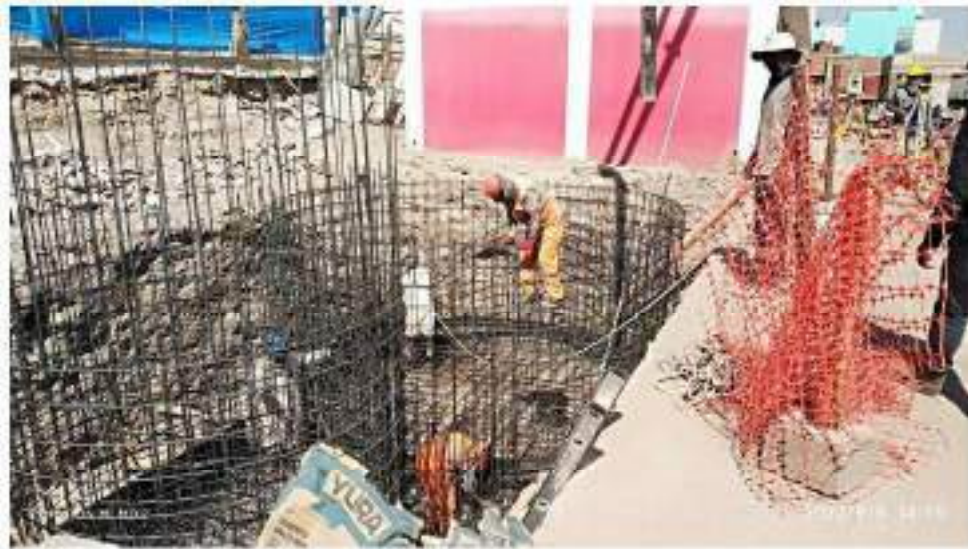
Figura 74. Acero de muro de cisterna
