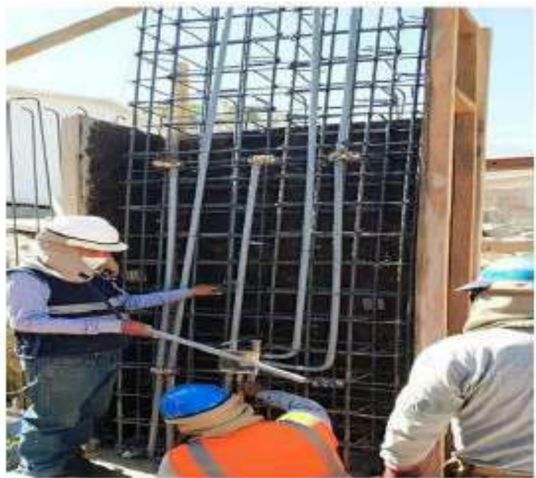
Figura 38. Instalaciones eléctricas en comedores
