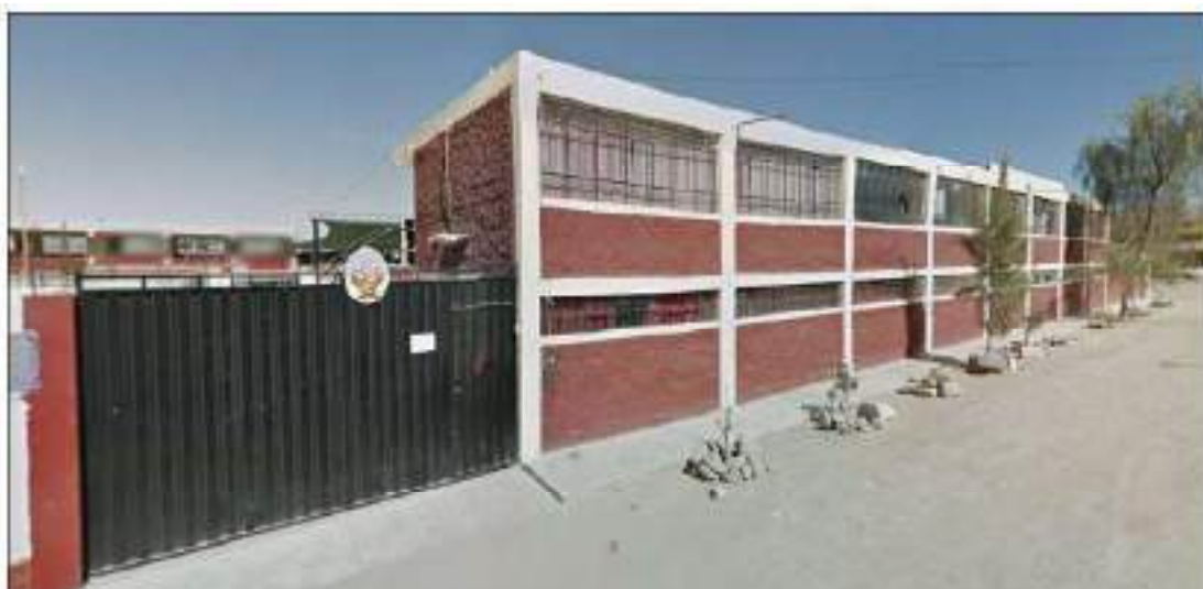
Figura 9. Ingreso y bloque de aulas inhabilitadas
