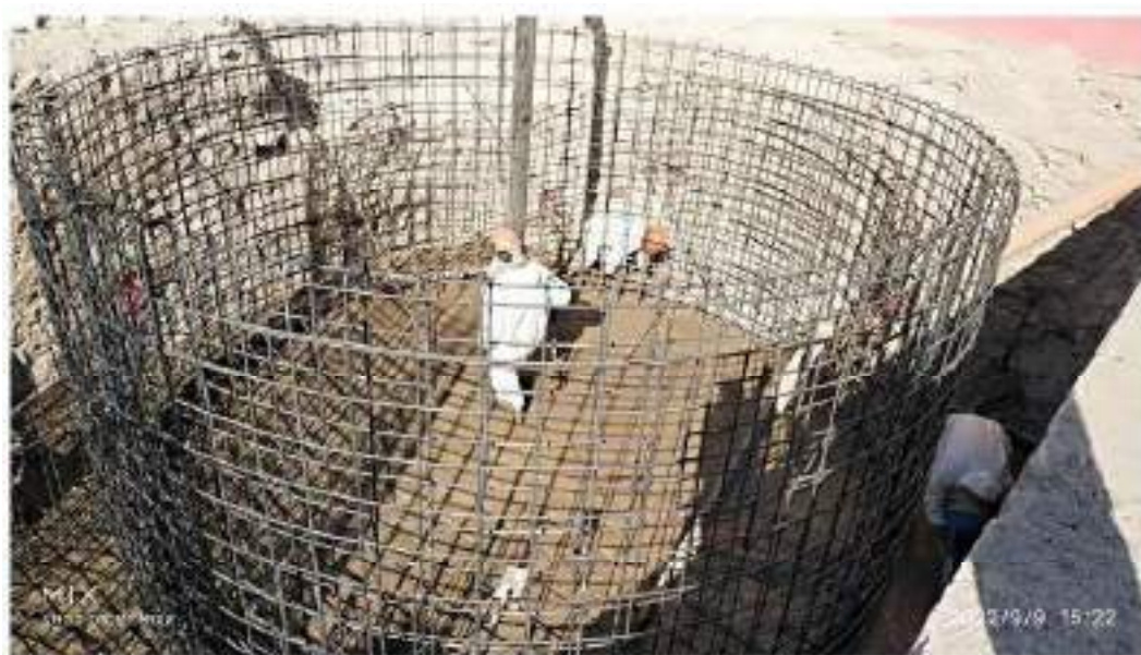
Figura 73. Concreto en zapata de cisterna
