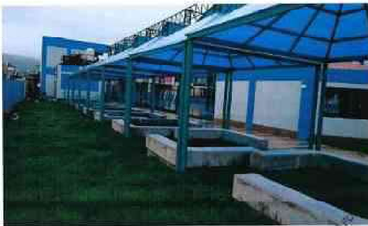
Fotografía N° 03: Culminacion de obra
