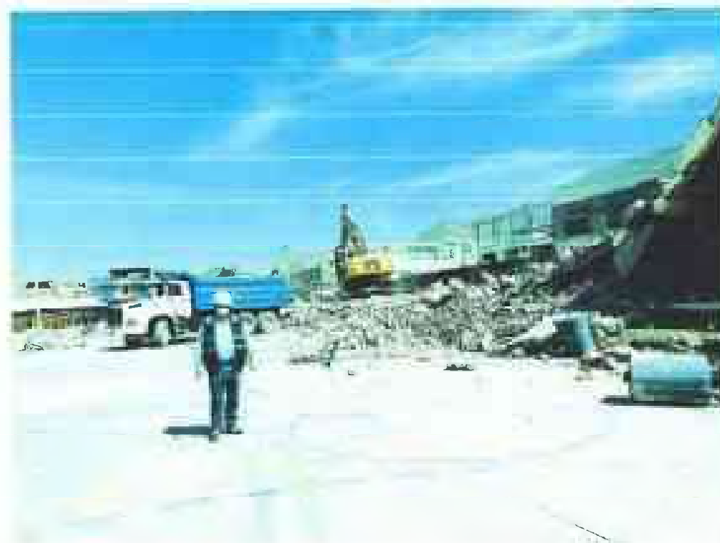
Fig. 10. Demolición de aulas con maquinaria
