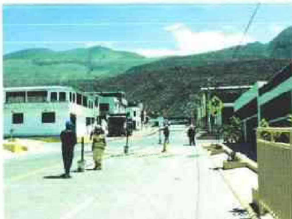
Fig. 21. Señalización temporal de seguridad en obra.
