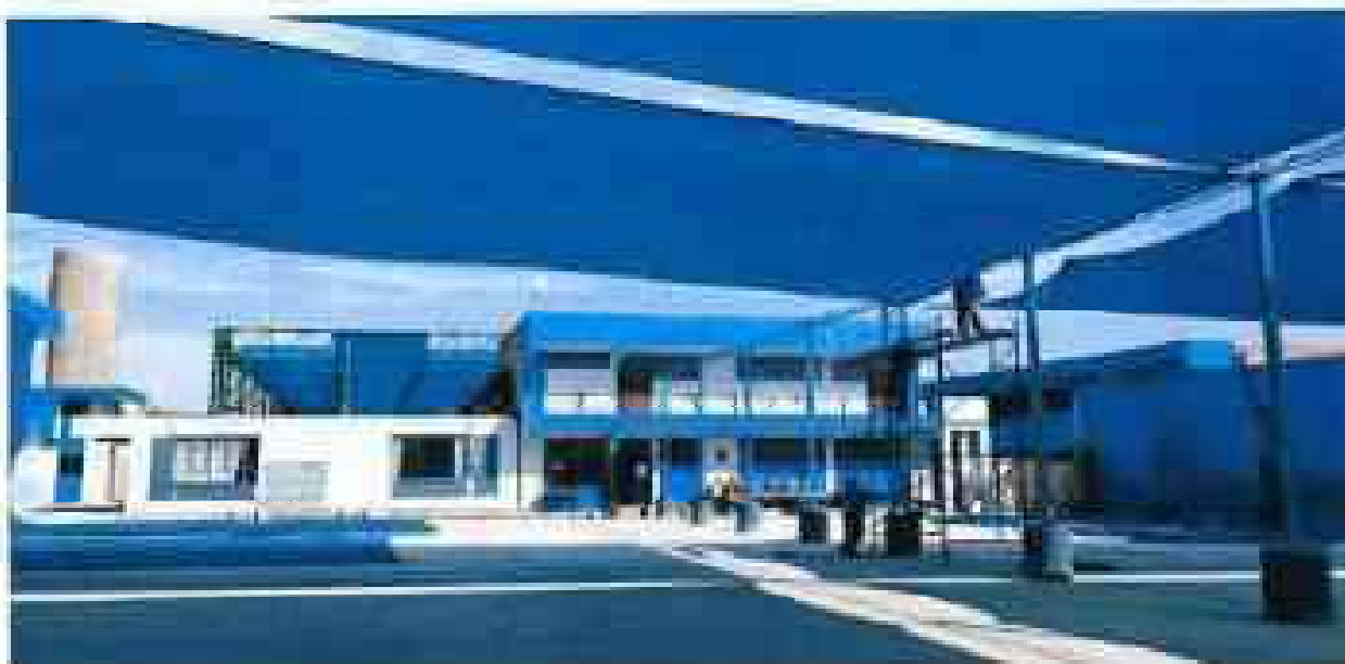
Fotografía N° 03: Culminacion de obra
