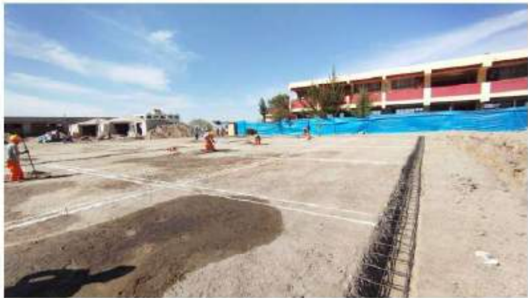
Figura 52. Trazo y replanteo de losa deportiva, excavación para vigas de apoyo
