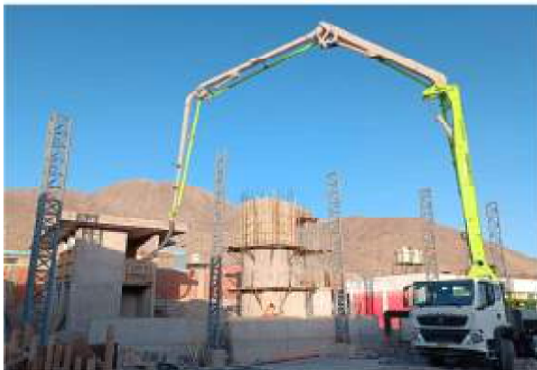
Figura 67. Vaciado con concreto premezclado F'c 210 de la losa maciza con una cantidad de 10 m 3
