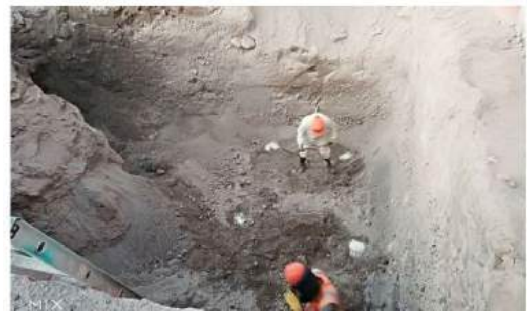
Figura 70. Excavación con maquinaria
