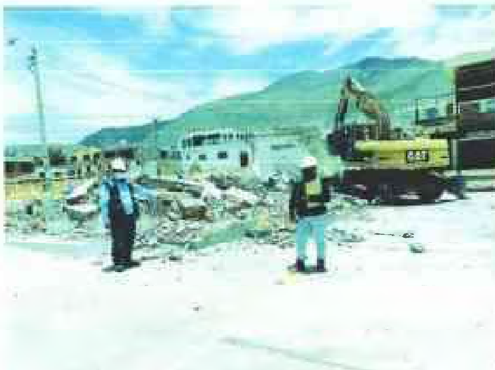
Fig. 13. Control de trabajos de demolición, Residencia y Seguridad.
