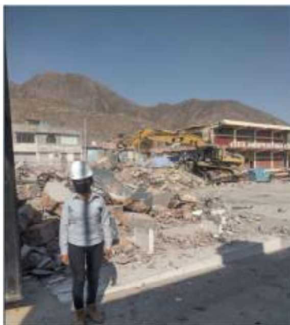
Figura 29. Demolición de talleres con maquinaria
