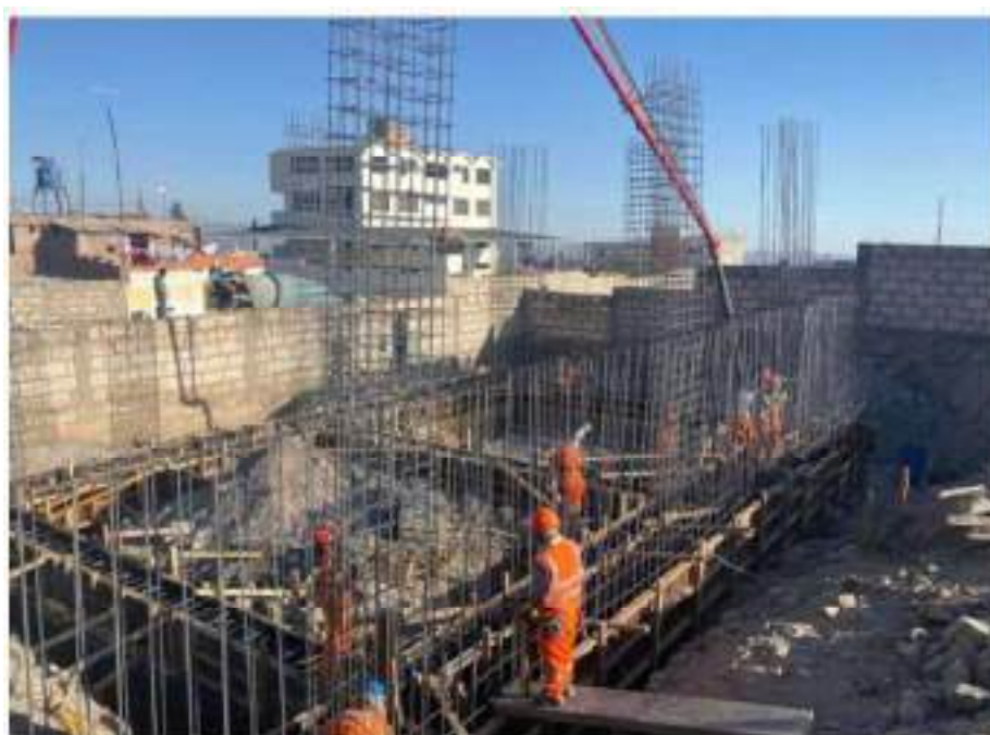
Figura 36. Armado de acero y encofrado en vigas y zapatas
