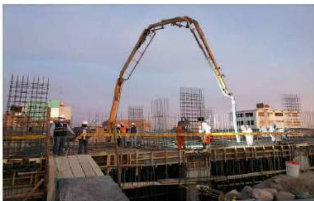
Figura 45. Concreto en vigas y losas en comedores
