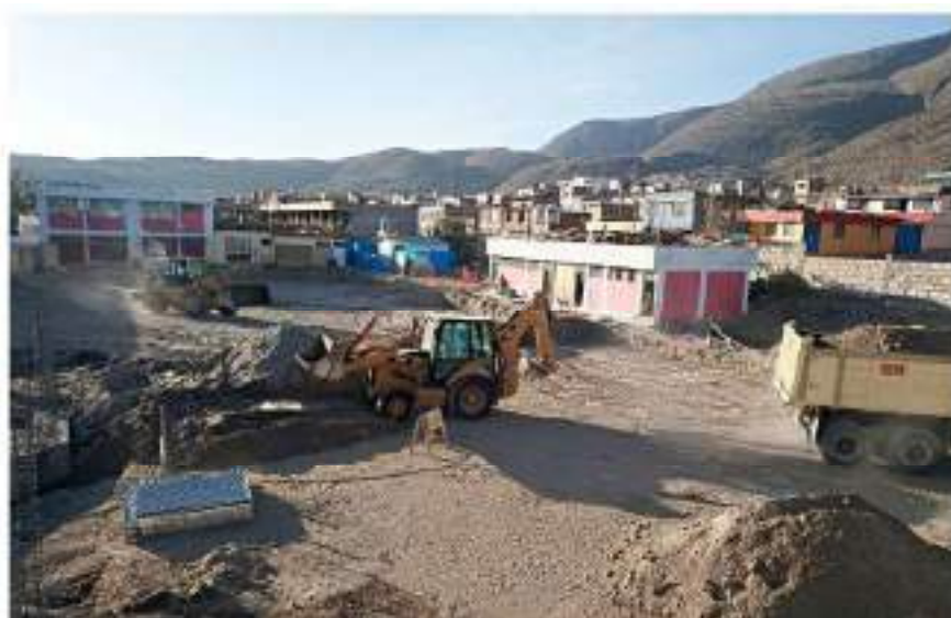
Figura 50. Excavación masiva y eliminación
