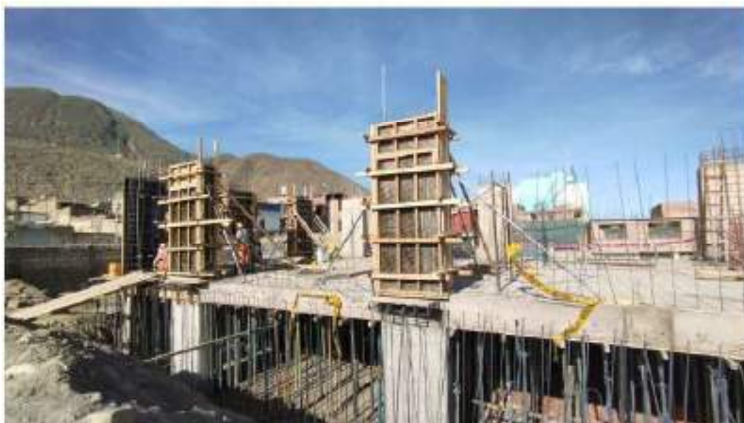
Figura 46. Encofrado de muros reforzados comedores (segundo nivel)
