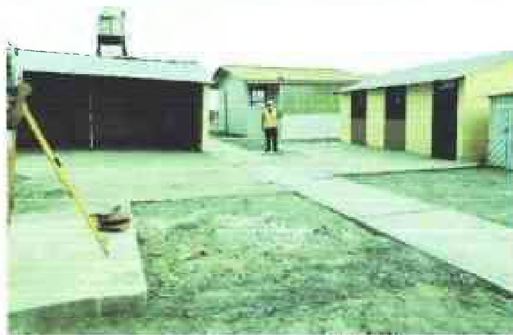
Fig. 16. Levantamiento topográfico con estación total
