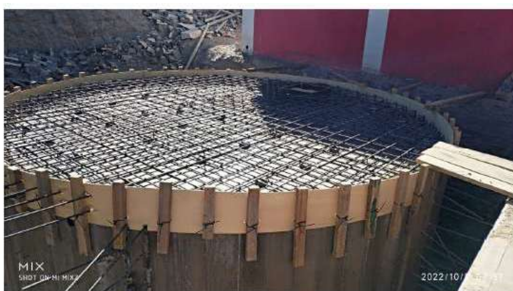
Figura 77. Acero y encofrado en losa de cisterna
