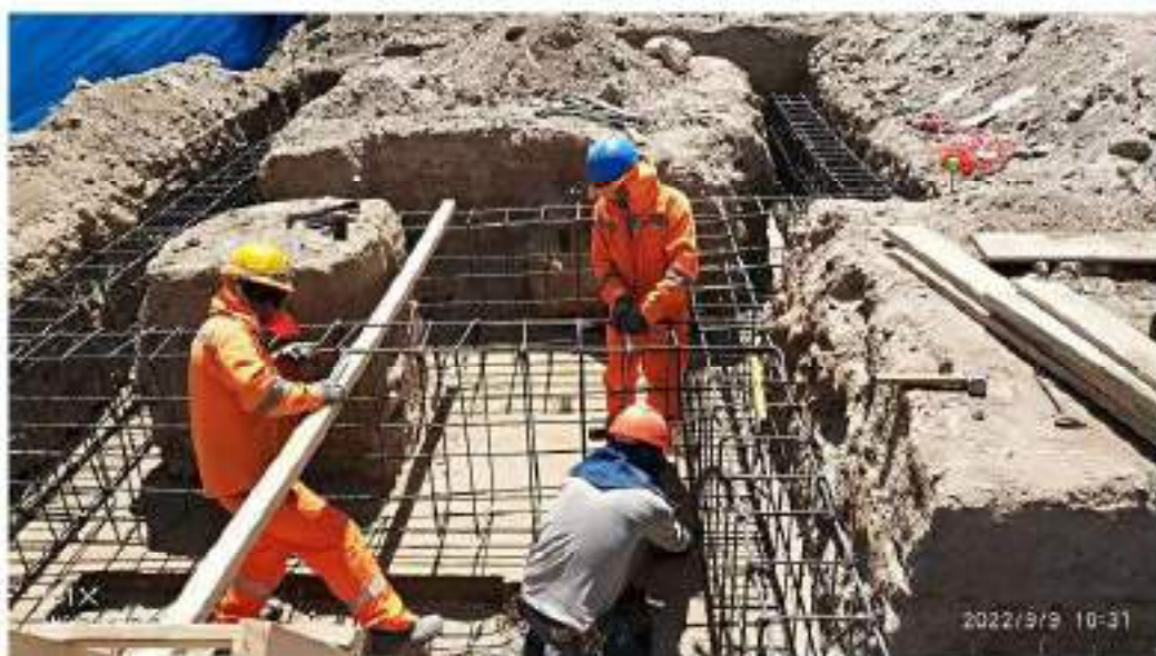
Figura 62. Excavación de cimientos y colocación de acero de tópicos y guardianía
