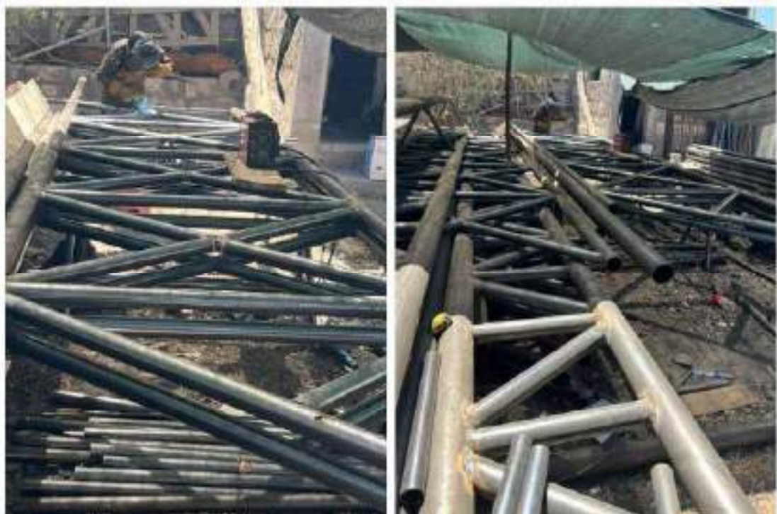
Figura 57. Fabricación de columnas metálicas planas y triangulares para coberturas metálicas y pintura
