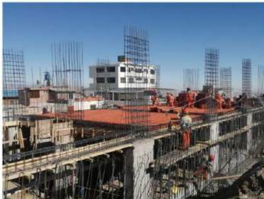
Figura 42. Ladrillo de techo en comedores
