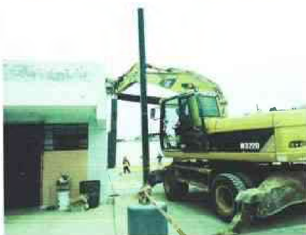
Fig. 18. Demolición de arco de ingreso.
