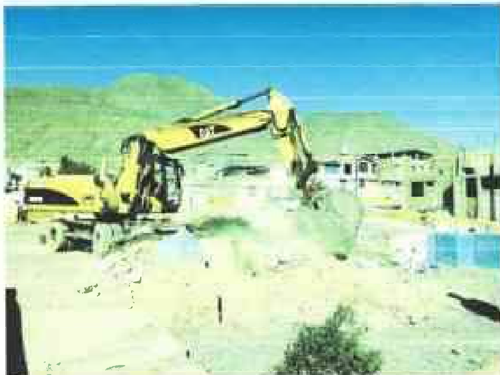
Fig. 1. Demolición de cerco juegos inicial existente.
