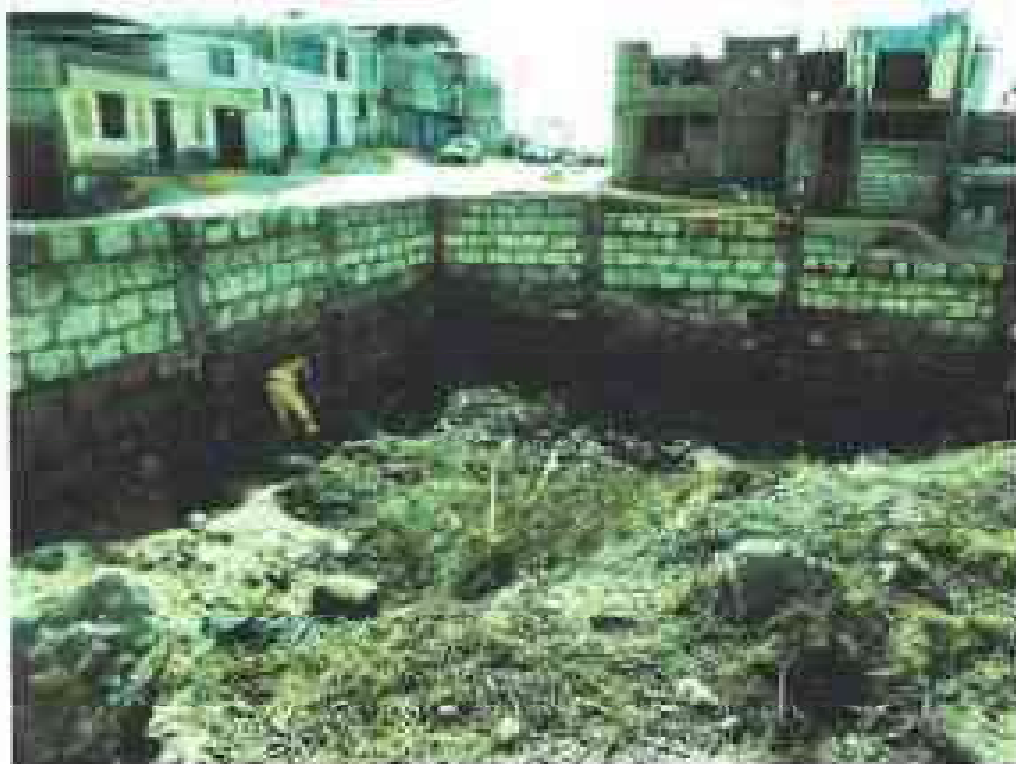
Fig. 9. Limpieza de terreno manual de maleza superficial existente.
