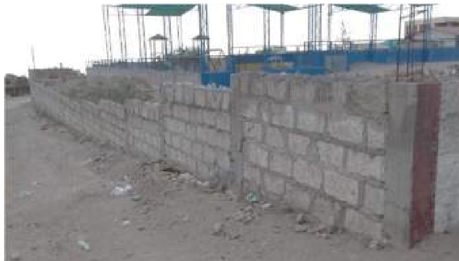
Figura 8. Cerco perimétrico existente
