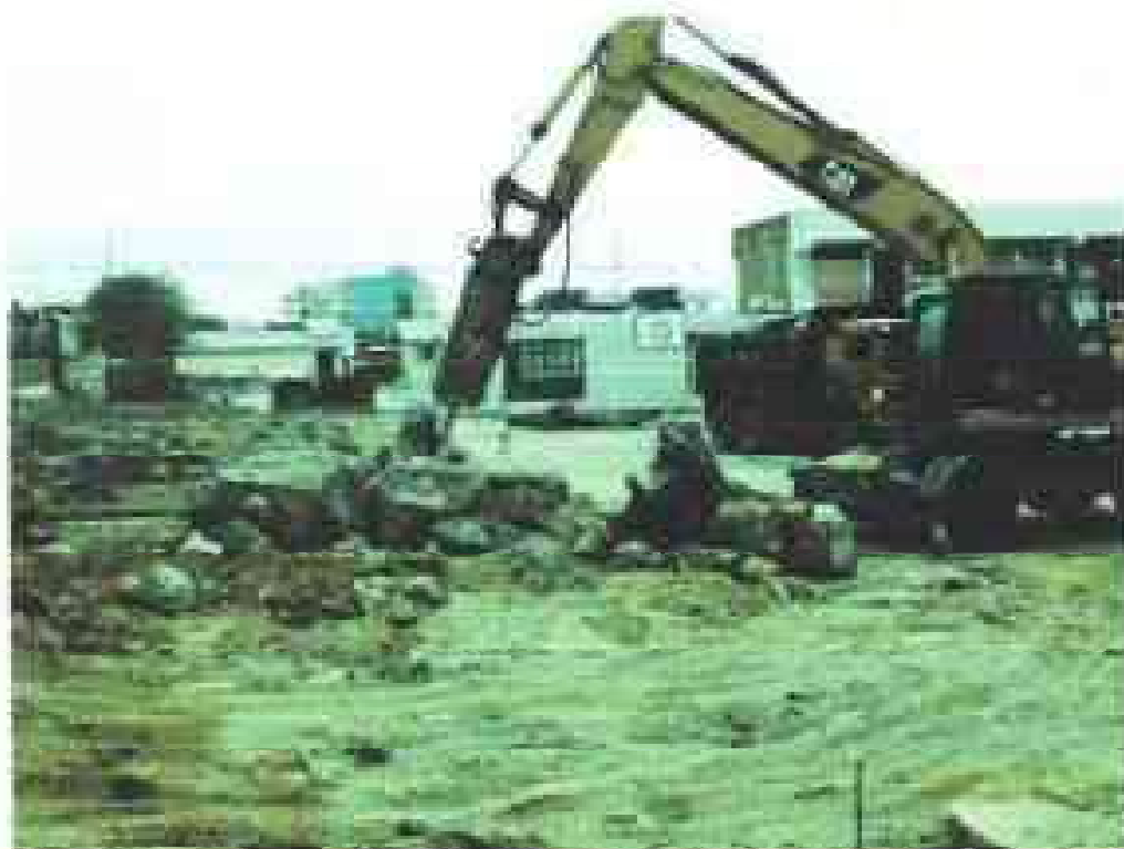
Fig. 15. Demolición de bloques de cimentación de bloque de aulas.
