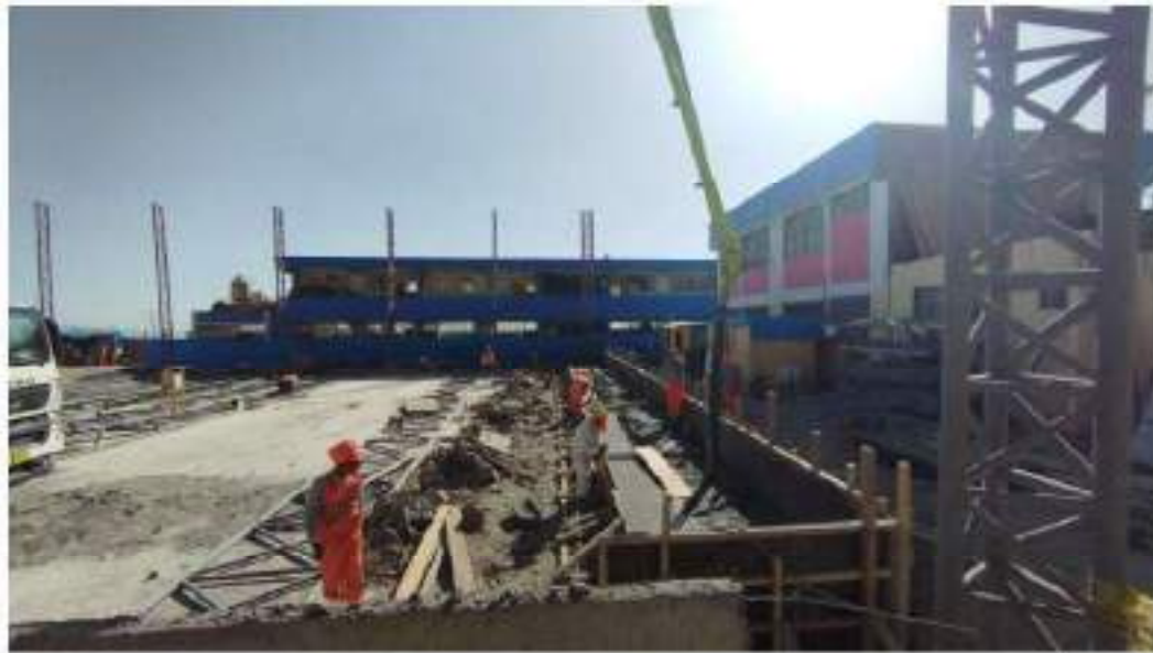
Figura 56. Concreto en graderías de losas deportivas
