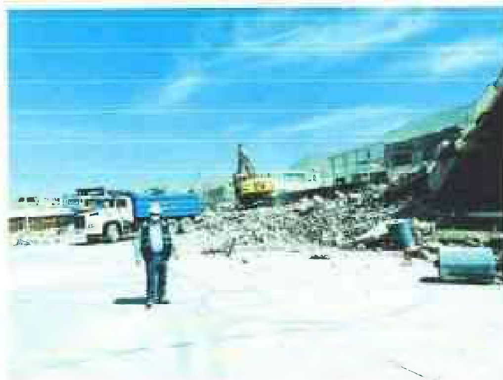
Fig. 12. Demolición de aulas con maquinaria
