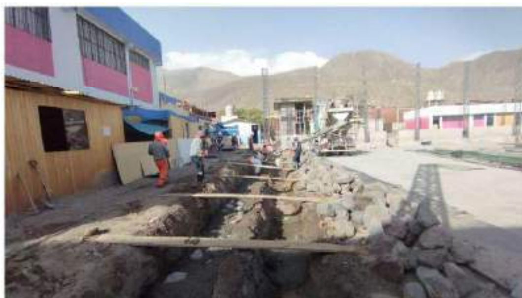
Figura 55. Graderías sector losa deportiva concreto ciclópeo
