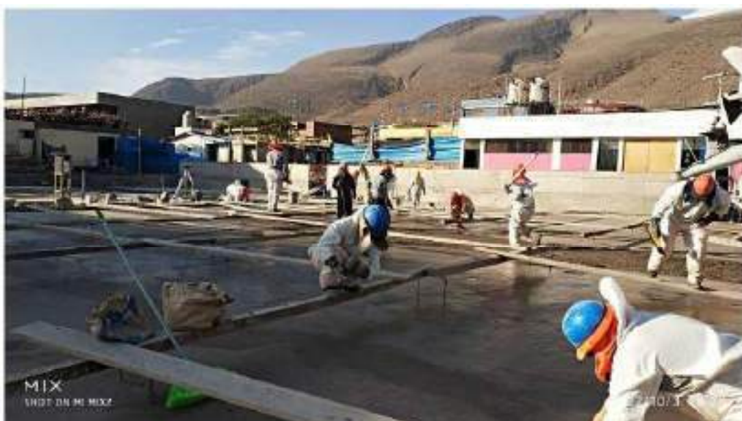
Figura 54. Concreto en losa deportiva
