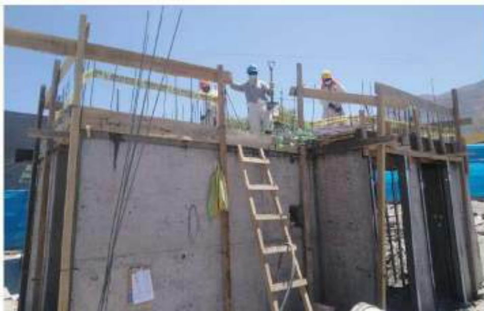
Figura 66. Concreto en muros de tópico y guardianía
