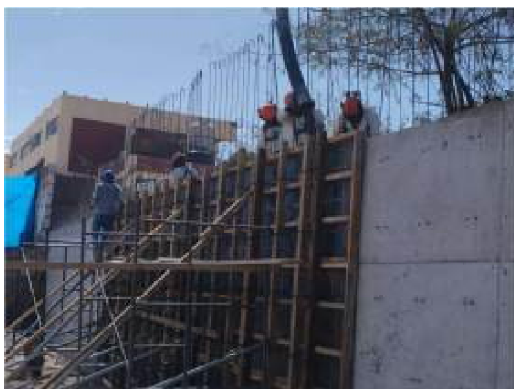
Figura 68. Muro de contención
