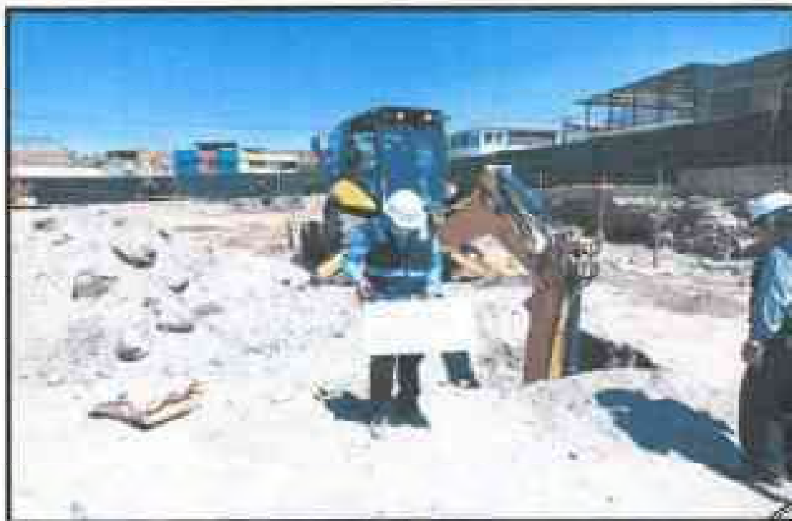
CALICATA 1, FOTO PANORAMICA 01.
