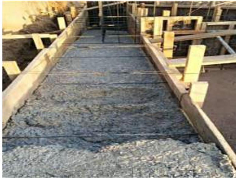
Figura 26. Cimentación realizada en aulas
