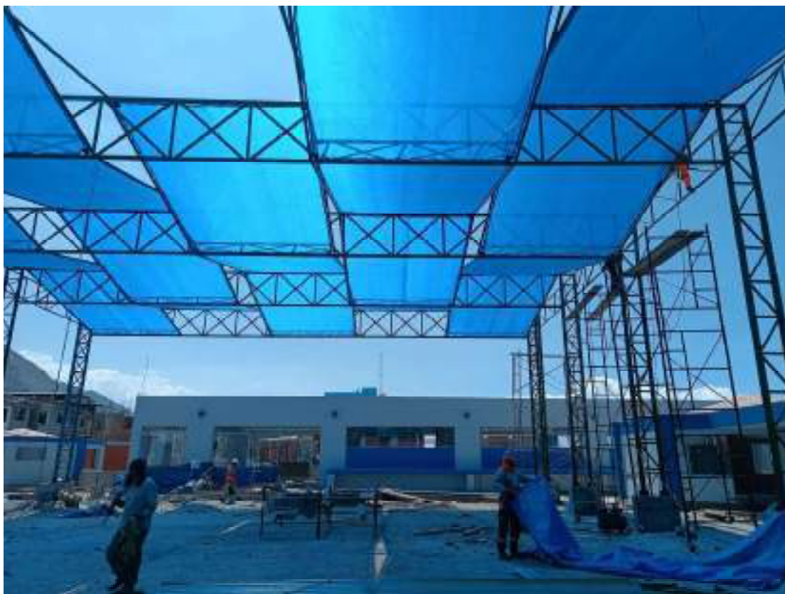
Figura 59. Montaje de estructura metálica
