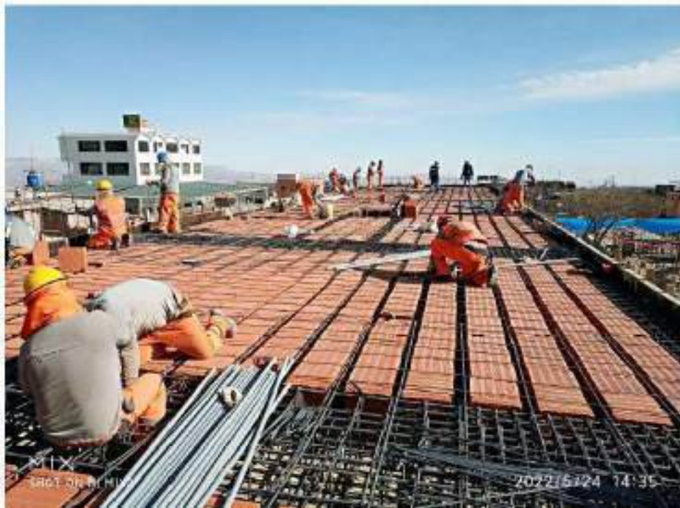
Figura 48. Ladrillo y aligerado en comedores (segundo nivel)
