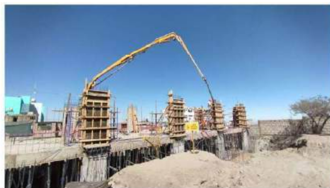
Figura 47. Concreto en muros reforzados de comedores (segundo nivel)
