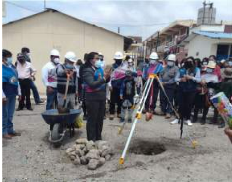
Figura 22. Inicio de ejecución de obra
