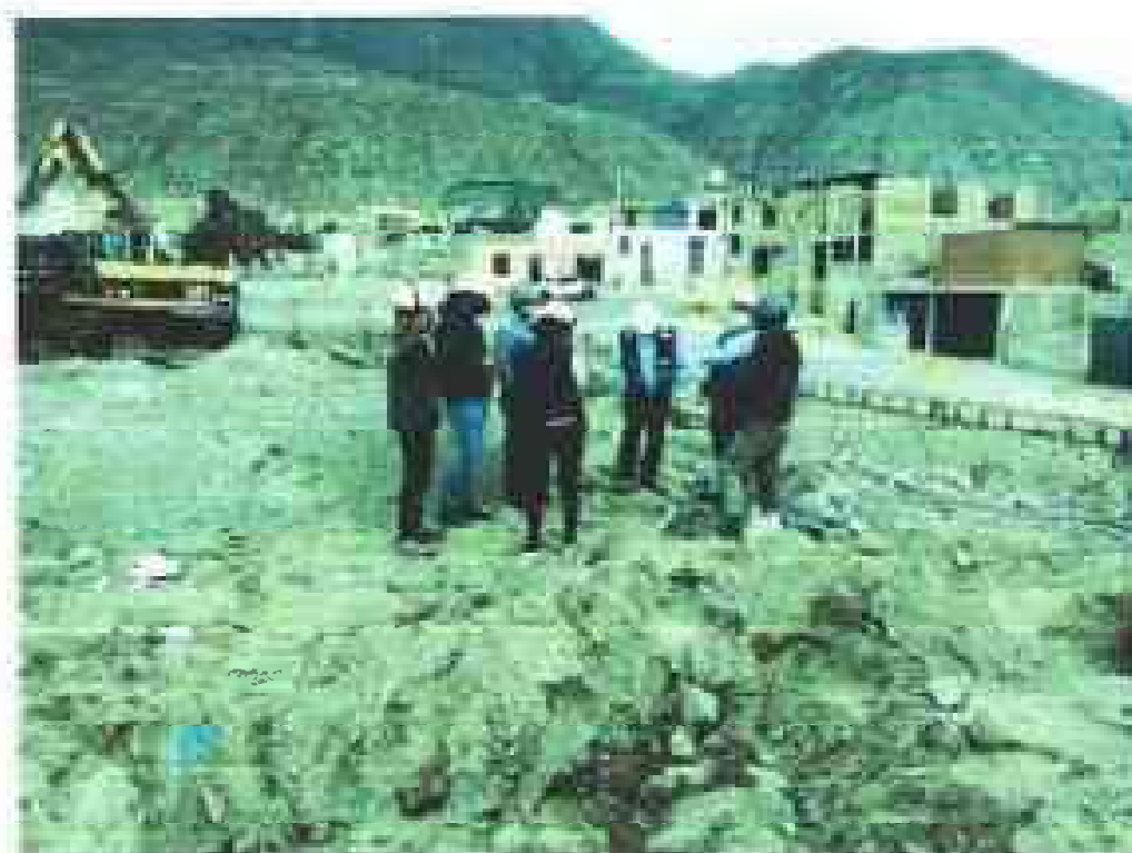
Fig. 14. Inspección de obra por parte de la municipalidad distrital de Yura.
