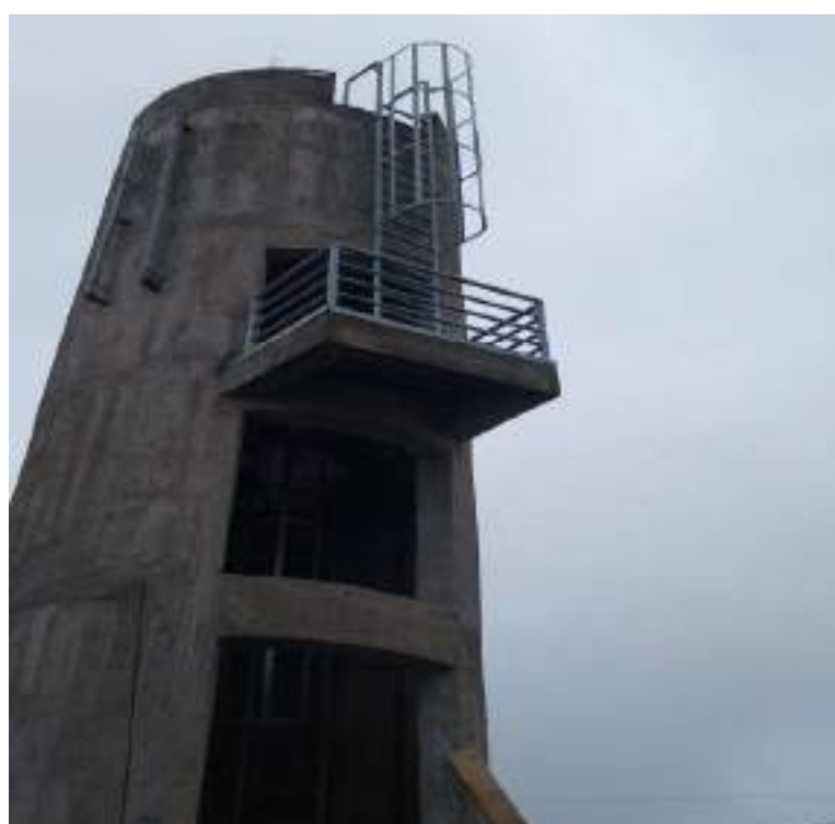
Figura 78. Encofrado en muro de tanque elevado
