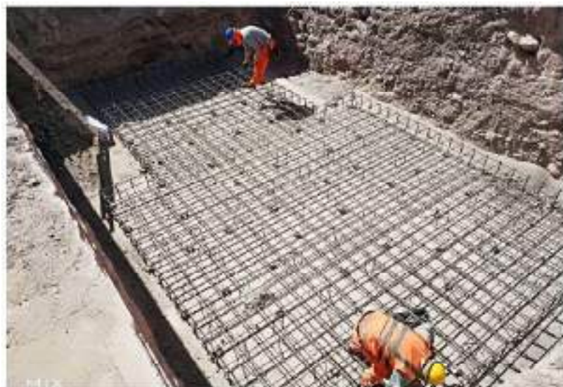
Figura 72. Acero en zapata de tanque elevado y cisterna
