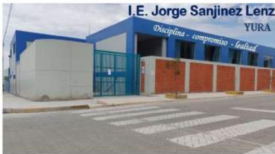
Figura 28. Vista de frente de la institución
