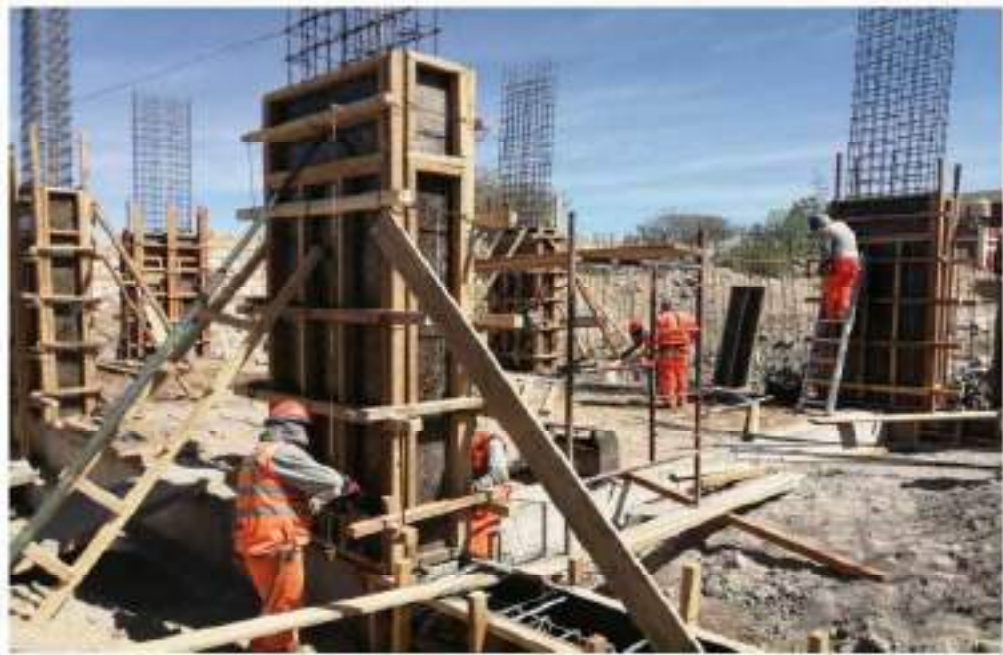
Figura 37. Encofrado en placas comedores
