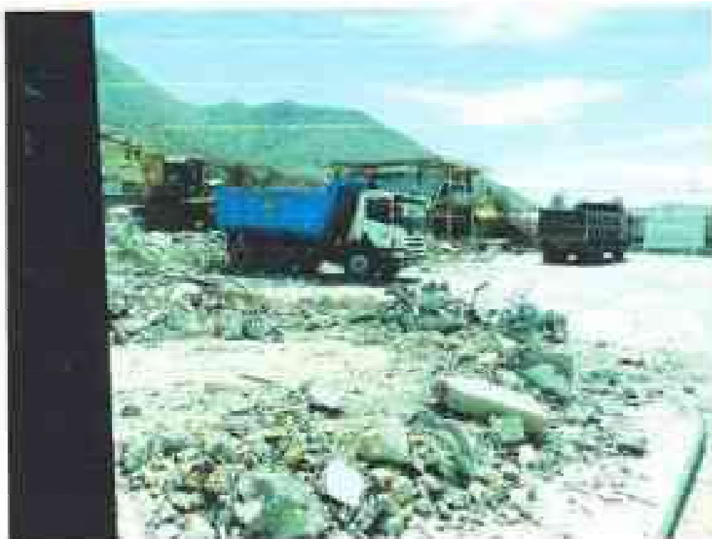
Fig. 19. Eliminación de material de demolición con volquetes.
