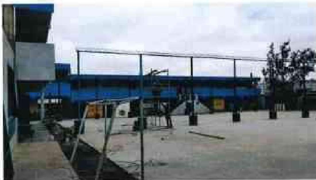
Fotografía N° 01: Instalacion malla rashell
