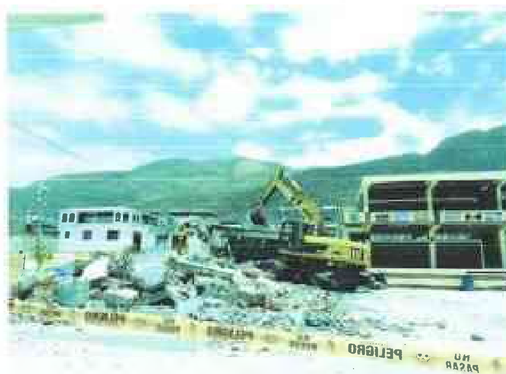
Fig. 8. Demolición de depósito con maquinaria
