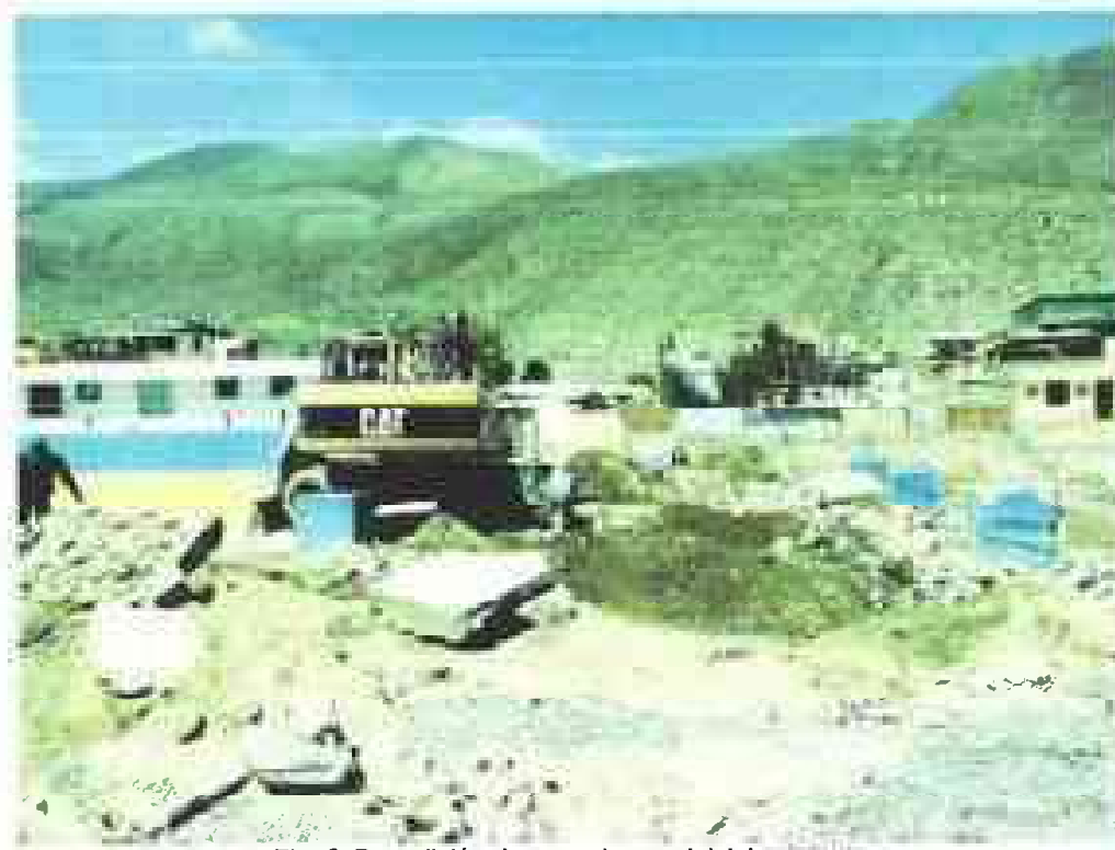
Fig. 2. Demolición de cerco juegos inicial existente.
