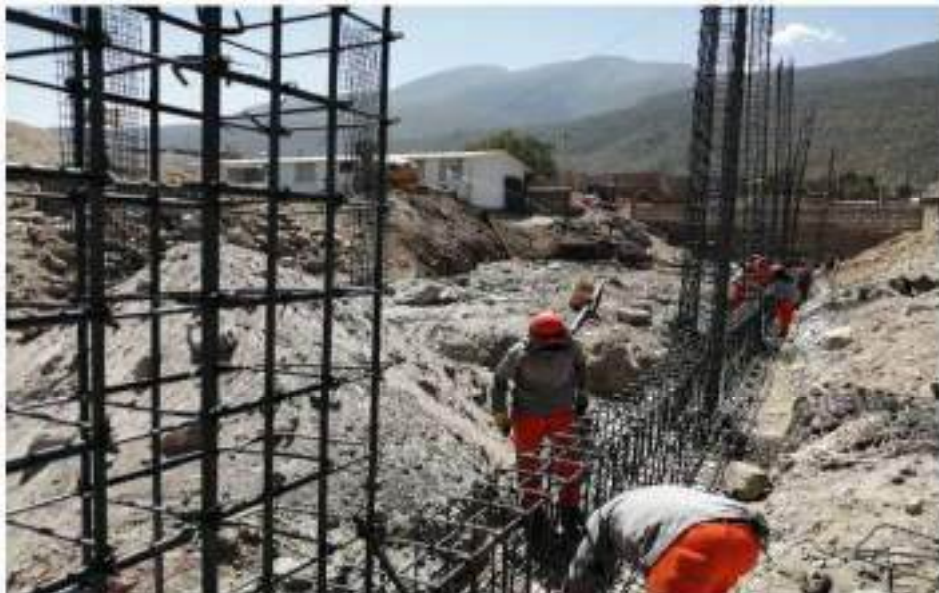
Figura 34. Habilitación y colocación de acero en zapatas y placas en bloque de comedores
