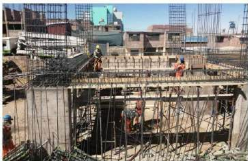
Figura 41. Acero y encofrado en vigas y losas en comedores
