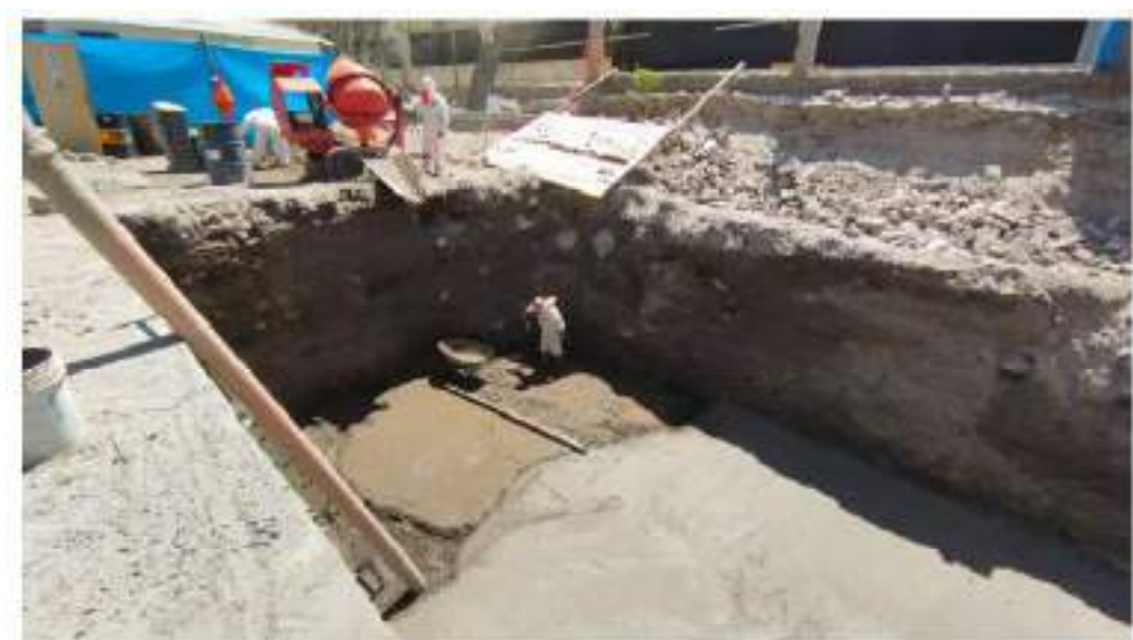
Figura 71. Solado en bases de cisterna y tanque elevado
