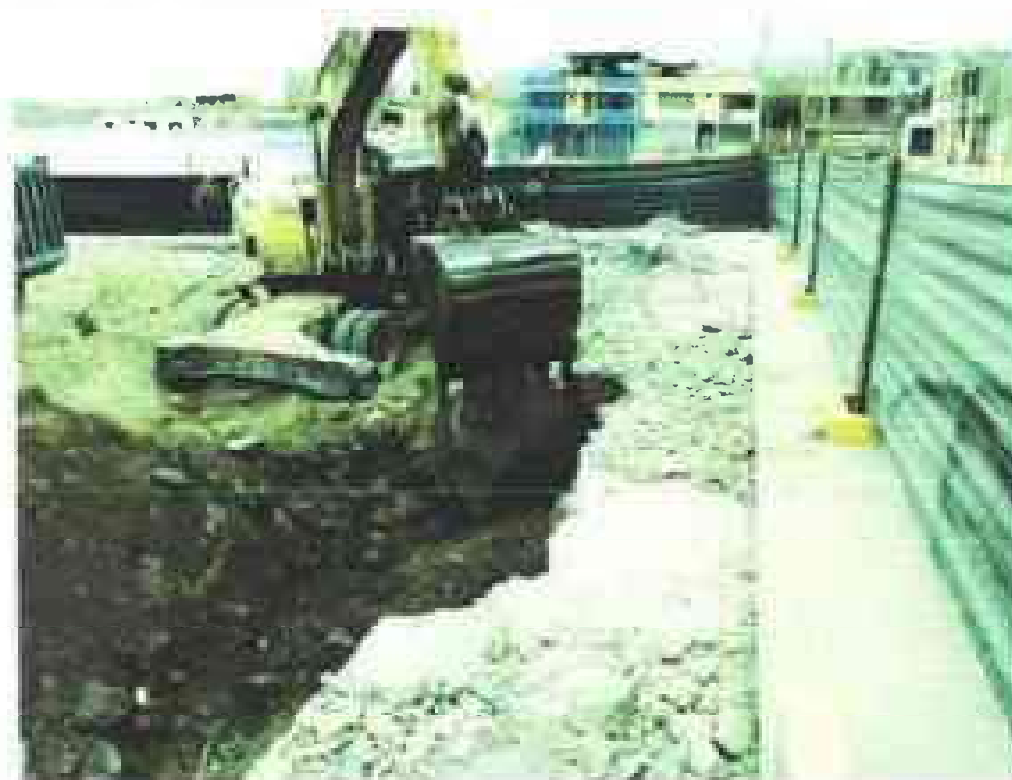
Fig. 14. Demolición de bloques de cimentación de bloque de aulas.
