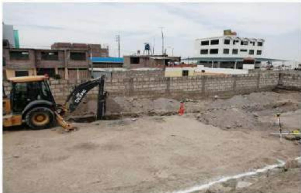
Figura 31. Excavación de zanjas para cimentación en bloque de comedores
