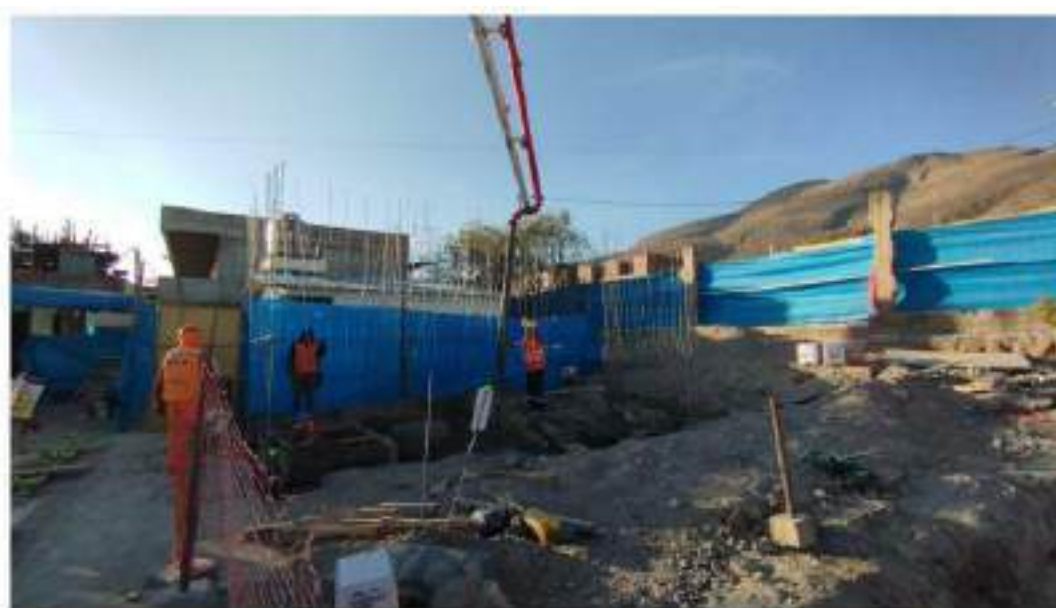
Figura 63. Concreto de cimiento de tópicos y guardianía
