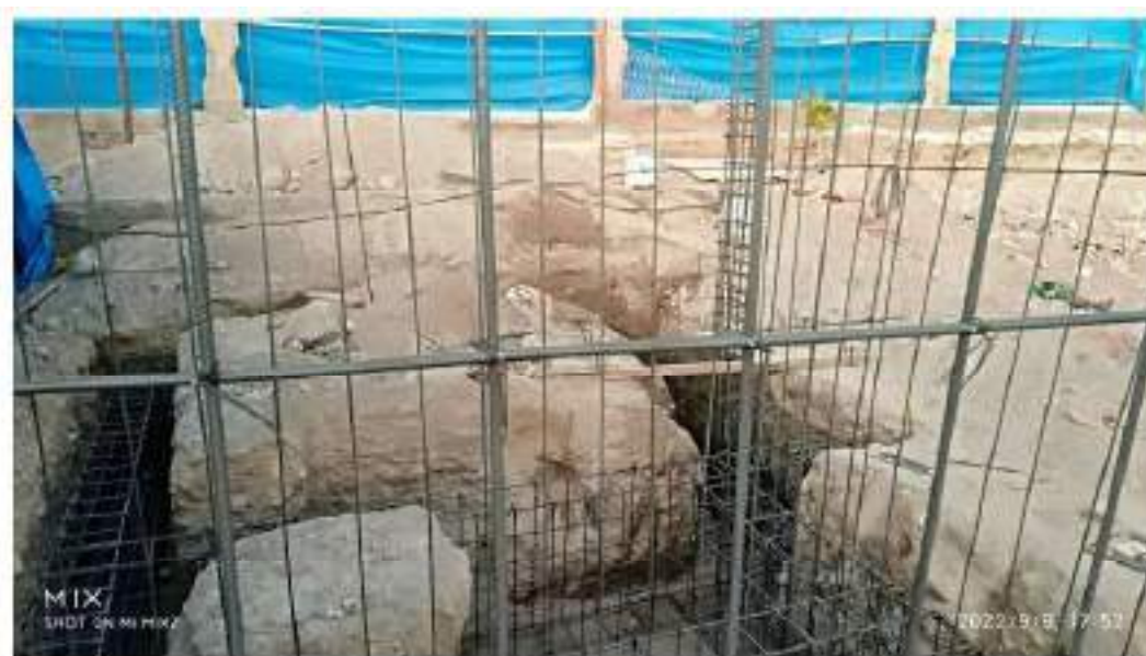
Figura 64. Acero en muros de tópicos y guardianía
