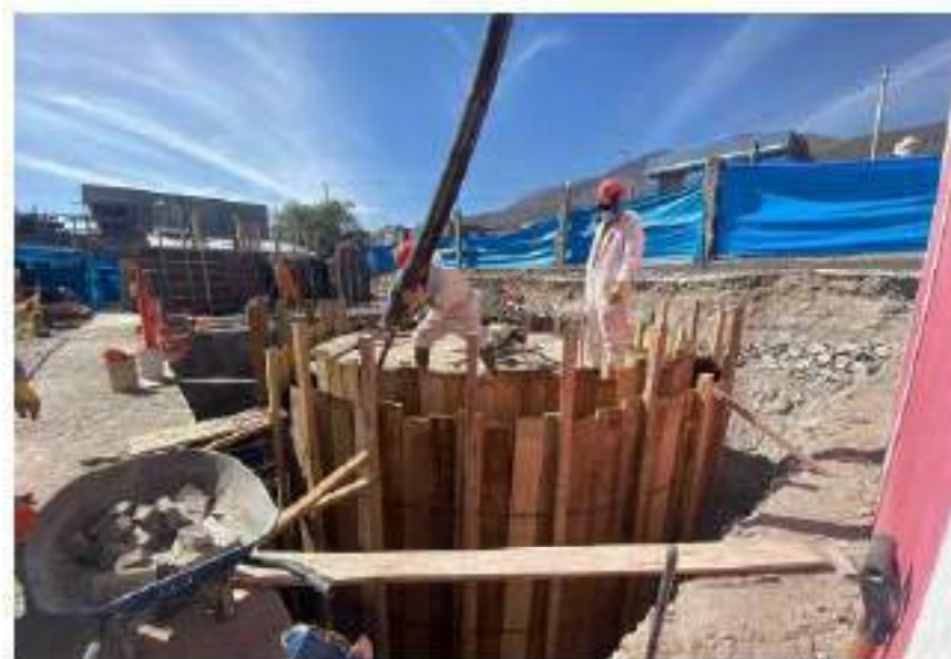
Figura 76. Concreto en muro de cisterna
