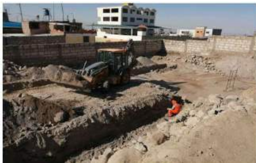
Figura 33. Acarreo y eliminación de material excedente en bloque de comedores
