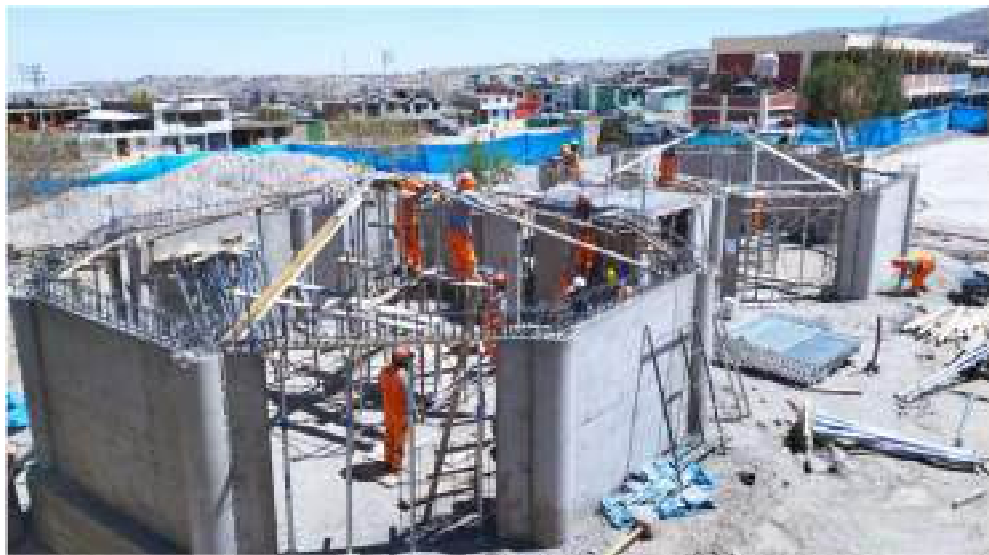
Figura 27. Proceso constructivo de aulas inicial 3, 4,5 años y aula psicomotricidad para el nivel primario
