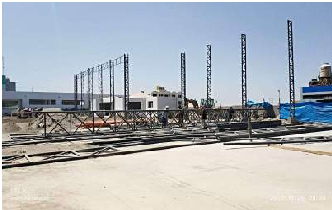
Figura 58. Suministro y armado de columnas, tijerales y crucetas metálicas
