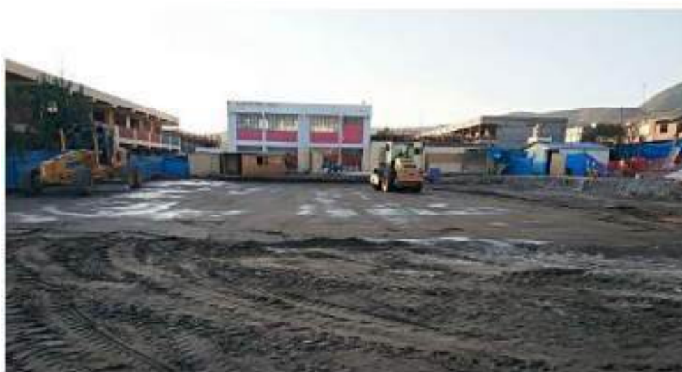
Figura 51. Compactación y nivelación de terreno en zona de losas deportivas
