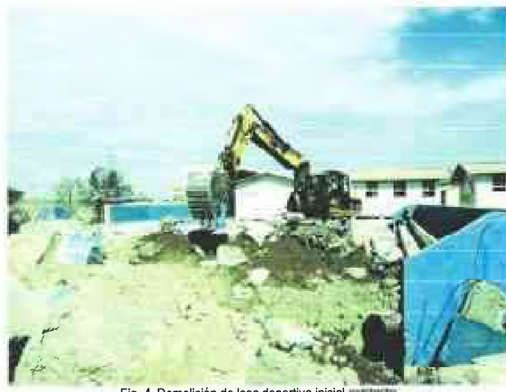
Fig. 4. Demolición de losa deportiva inicial
