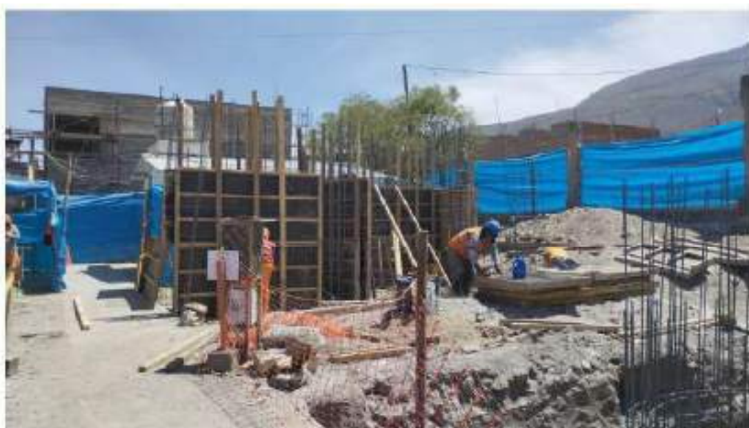
Figura 65. Encofrado de muros de tópicos y guardianía
