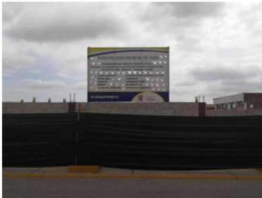
Figura 23. Cerco provisional de obra
