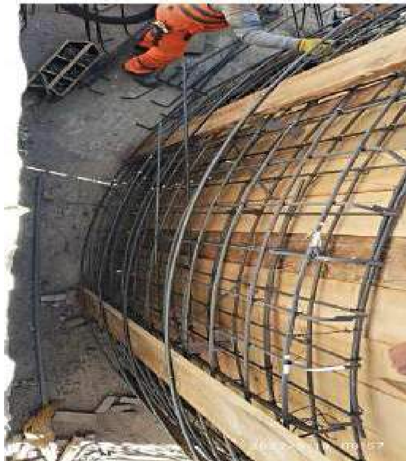
Figura 75. Encofrado de muro de cisterna
