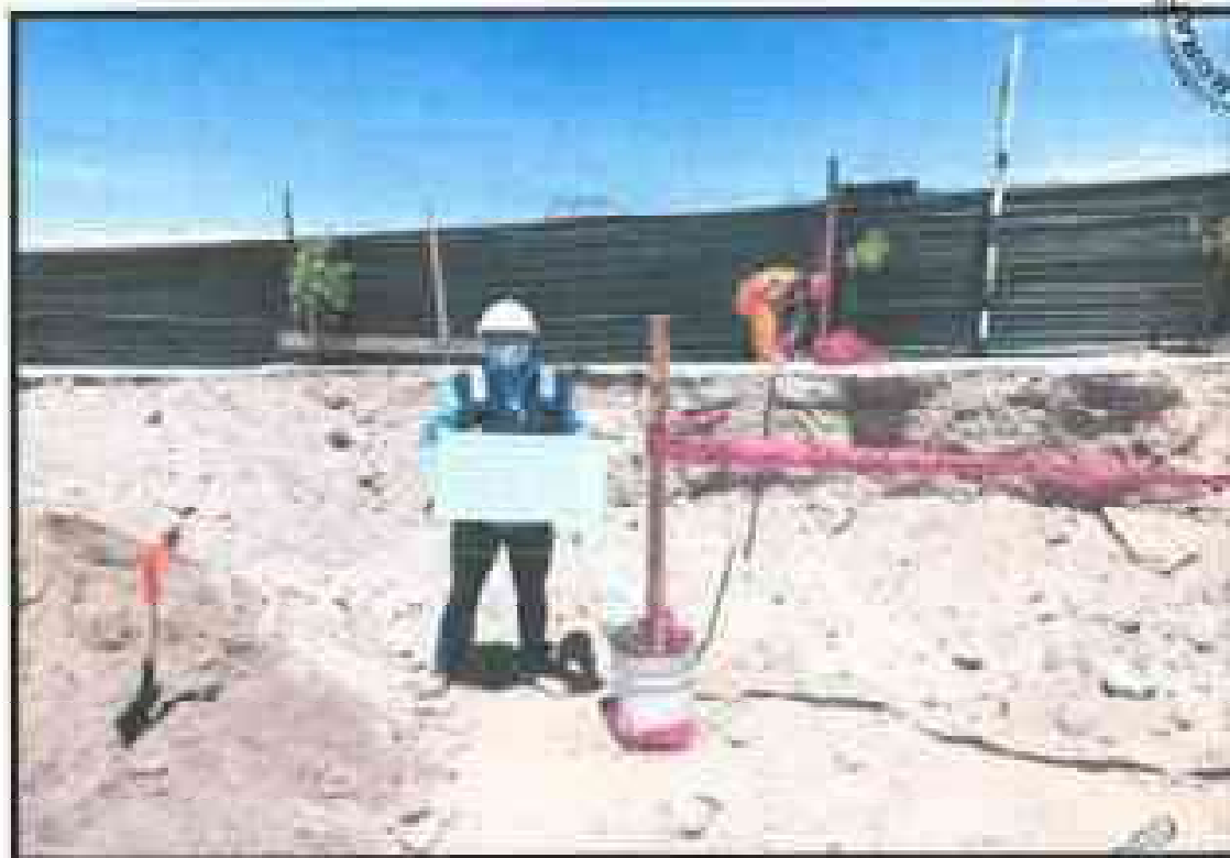
CALICATA 2, FOTO PANORAMICA
