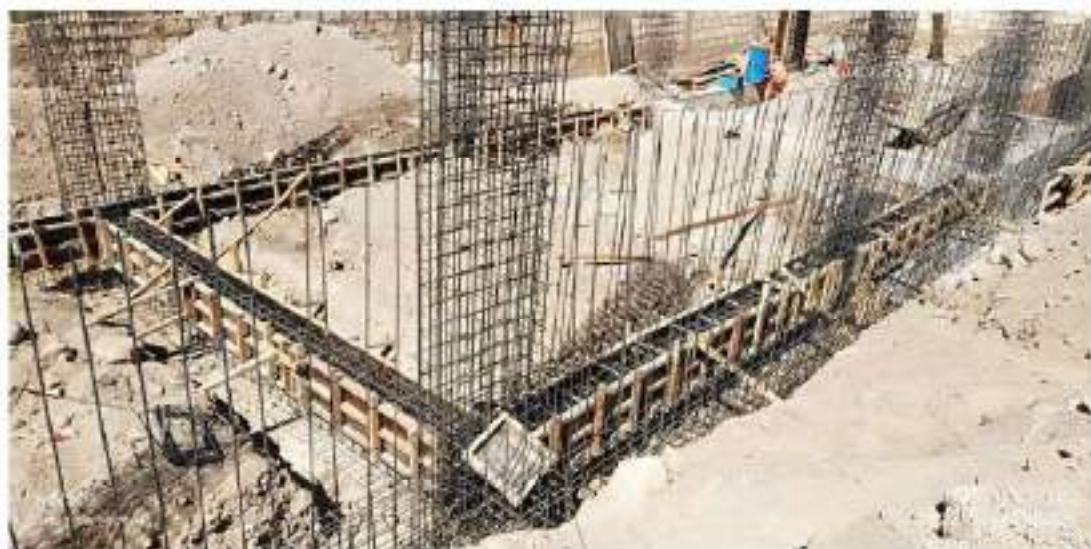
Figura 35. Habilitación y colocación de acero en vigas de cimentación en bloque de comedores
