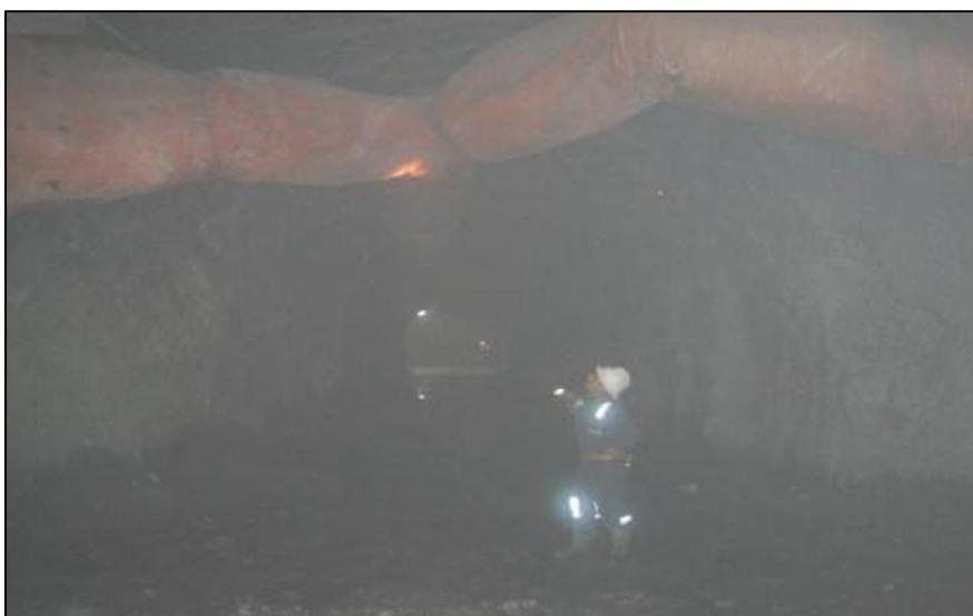
***Figura 8. Mangas de ventilación que proporcionan aire fresco a los frentes de trabajo***
